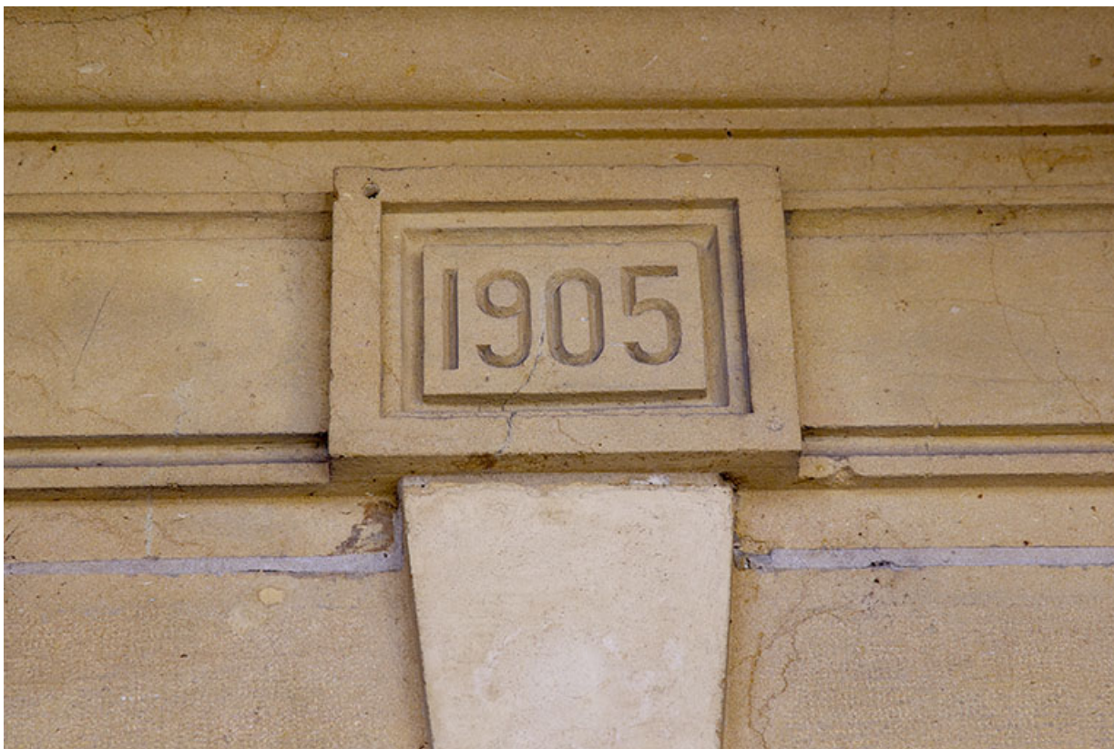
Façade antérieure : date 1905 portée sur le pan coupé.
