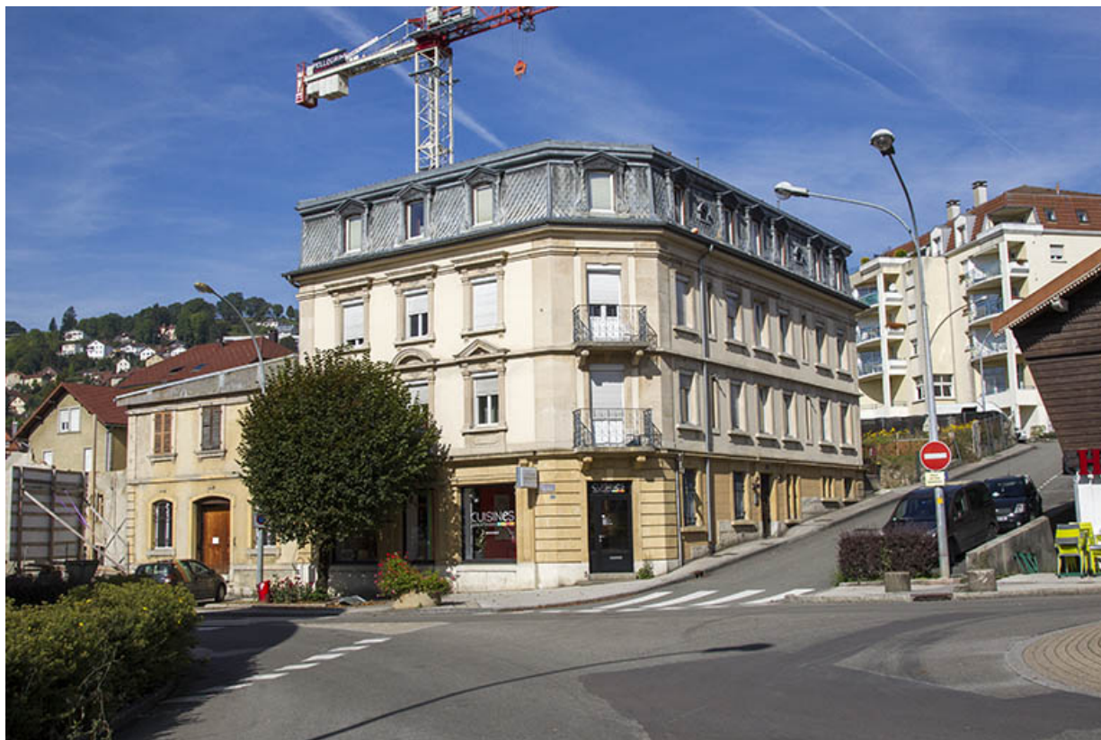
Façades antérieure et latérale droite.
