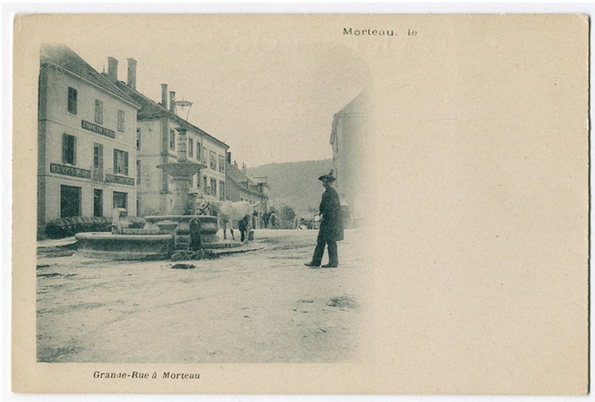
Grande-Rue à Morteau, 4e quart 19e siècle. Bâtiment 5 place Carnot à gauche, avec l'enseigne J. Panneton Frères. 25, Morteau, 11-13 rue René Payot
