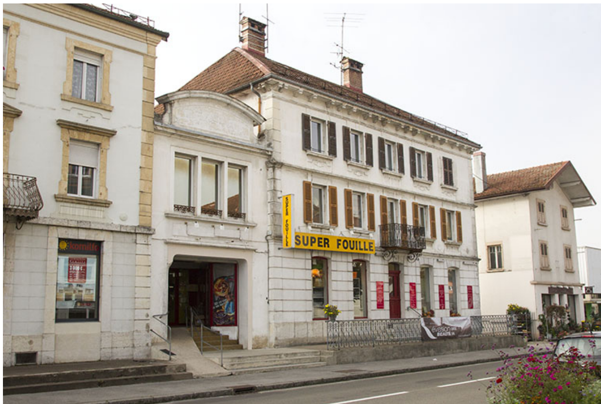
Porche et immeuble au n° 13, de trois quarts gauche. 25, Morteau, 11-13 rue René Payot
