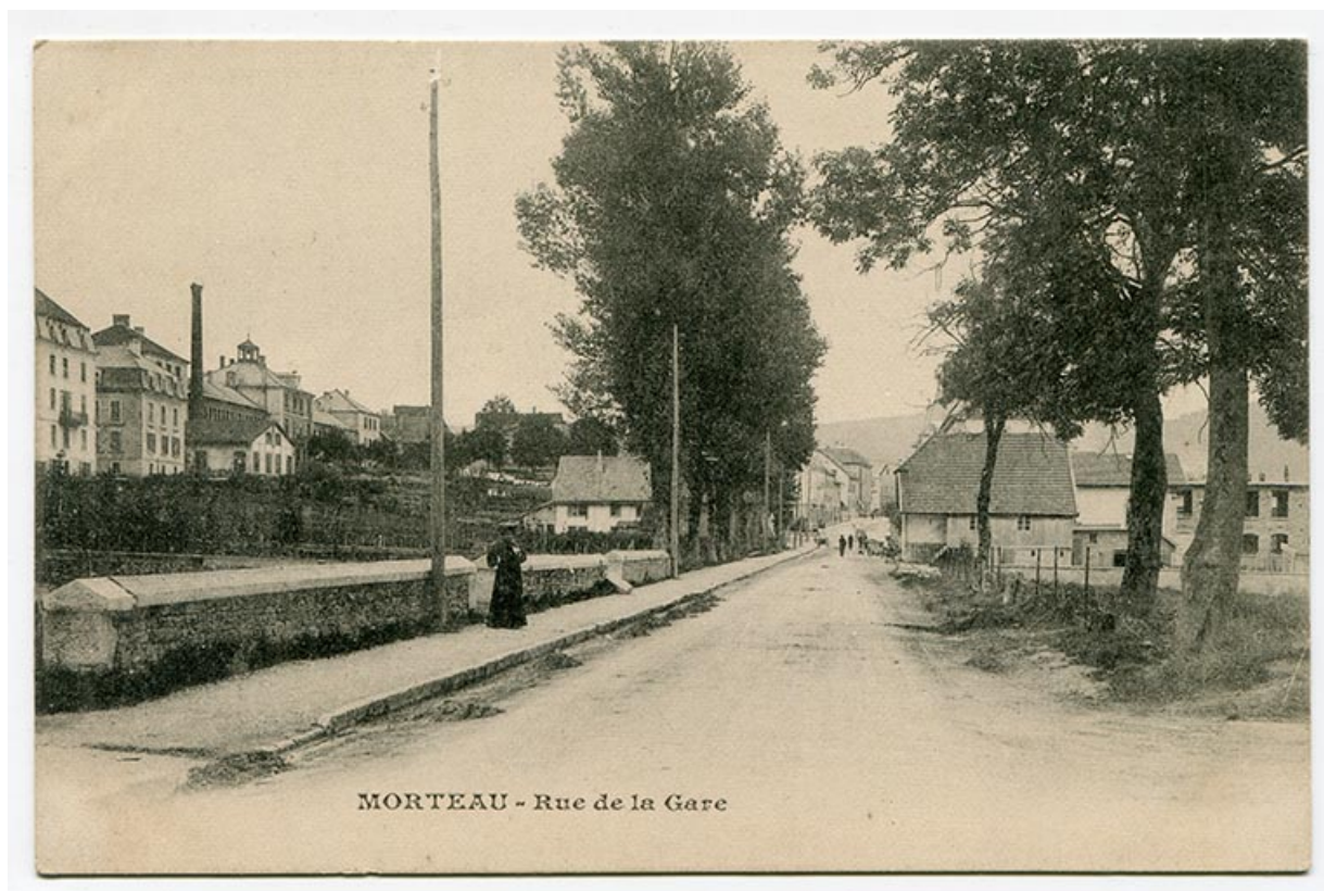
Morteau - Rue de la Gare, 4e quart 19e siècle [entre 1896 et 1899].
