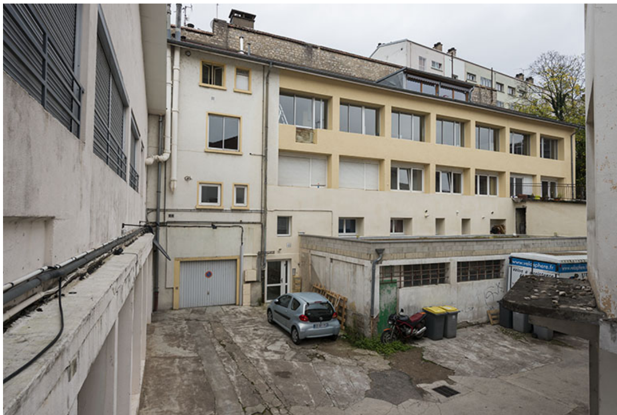
Façade ouest d'un atelier sur cour (4B). 25, Besançon, 4 à 7 rue des Chalets
