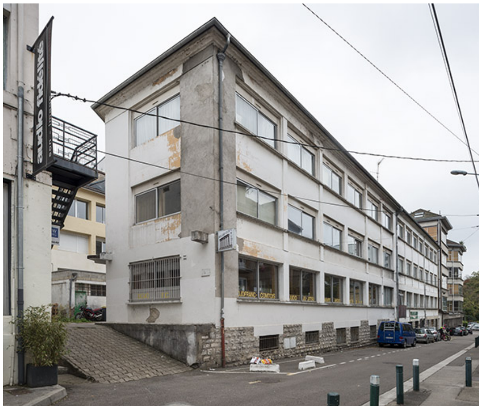
Vue de trois quarts gauche de l'atelier de fabrication (n°4).
