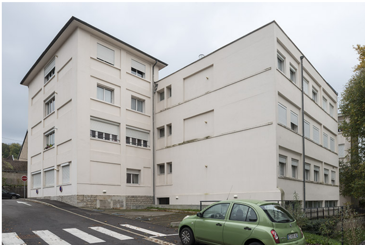
Vue de trois quarts arrière des ateliers (n°5 et 7).
