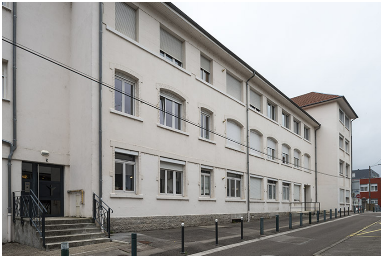
Atelier de fabrication vu de trois quarts gauche (n°5 et 7).
