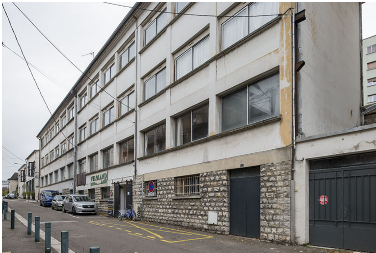
Vue d'ensemble de la rue depuis le sud-ouest. 25, Besançon, 4 à 7 rue des Chalets
