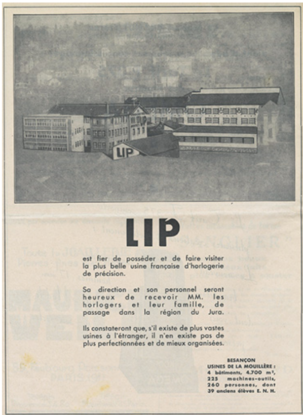
Vue cavalière de l'usine Lip, 1935. 25, Besançon, 4 à 7 rue des Chalets
