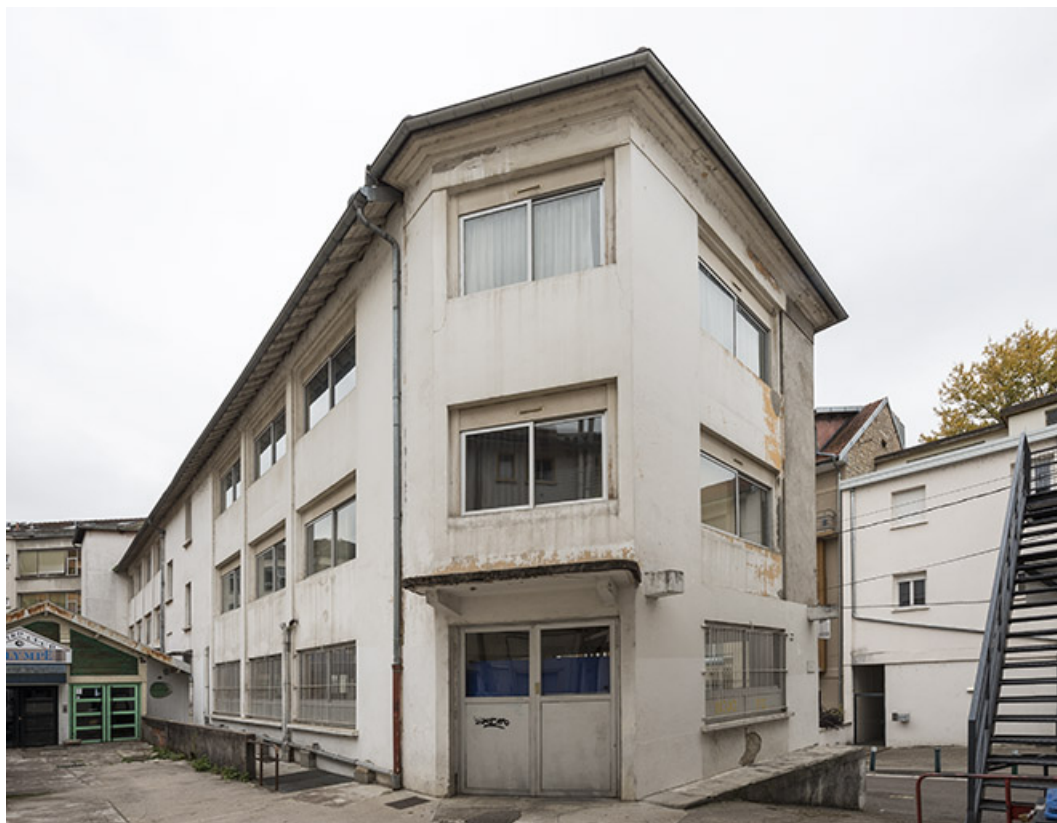
Façade sur cour d'un atelier de fabrication (n°4). 25, Besançon, 4 à 7 rue des Chalets
