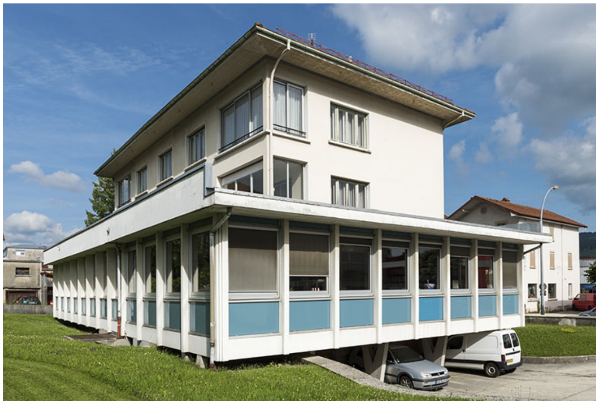
Façade latérale gauche, de trois quarts gauche. 25, Morteau, 12 rue René Payot
