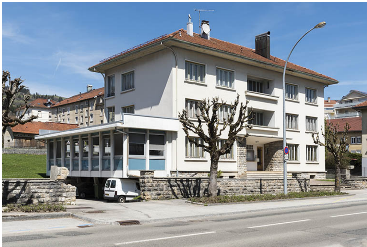
Vue d'ensemble, depuis le sud. 25, Morteau, 12 rue René Payot
