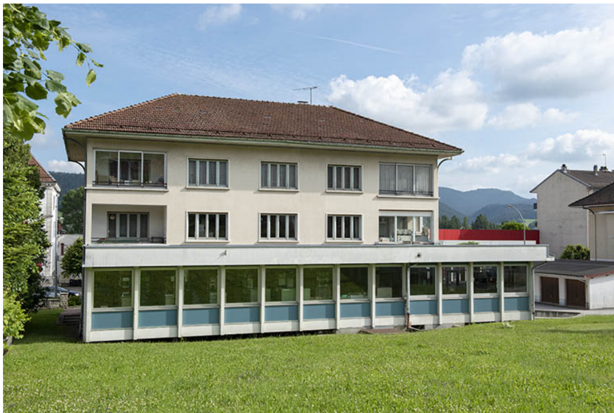
Façade postérieure, de trois quarts gauche. 25, Morteau, 12 rue René Payot
