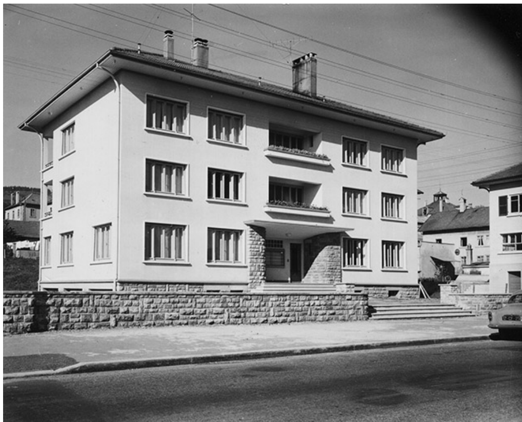
[Le bâtiment, vue de trois quarts gauche], vers 1955. 25, Morteau, 12 rue René Payot
