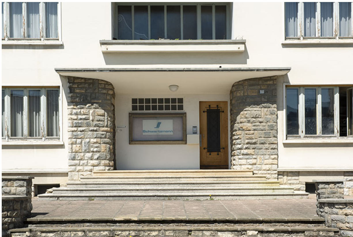
Façade antérieure : entrée.
