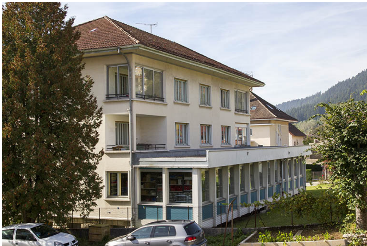
Façade postérieure, vue en enfilade. 25, Morteau, 12 rue René Payot
