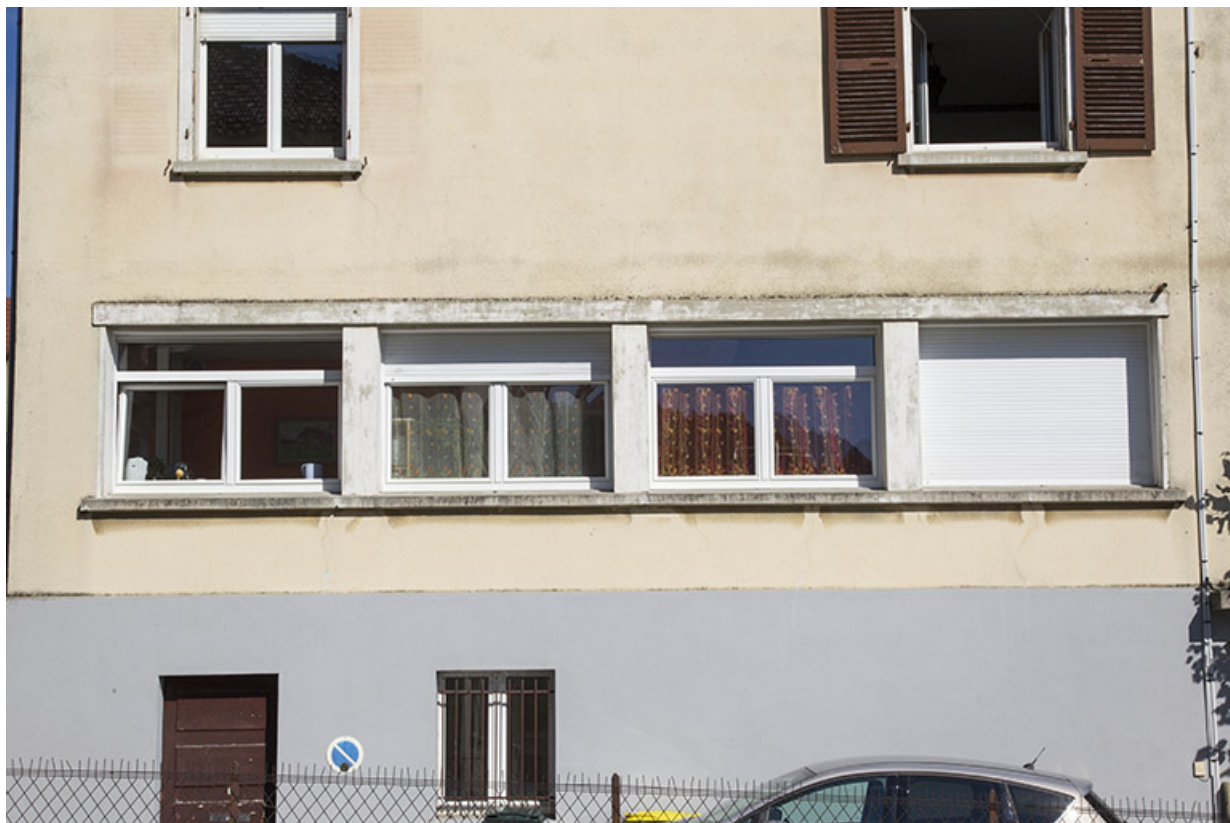
Façade latérale gauche : fenêtres d'atelier.
