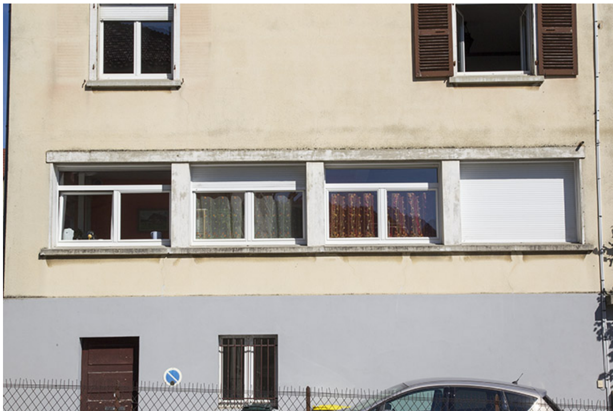
Façade latérale gauche : fenêtres d'atelier.
