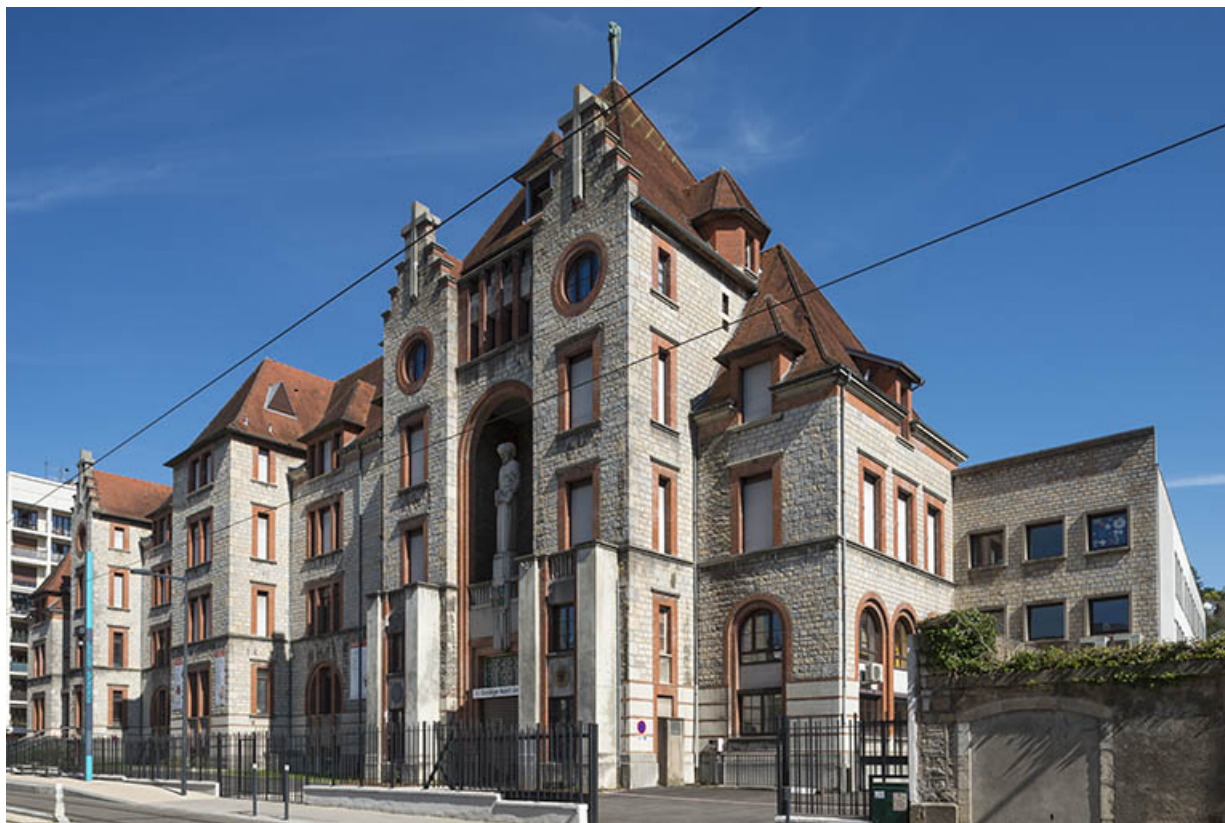
Façade antérieure du lycée. Vue de trois quarts droite. 25, Besançon, 28 avenue Fontaine-Argent
