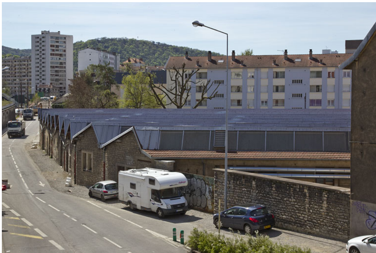
Atelier de fabrication boulevard Diderot : vue d'ensemble depuis le nord. 25, Besançon, 28 avenue Fontaine-Argent
