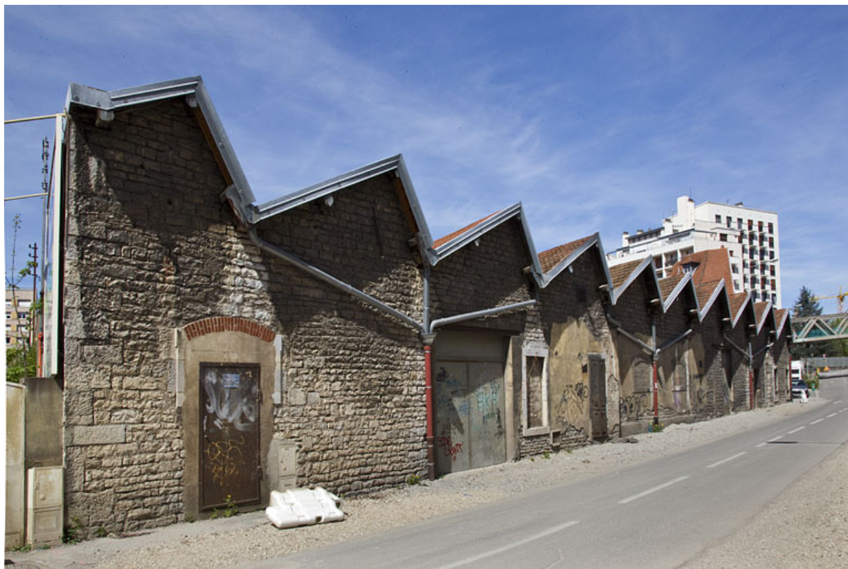
Atelier de fabrication boulevard Diderot : façade sur le boulevard, depuis le sud. 25, Besançon, 28 avenue Fontaine-Argent
