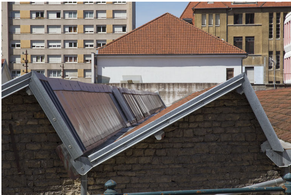
Atelier de fabrication boulevard Diderot : détail des sheds.
