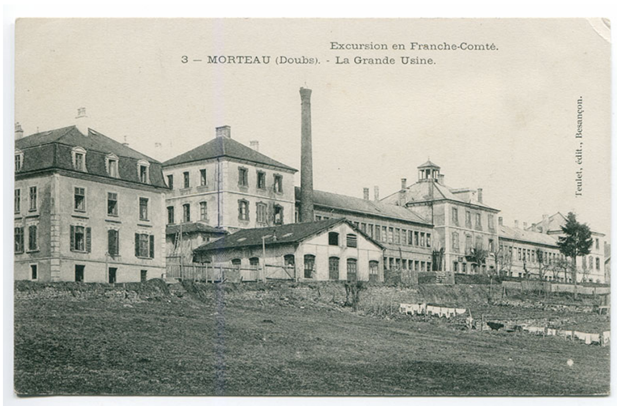
Excursion en Franche-Comté. 3 - Morteau (Doubs). - La Grande Usine, 1er quart 20e siècle. 25, Morteau
