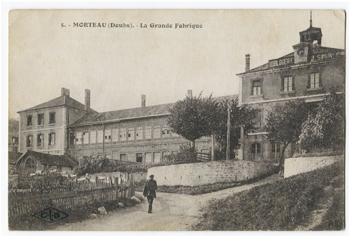
5. - Morteau (Doubs). La Grande Fabrique, 1er quart 20e siècle. 25, Morteau
