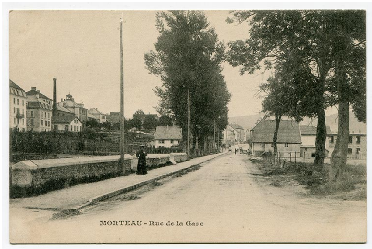
Morteau - Rue de la Gare, 4e quart 19e siècle [entre 1896 et 1899]. 25, Morteau, 13 rue Pasteur
