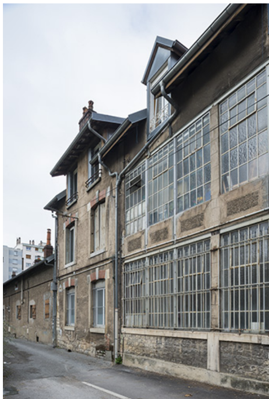
Façades d'ateliers ruelle de la Mouillère (cadrage vertical).
