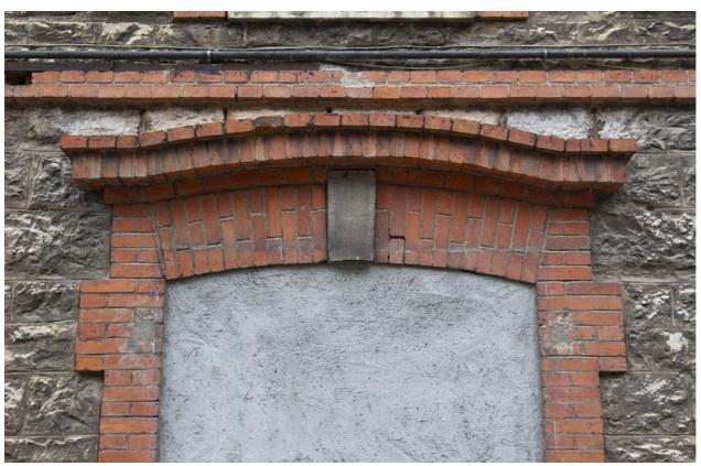
Atelier en pierre au n° 14B : arc en briques couvrant une porte murée de la façade latérale droite.
