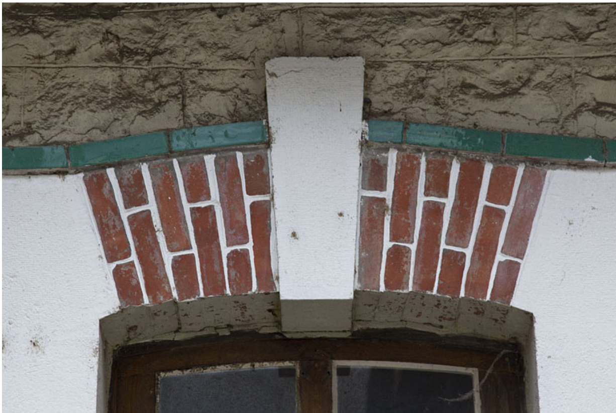
Atelier face à celui du n° 14B : arc en briques couvrant une baie de la façade antérieure.
