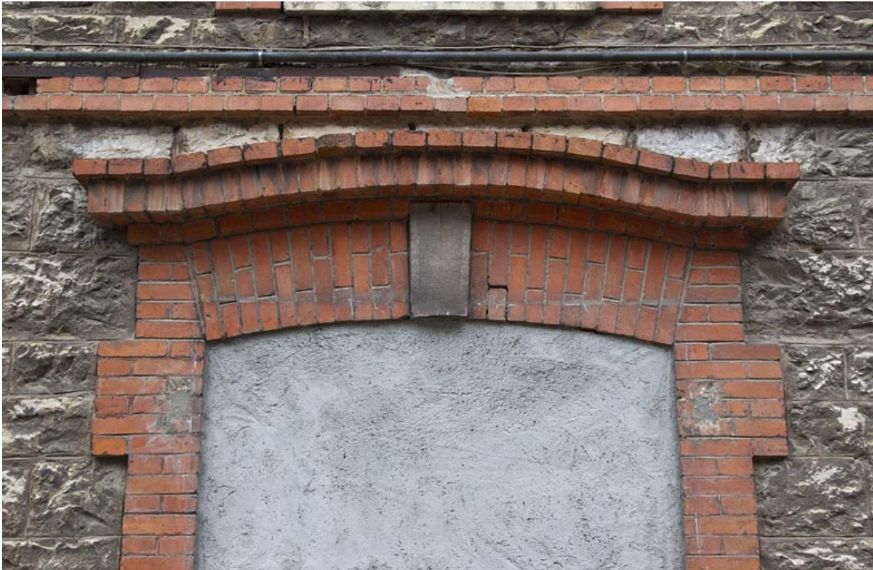
Atelier en pierre au n° 14B : arc en briques couvrant une porte murée de la façade latérale droite. 25, Besançon, 14 avenue Fontaine-Argent
