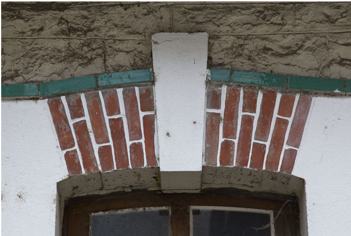
Atelier face à celui du n° 14B : arc en briques couvrant une baie de la façade antérieure.
