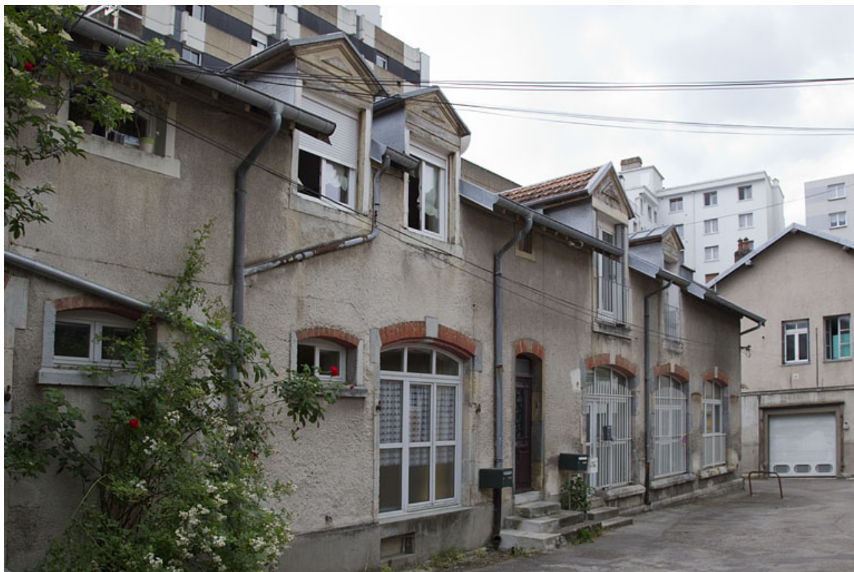
Atelier dans le prolongement au sud de celui en béton (13B rue de la Mouillère) : façade antérieure, de trois quarts gauche. 25, Besançon, 14 avenue Fontaine-Argent
