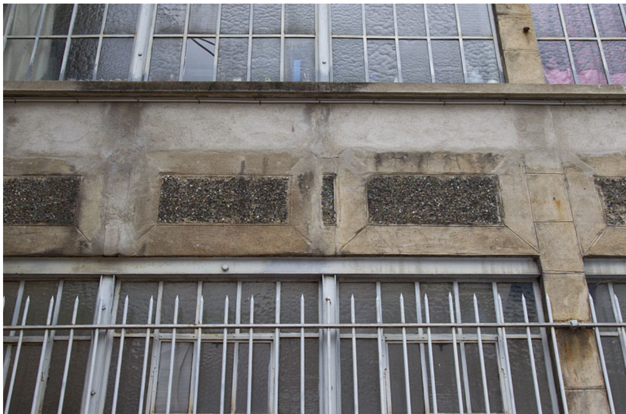
Atelier en béton au n° 14B : décor des allèges de la façade antérieure.
