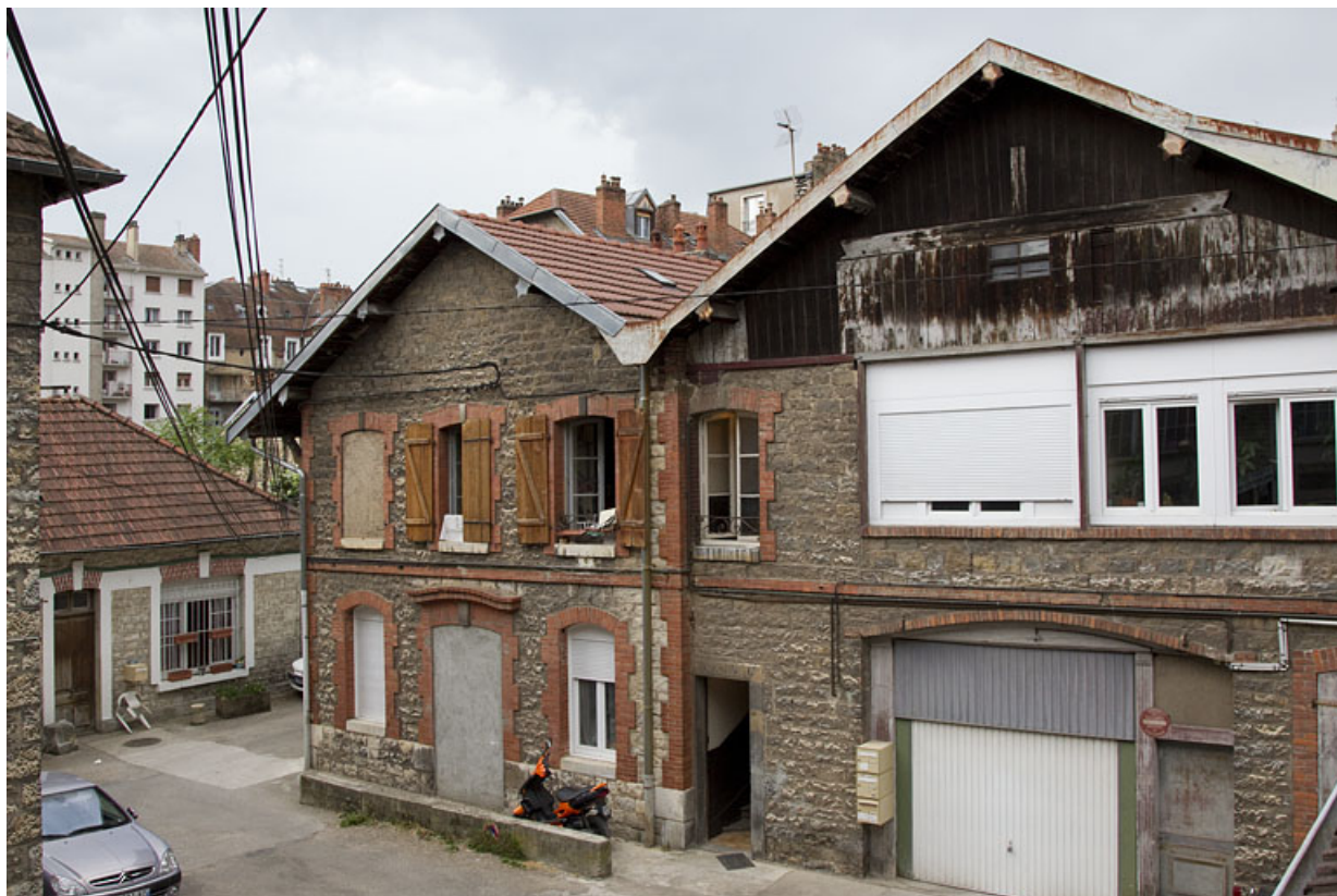
Atelier en pierre au n° 14B : façade latérale droite.
