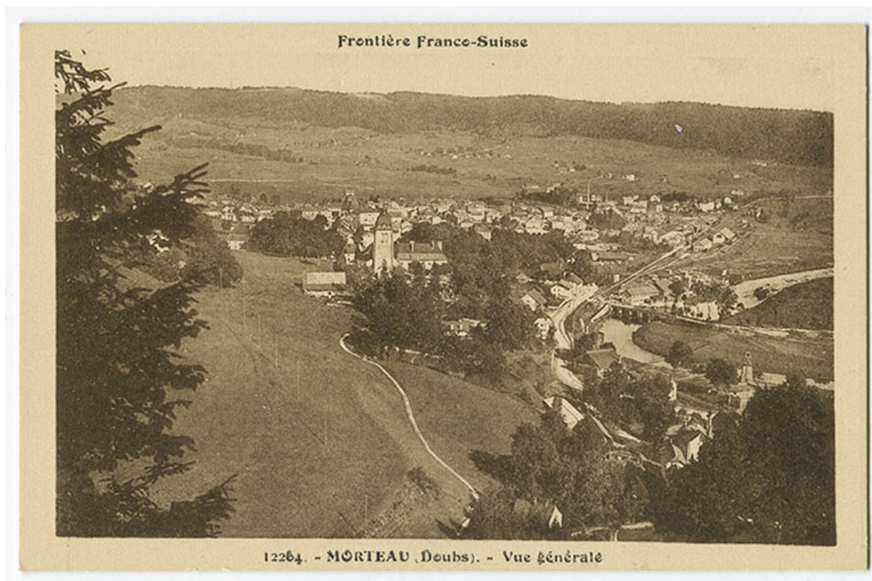
Frontière franco-suisse. 12264. - Morteau (Doubs). - Vue générale [depuis la Table du Roi, à l'ouest], milieu 20e siècle. 25, Morteau, 1 rue du Pont rouge
