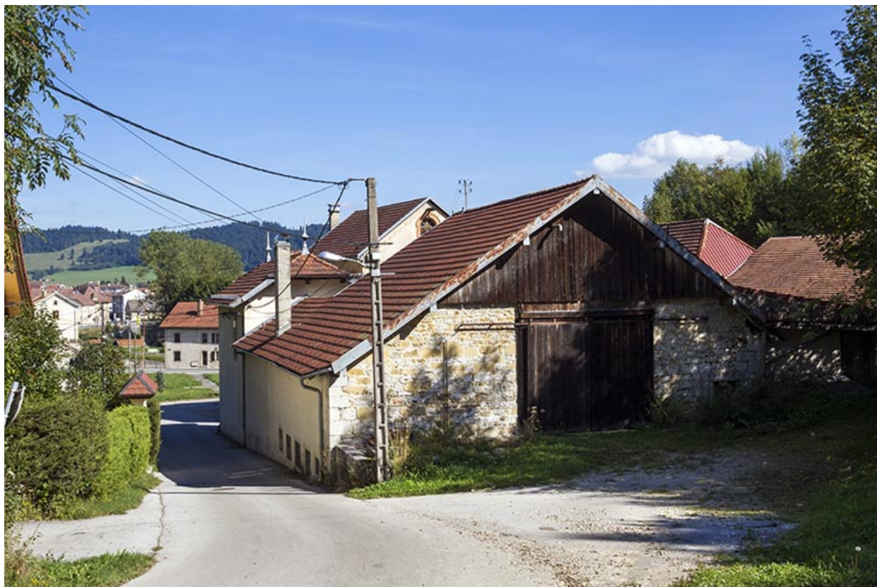
Bureau, écurie et grange, depuis l'ouest.
