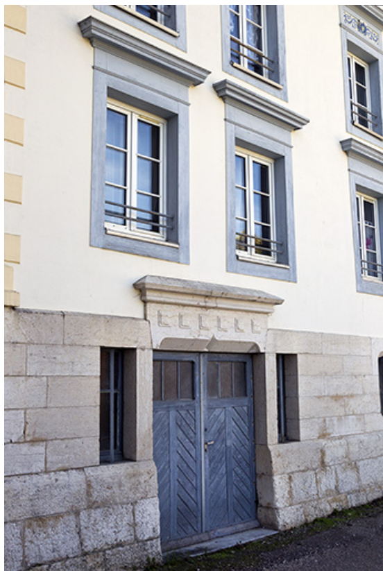
Premier atelier de fabrication, façade latérale gauche : porte au rez-de-chaussée. 25, Morteau, 1-4 rue de la Brasserie
