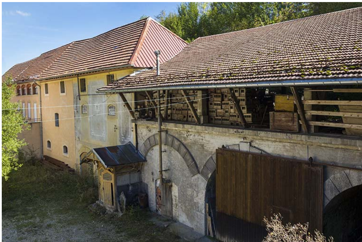
Entrepôt industriel (extrémité occidentale) et magasin industriel.
