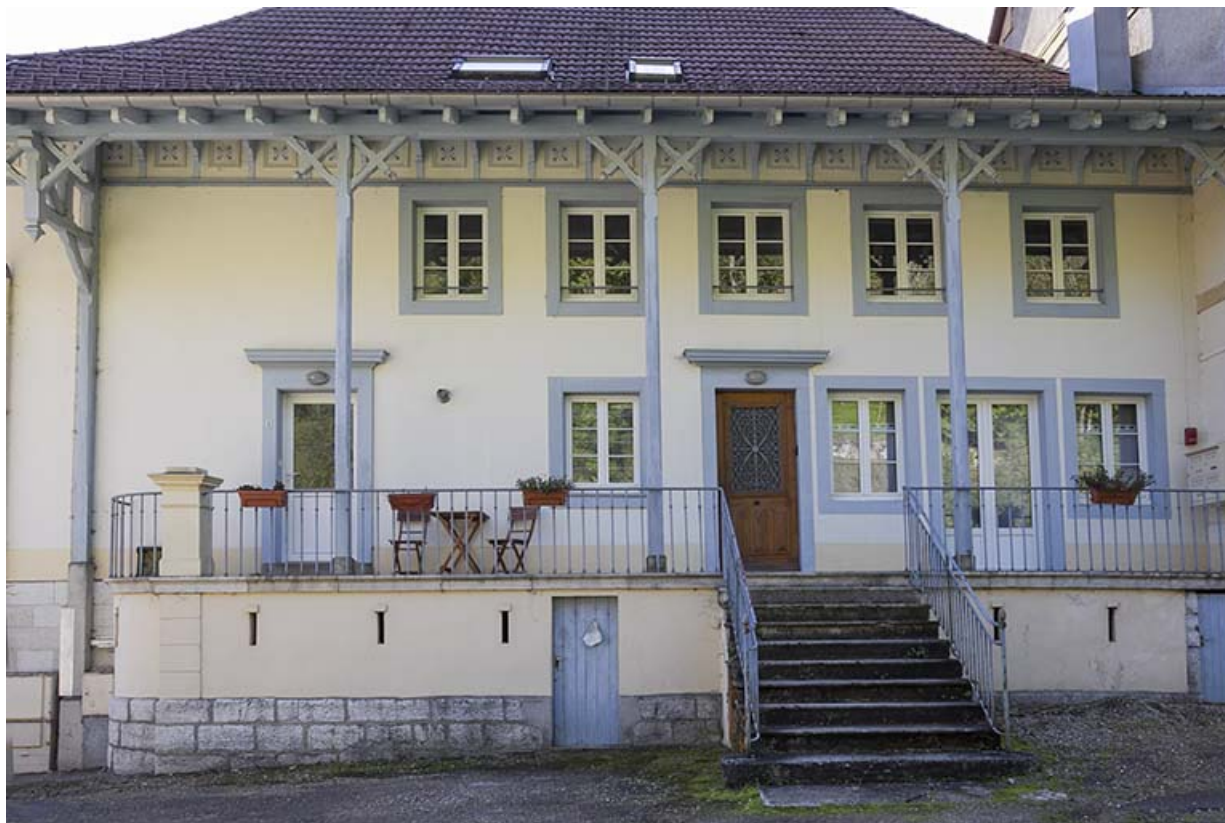
Premier atelier de fabrication : façade antérieure.
