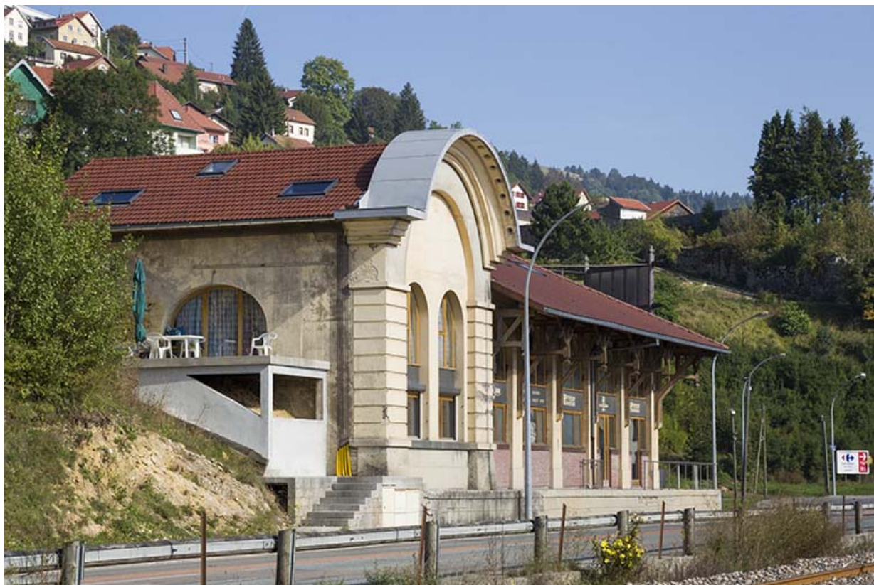
Ateliers de traitement des fûts (à gauche) et de conditionnement : façade orientale, vue en enfilade. 25, Morteau, 1-4 rue de la Brasserie
