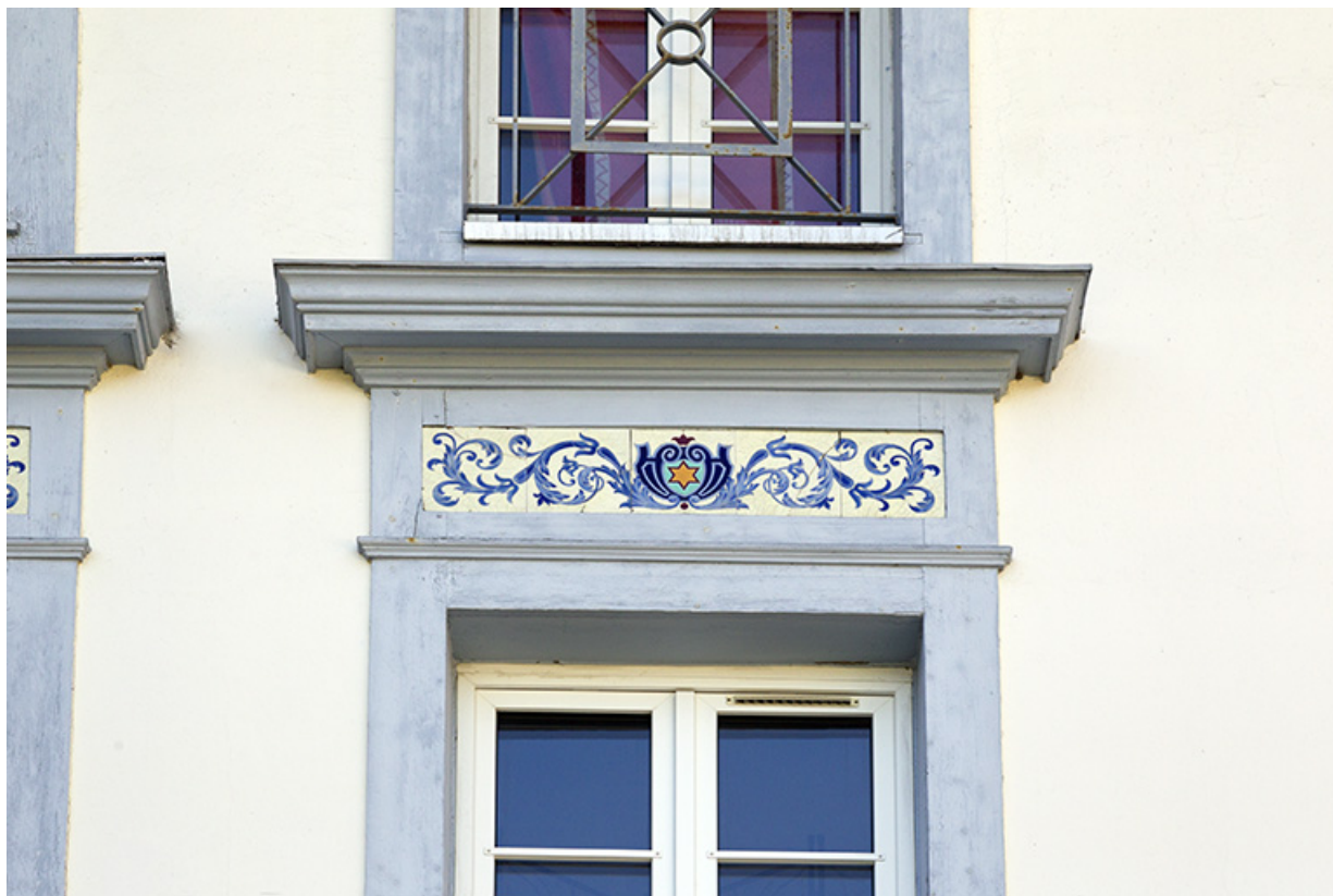
Premier atelier de fabrication, façade latérale gauche : décor entre deux fenêtres. 25, Morteau, 1-4 rue de la Brasserie
