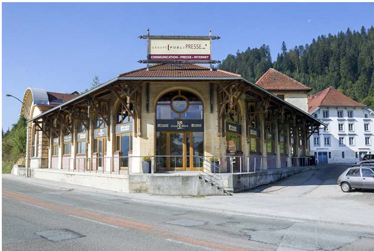
Atelier de conditionnement et quai. 25, Morteau, 1-4 rue de la Brasserie
