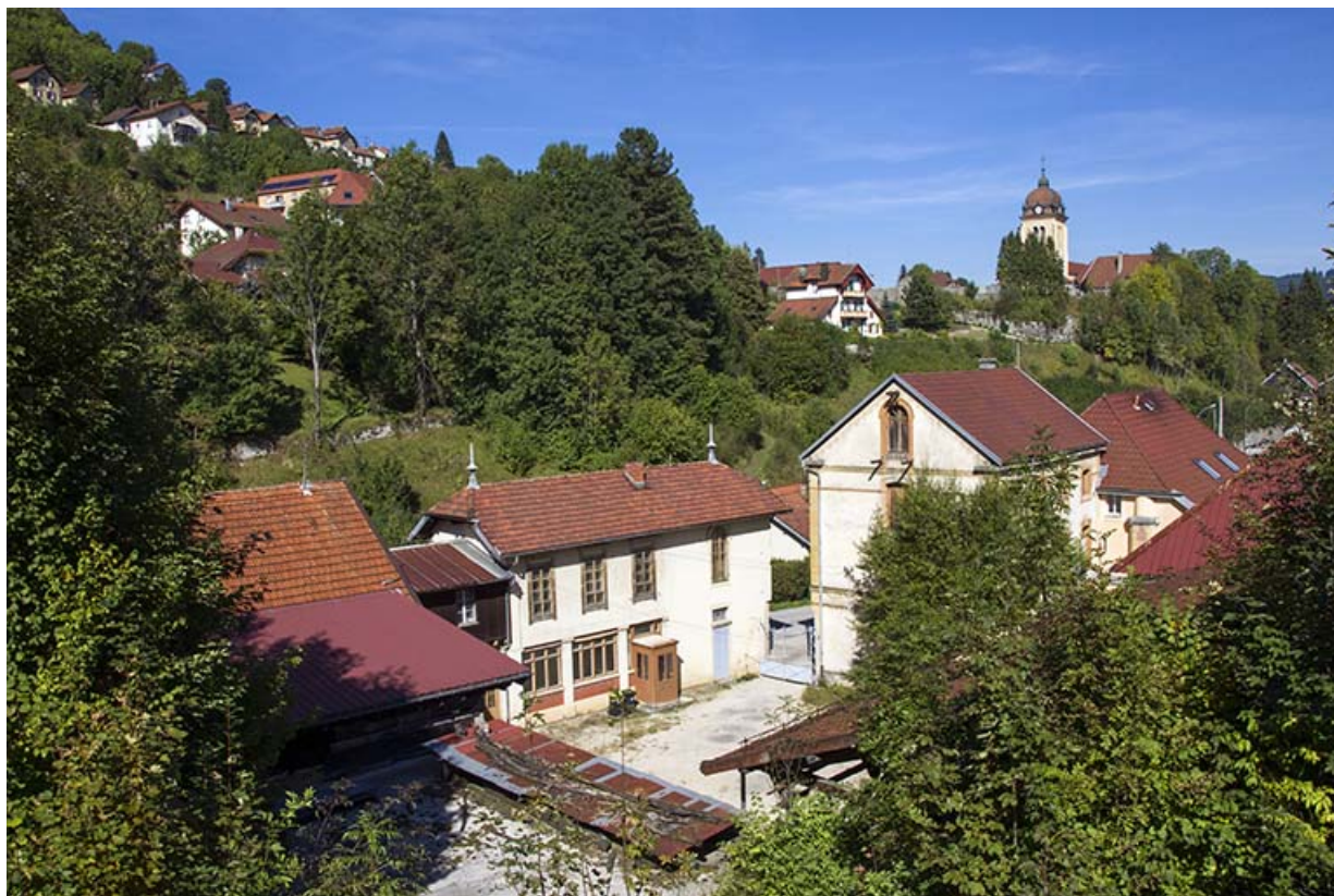
Vue d'ensemble plongeante, depuis le sud.
