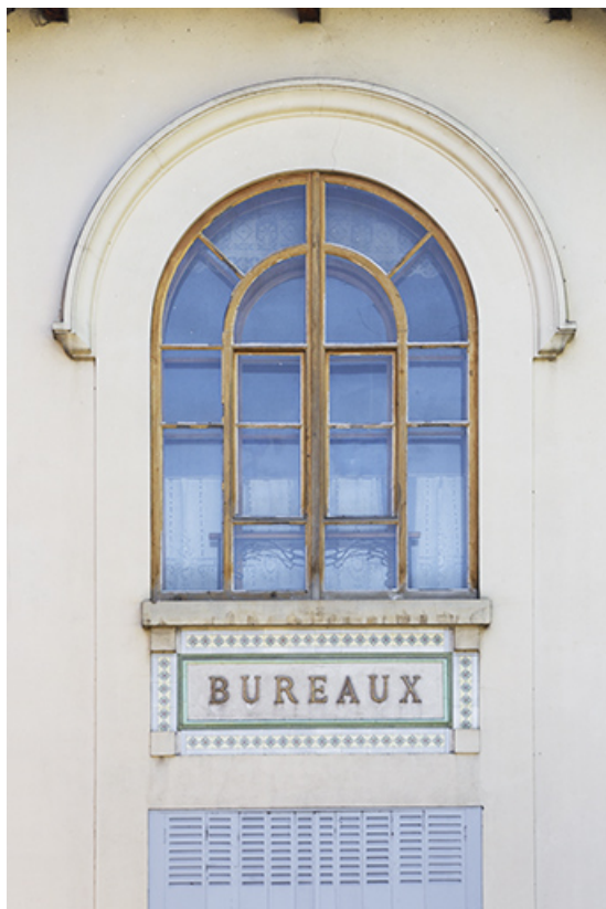
Bureau et laboratoire : fenêtre du premier étage. 25, Morteau, 1-4 rue de la Brasserie
