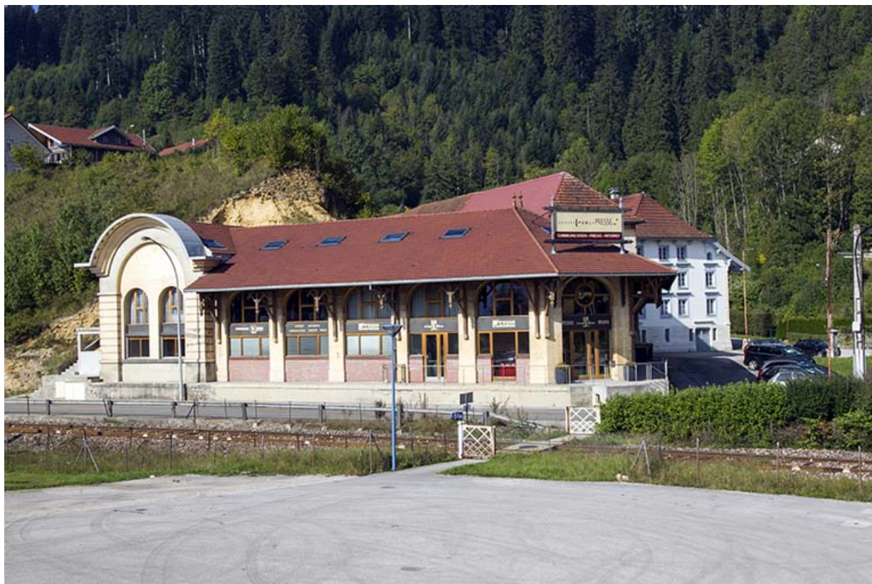
Atelier de conditionnement, depuis l'est. 25, Morteau, 1-4 rue de la Brasserie
