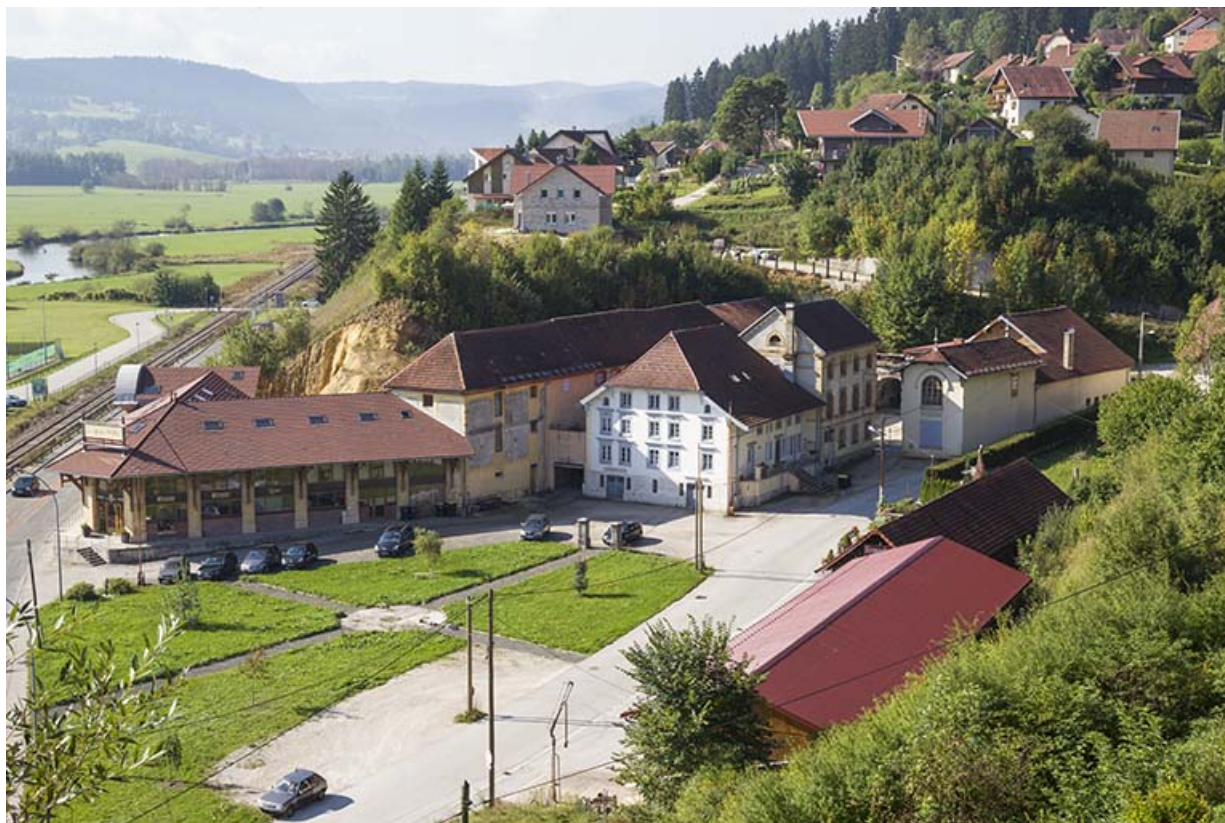
Vue d'ensemble plongeante, depuis le nord. 25, Morteau, 1-4 rue de la Brasserie
