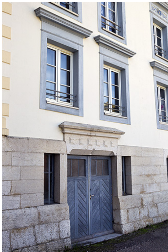
Premier atelier de fabrication, façade latérale gauche : porte au rez-de-chaussée. 25, Morteau, 1-4 rue de la Brasserie
