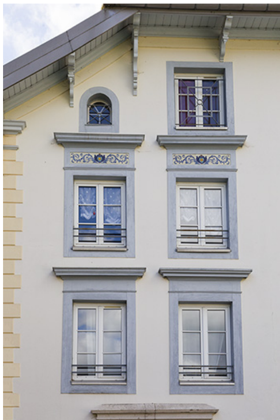
Premier atelier de fabrication, façade latérale gauche : fenêtres et décor. 25, Morteau, 1-4 rue de la Brasserie
