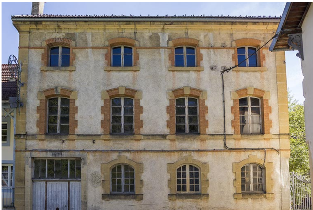
Deuxième atelier de fabrication : façade antérieure.
