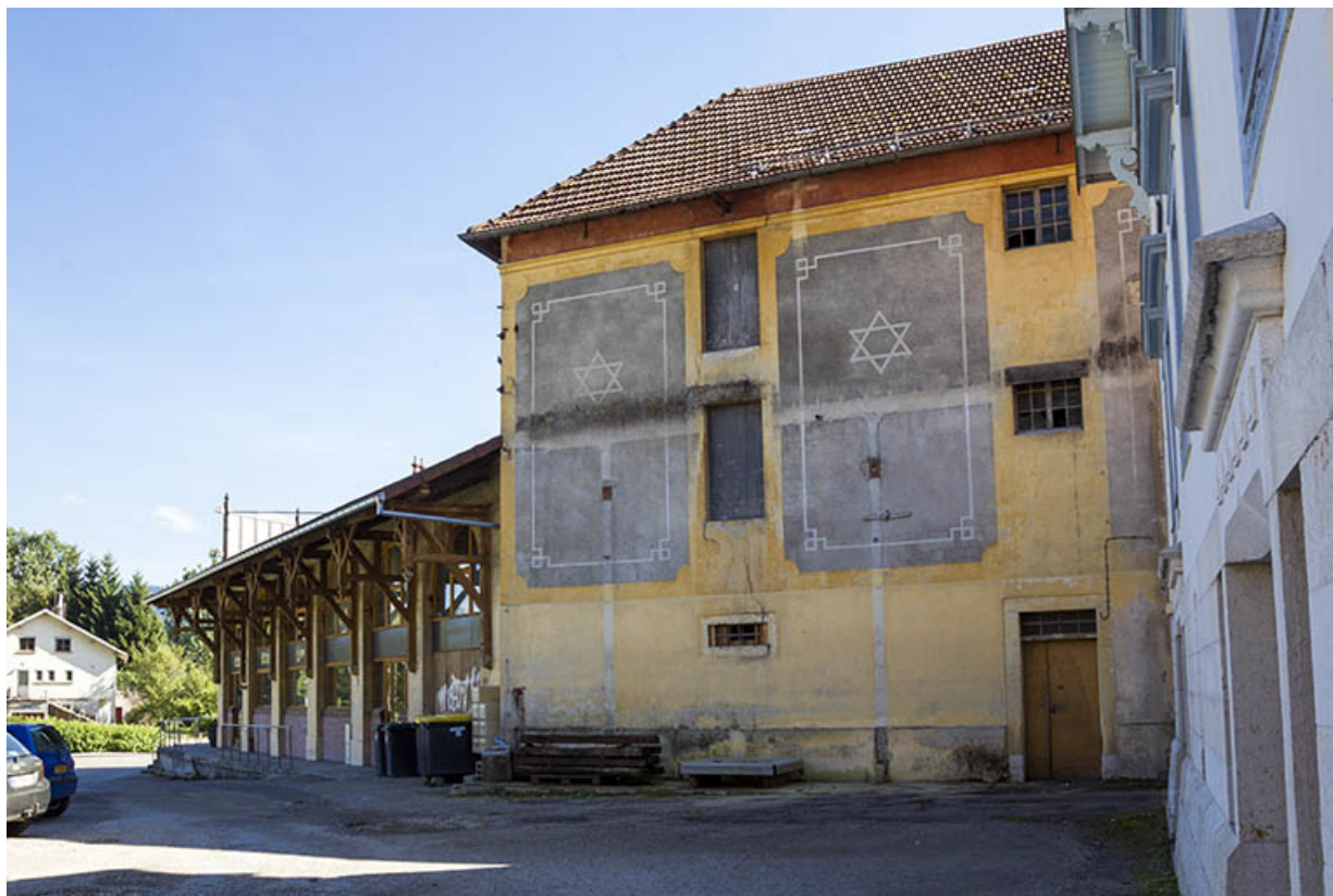
Entrepôt industriel : extrémité orientale, entre l'atelier de conditionnement (à gauche) et le premier atelier de fabrication (à droite). 25, Morteau, 1-4 rue de la Brasserie
