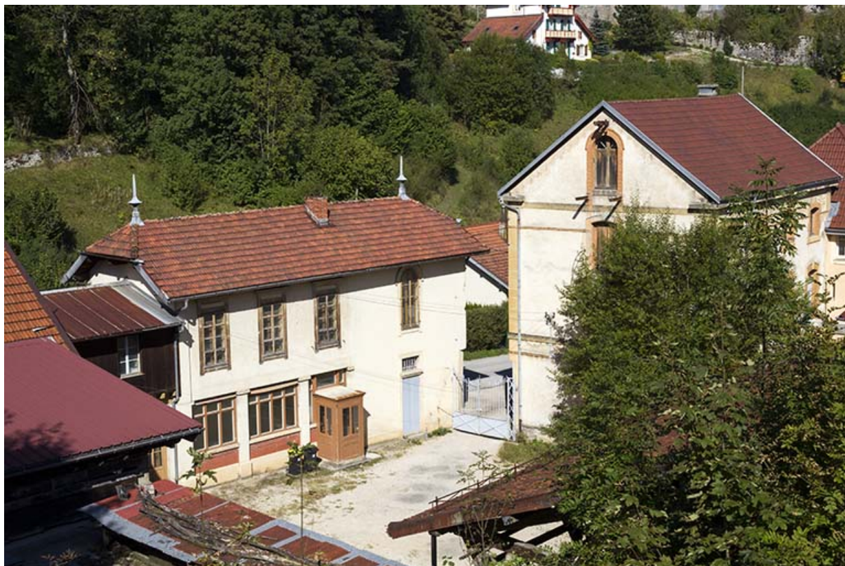
Bureau et laboratoire : façade sur cour.
