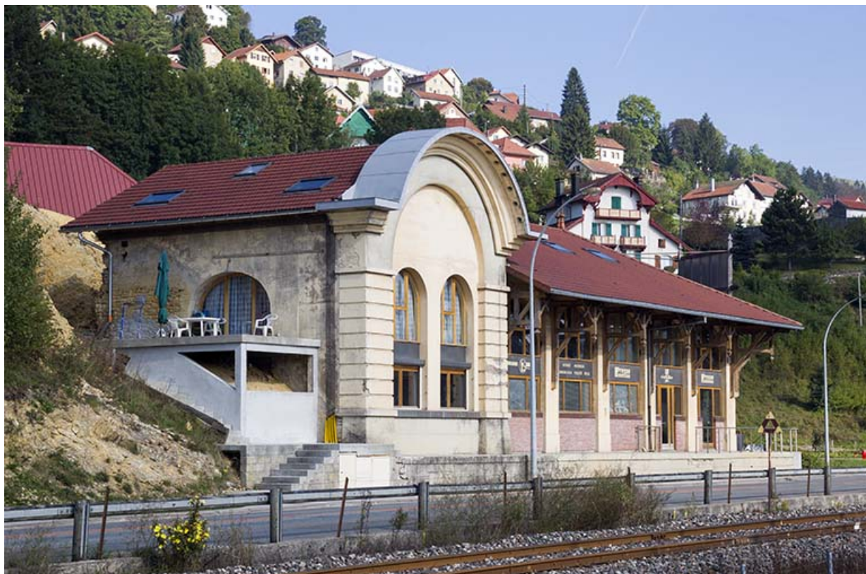
Ateliers de traitement des fûts (à gauche) et de conditionnement : façade orientale, de trois quarts gauche. 25, Morteau, 1-4 rue de la Brasserie
