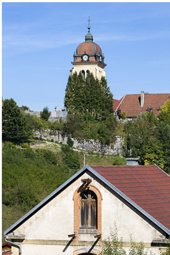
Deuxième atelier de fabrication : pignon occidental. 25, Morteau, 1-4 rue de la Brasserie
