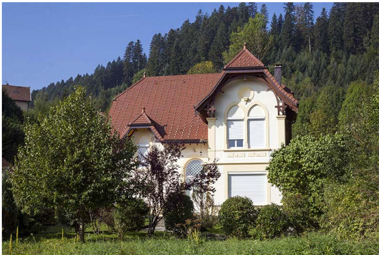
Logement patronal : façade occidentale.
