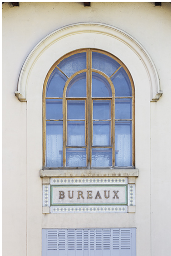
Bureau et laboratoire : fenêtre du premier étage. 25, Morteau, 1-4 rue de la Brasserie
