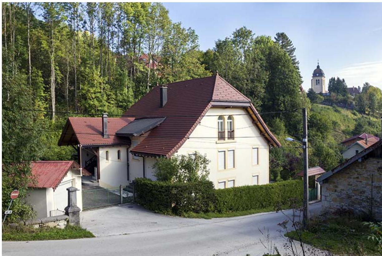
Logement patronal (ancienne ferme), vu du sud-ouest. 25, Morteau, 1-4 rue de la Brasserie
