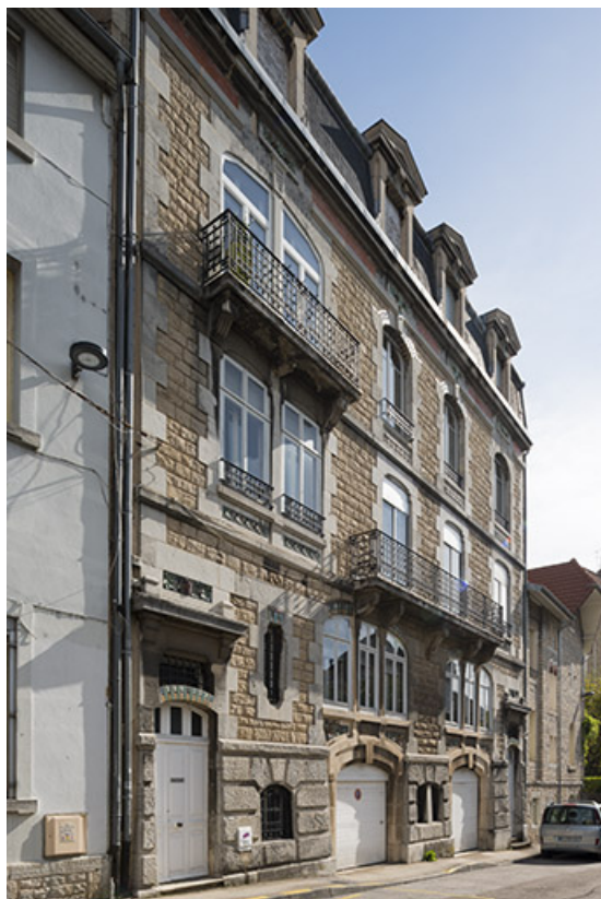
Façade de l'immeuble (entrées 14 bis et ter) vue de trois quarts gauche. 25, Besançon, 14 ter rue des Villas
