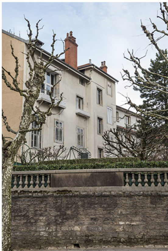
Façade postérieure, depuis l'avenue Denfert-Rochereau. 25, Besançon, 14 ter rue des Villas
