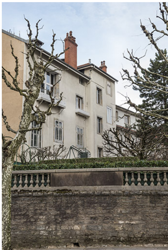
Façade postérieure, depuis l'avenue Denfert-Rochereau.
