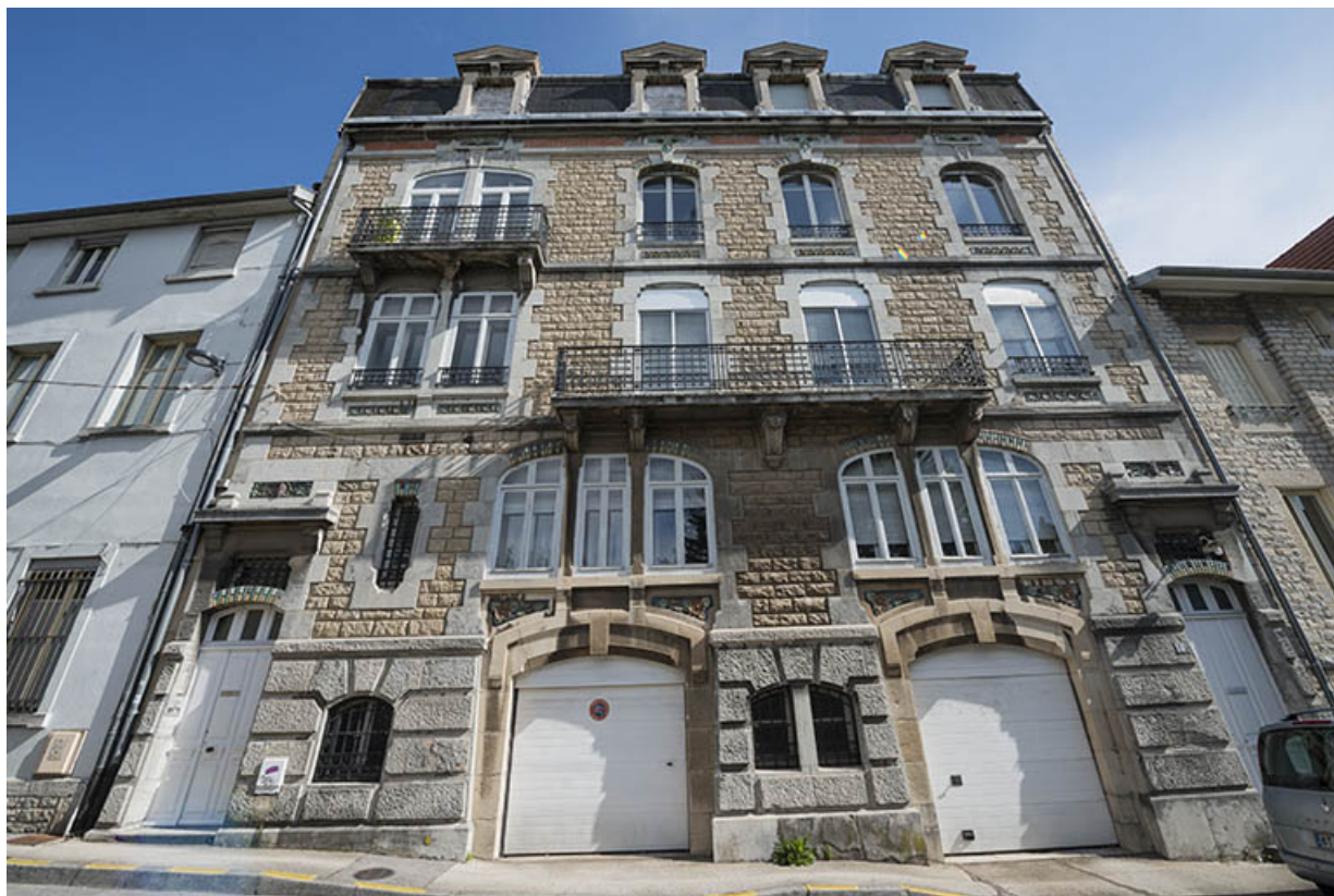
Façade antérieure. Vue en contre-plongée.
