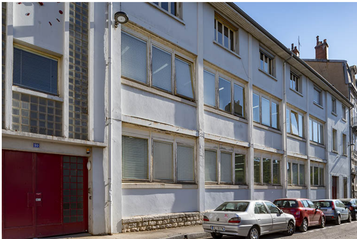
Façade ouest vue de trois quarts gauche.
