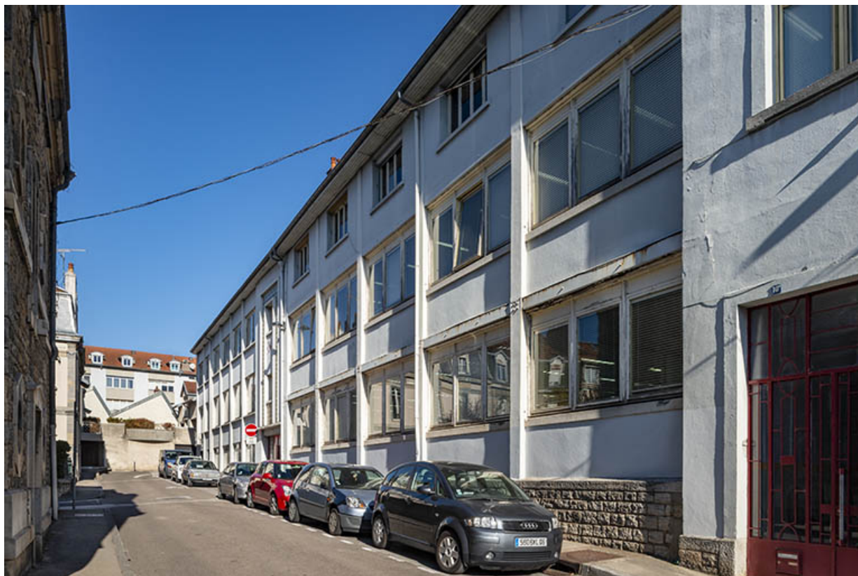
Vue d'ensemble depuis le bas de la rue.
