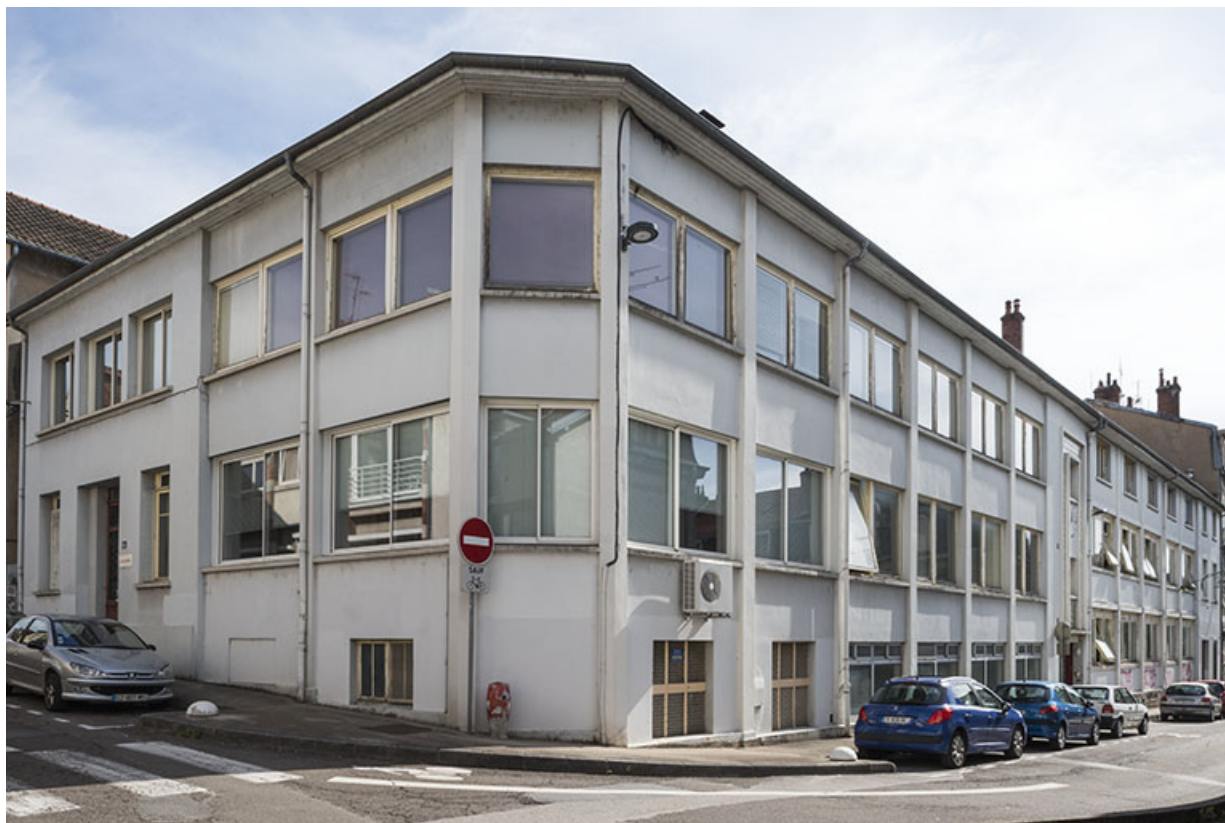
Vue depuis l'angle de la rue des Villas.
