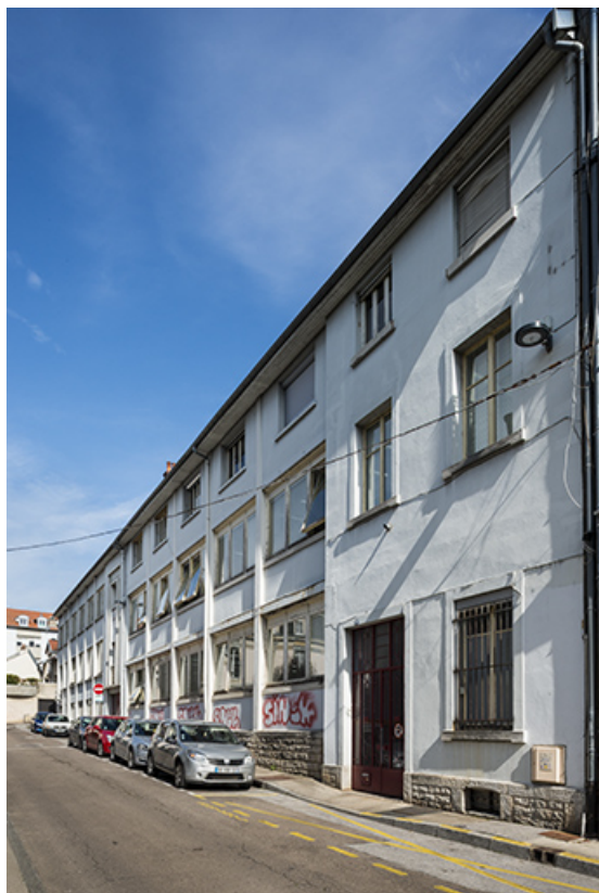
Façade antérieure vue de trois quarts droite. 25, Besançon, 10, 14 rue des Villas
