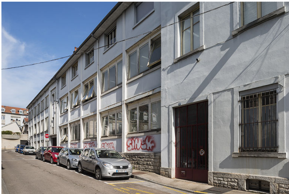
Façade antérieure de l'atelier principal.
