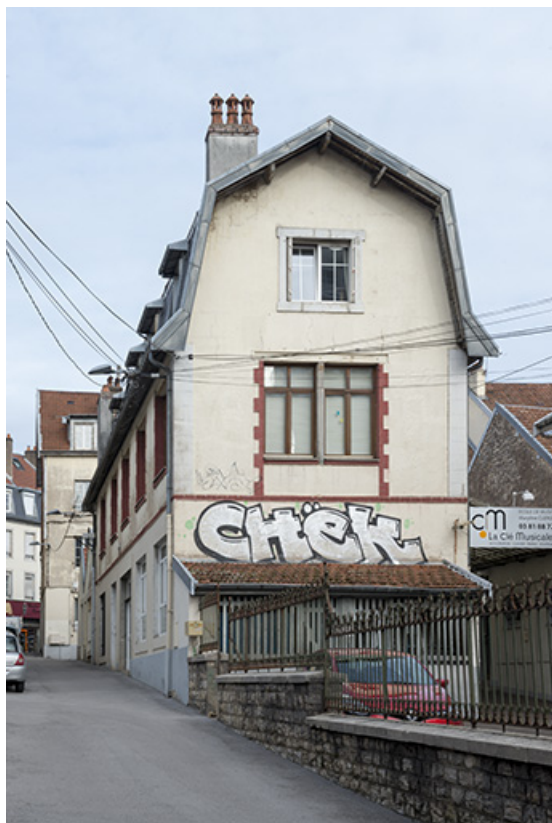
Atelier vu de trois quarts, depuis le sud de l'impasse Rambaud. 25, Besançon, 7 rue des Chaprais
