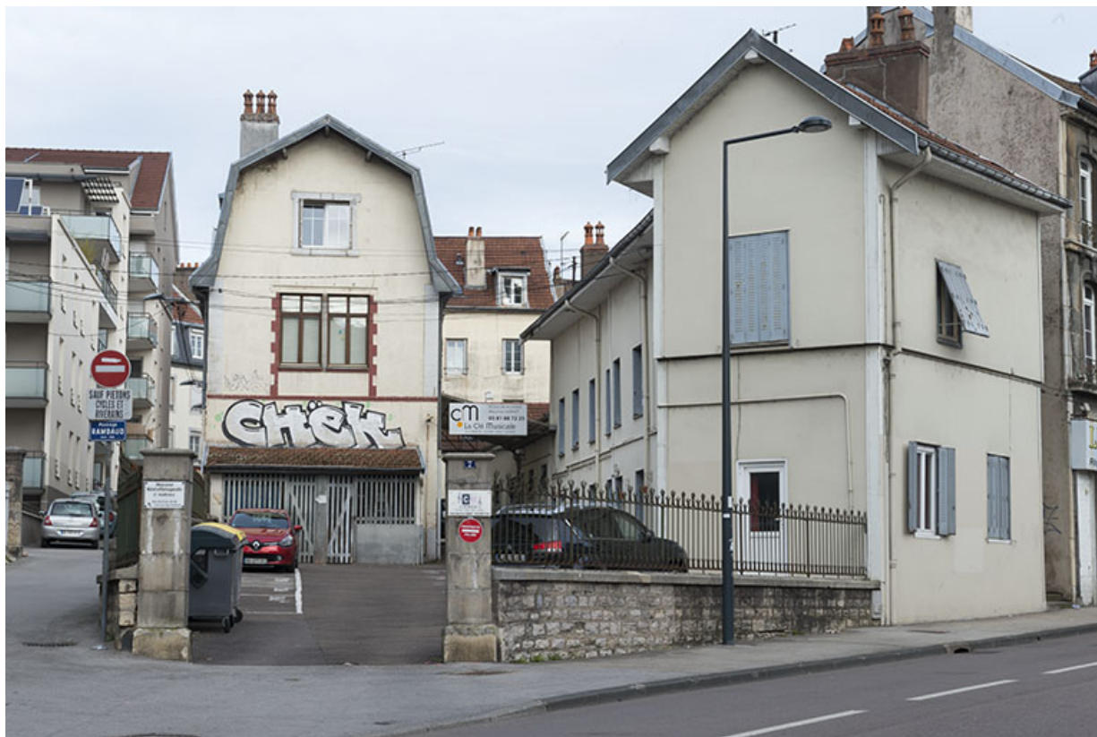
Vue d'ensemble, depuis le sud. 25, Besançon, 7 rue des Chaprais
