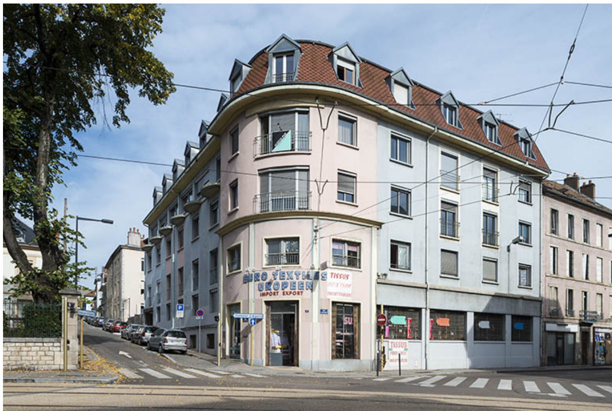
Vue d'ensemble depuis le haut de l'avenue Carnot.
