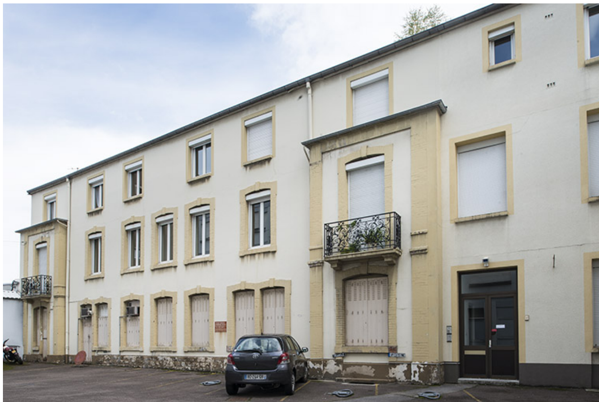
Bâtiment (bureaux et ateliers) en fond de cour.
