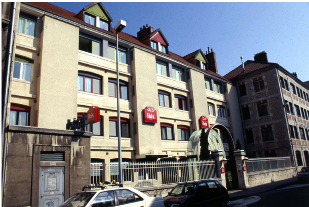
Façade antérieure : de trois quarts gauche. 25, Besançon, 21 rue Gambetta
