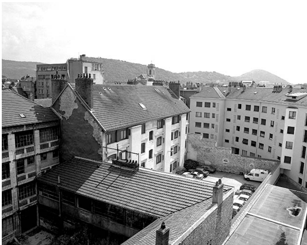
Façade postérieure et cour : de trois quarts gauche.
