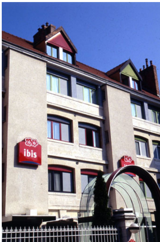
Façade antérieure : détail de la partie centrale.
