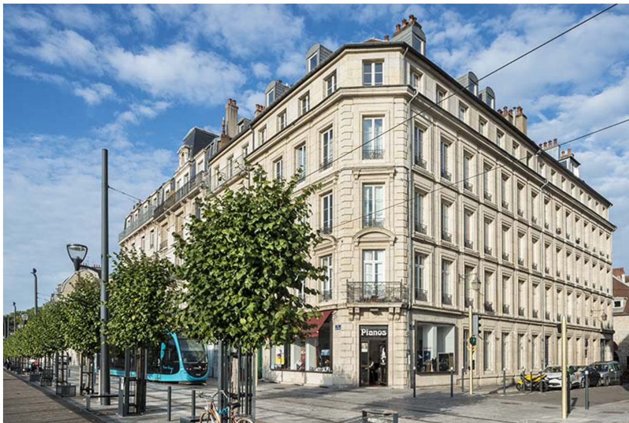
Vue d'ensemble depuis le quai Veil-Picard.
