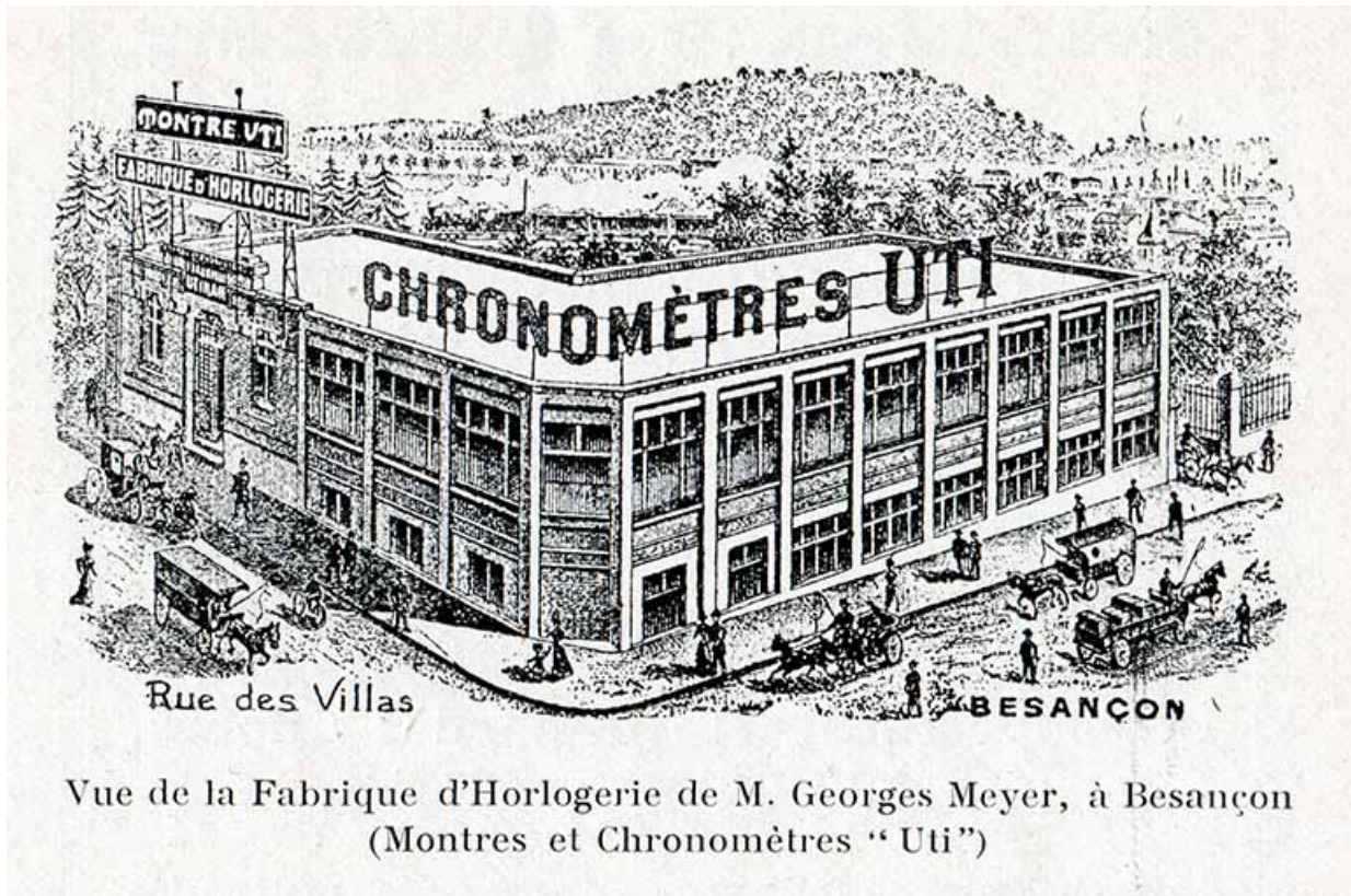
Fabrique d'horlogerie Uti rue des Villas (Georges Meyer), 1906. 25, Besançon, 10, 14 rue des Villas
