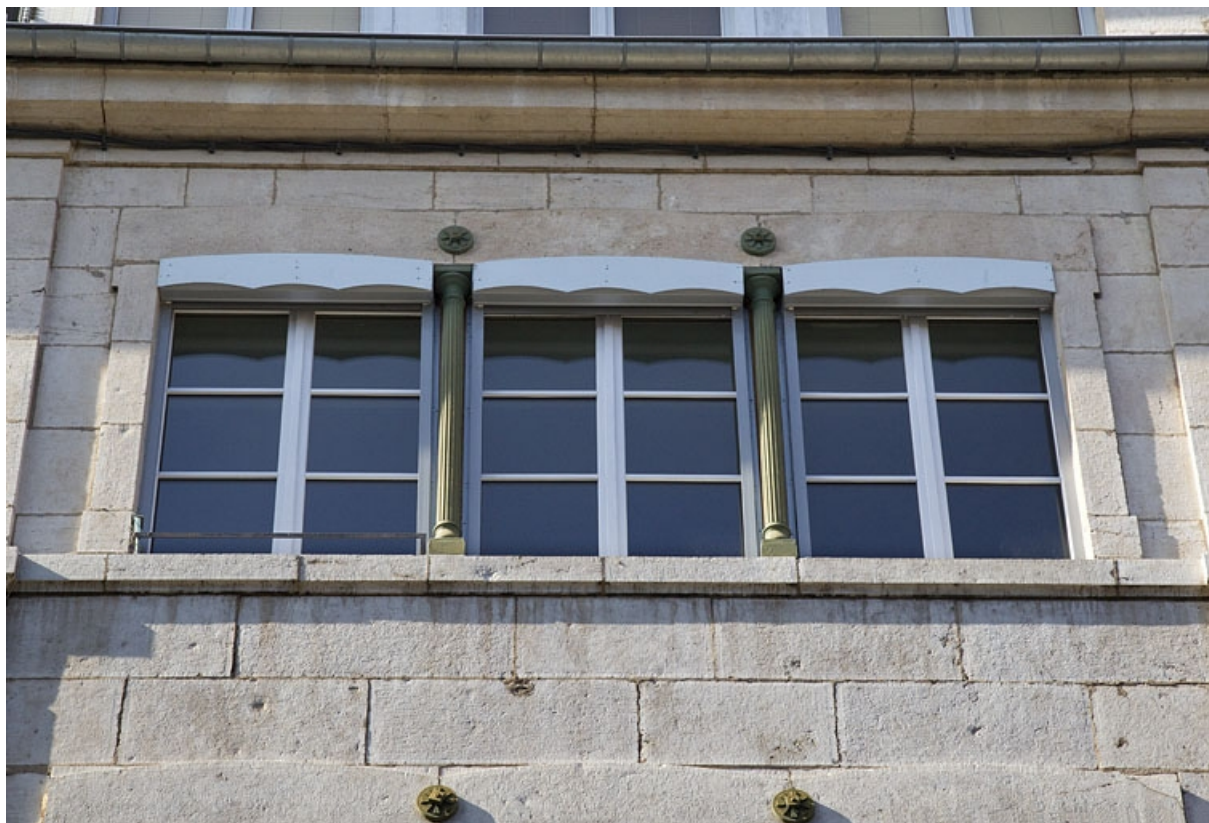
Détail d'une baie horlogère du deuxième étage. 25, Besançon
