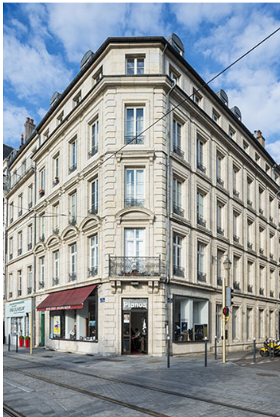
Vue de l'immeuble depuis l'angle de la rue et du quai. 25, Besançon, 33 quai Veil Picard
