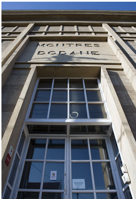
Corps d'entrée : entrée vue en contre-plongée.
