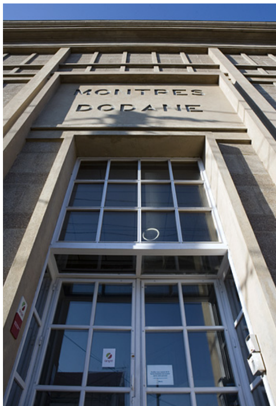
Corps d'entrée : entrée vue en contre-plongée.
