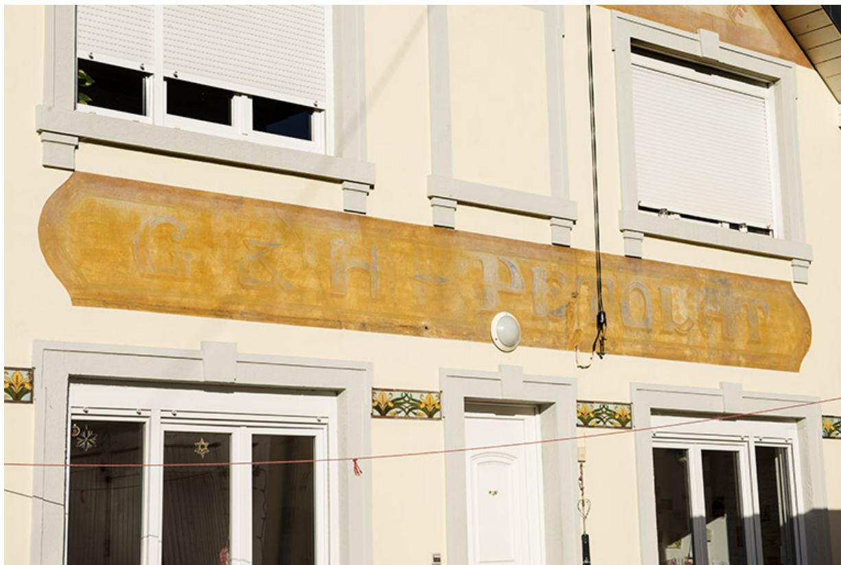
Pignon est. Détail du bandeau peint.
