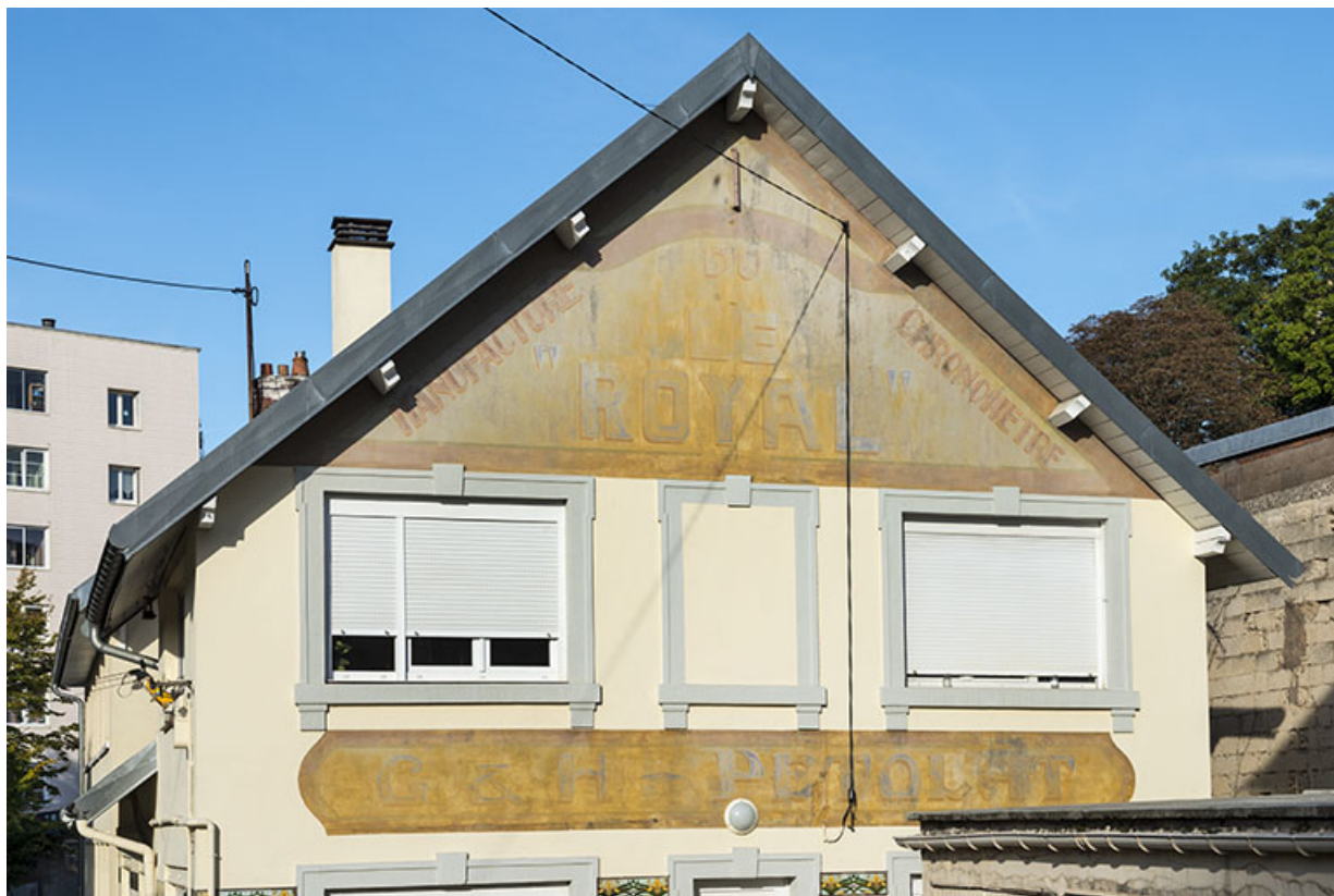
Atelier de fabrication. Partie supérieure du pignon.
