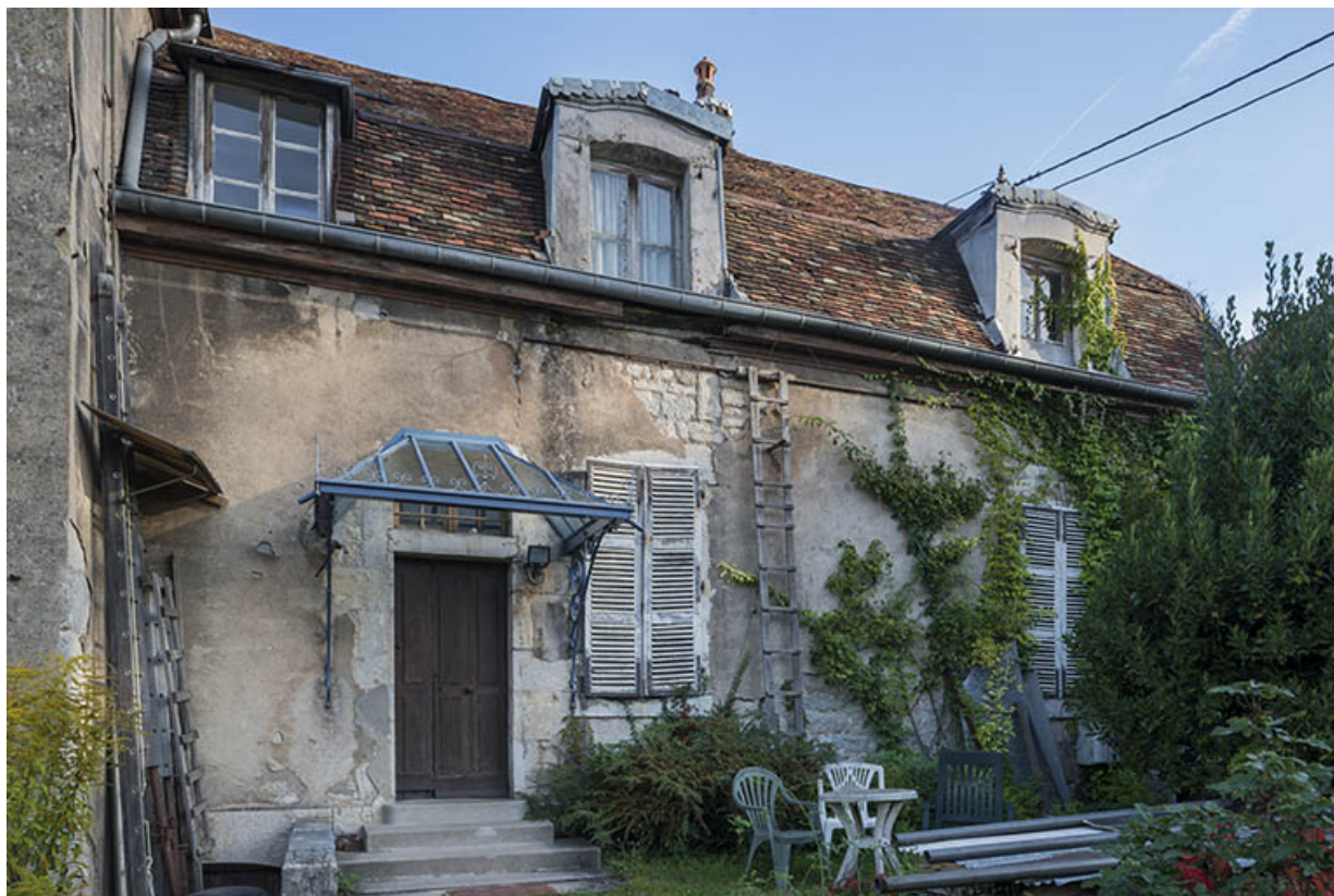
Façade sud de la maison.
