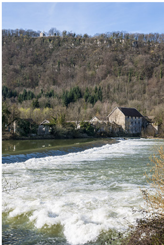
Vue d'ensemble depuis la rive droite.
