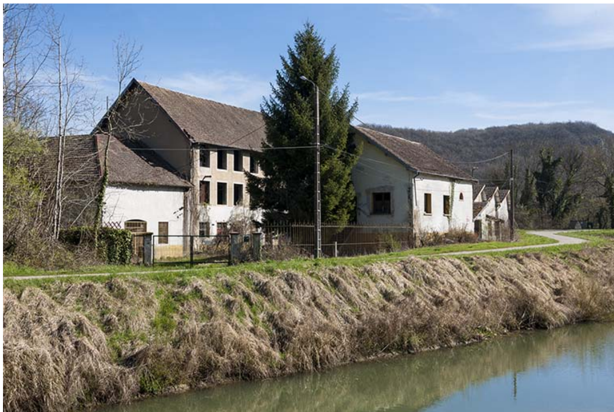
Vue de trois quarts depuis l'Eurovéloroute 6.
