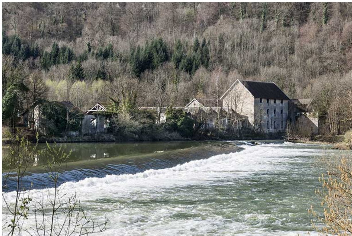
Vue rapprochée depuis la rive droite.
