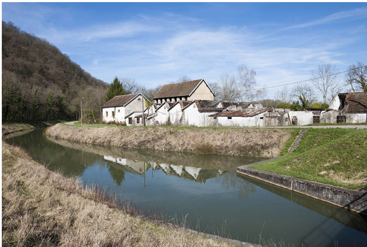
Vue d'ensemble depuis le pont franchissant le canal.
