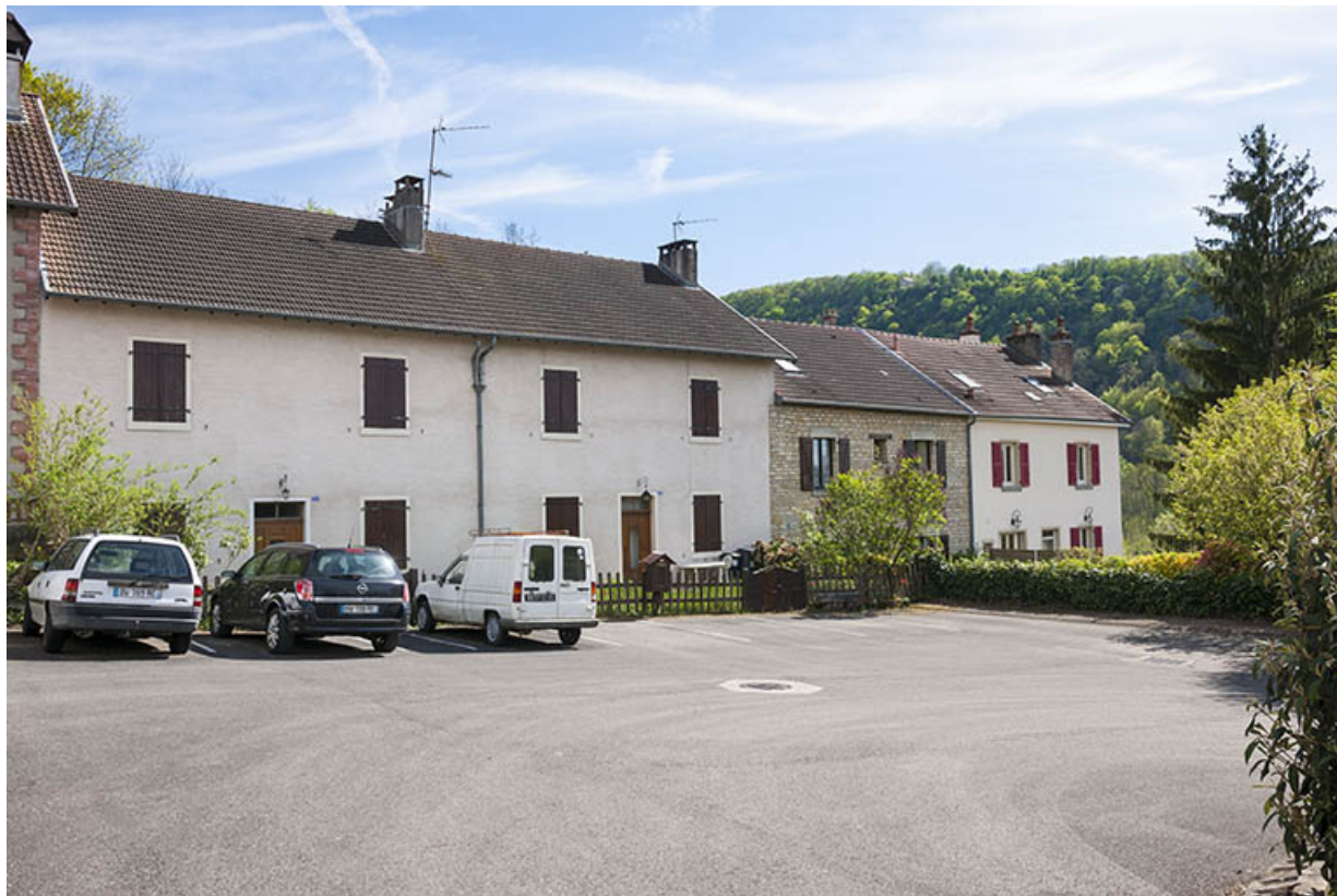
Façade ouest des logements contigus (26-28 rue des Usines). 25, Montferrand-le-Château rue des Usines
