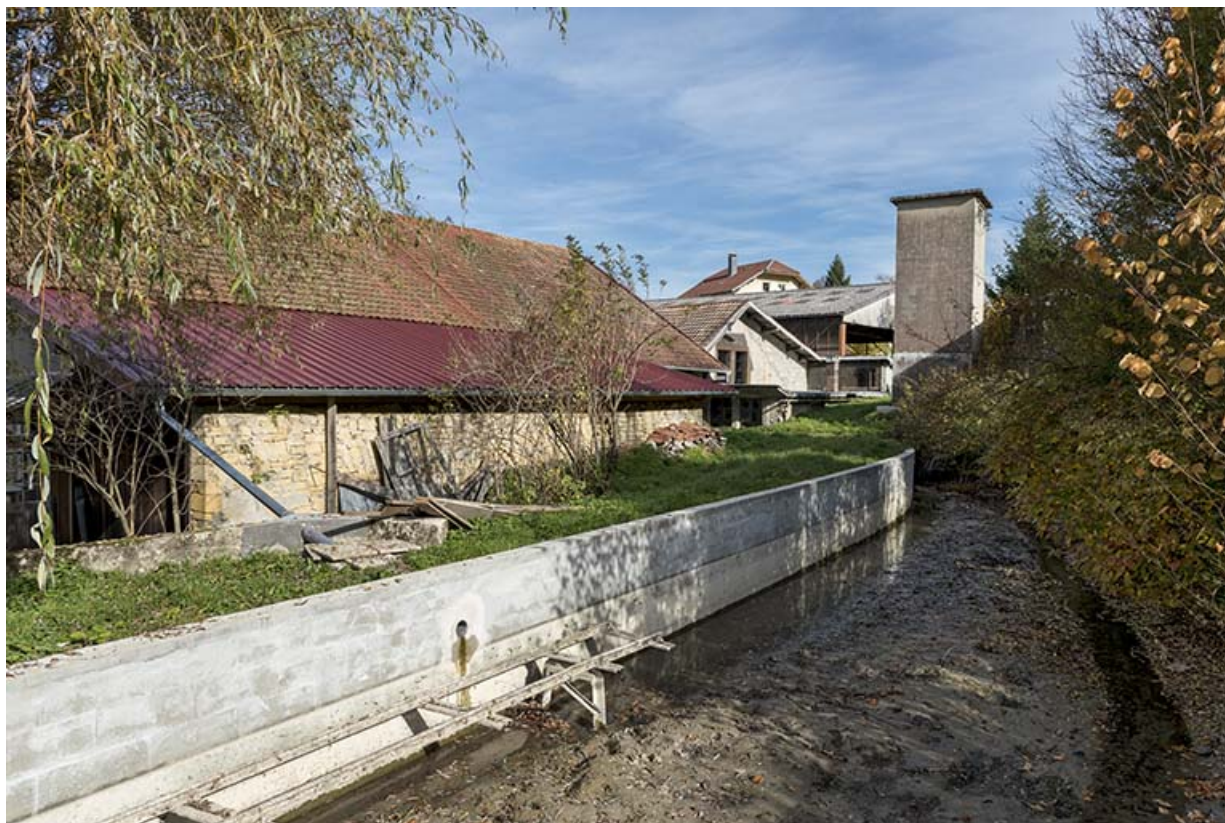
Bâtiment ancien : façade postérieure et canal d'aménée. 25, Montlebon
