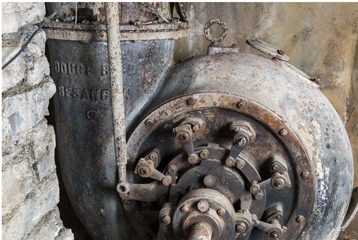
Atelier de fabrication, sciurier : turbine Douge. 25, Montlebon
