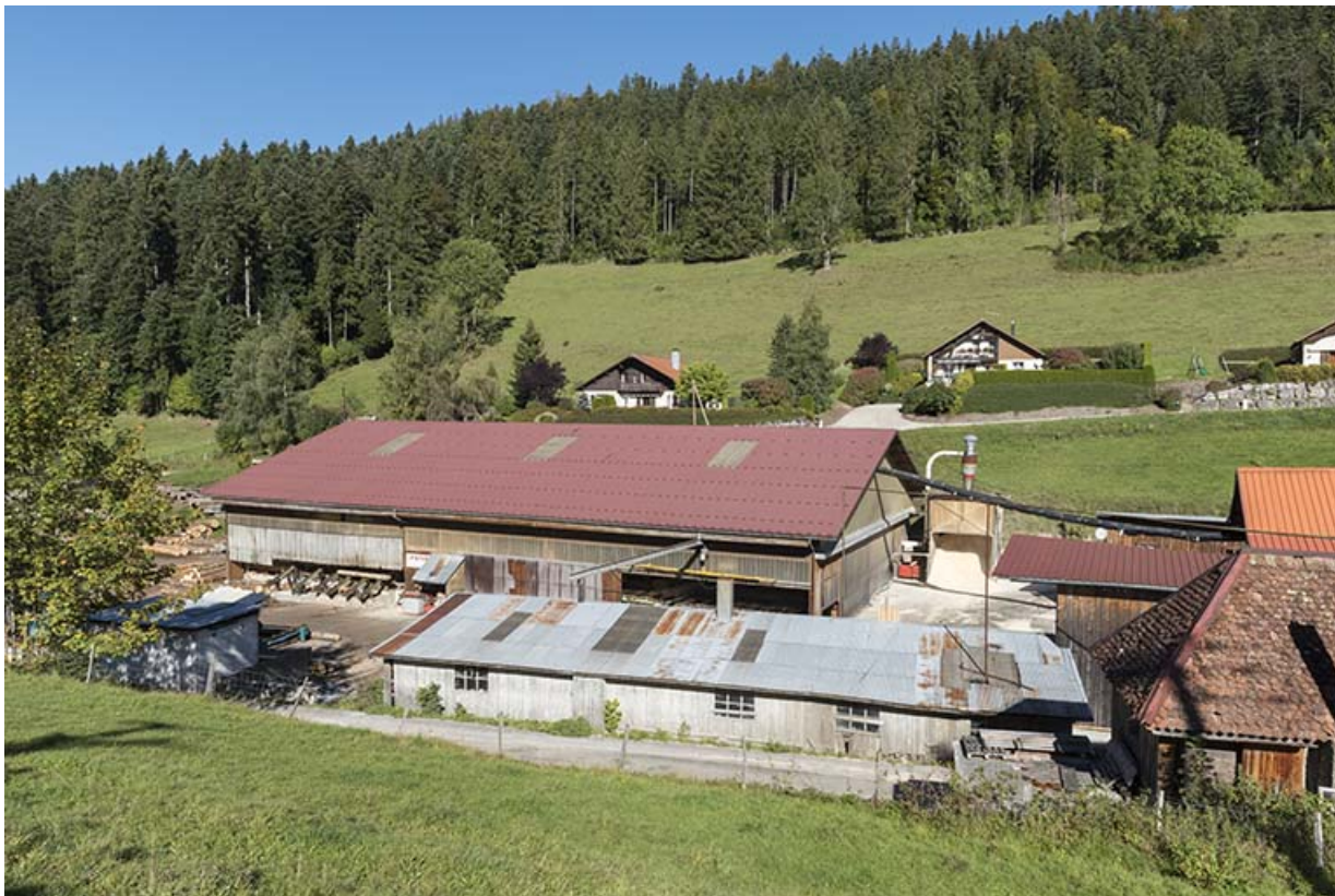
Vue plongeante sur les ateliers, depuis le sud-est. 25, Montlebon
