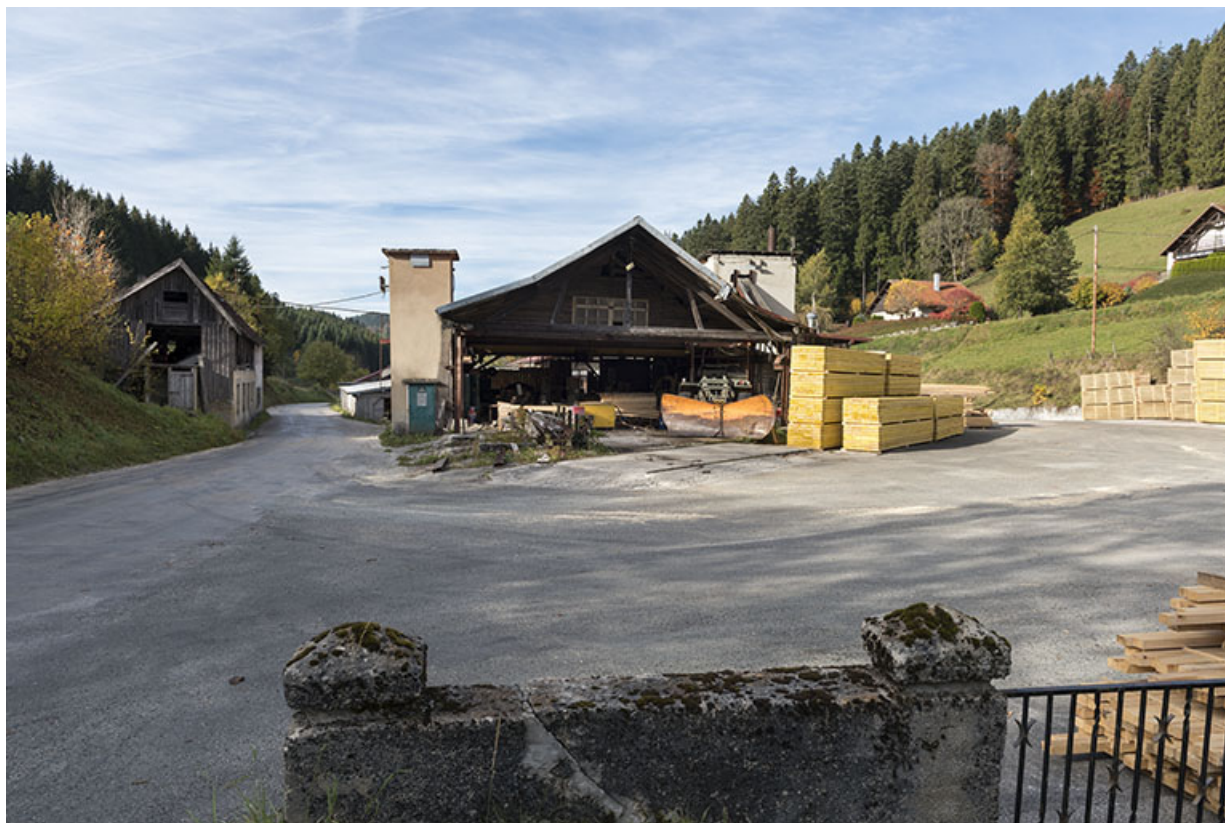
Transformateur et atelier de fabrication (1894), depuis l'est (amont). 25, Montlebon
