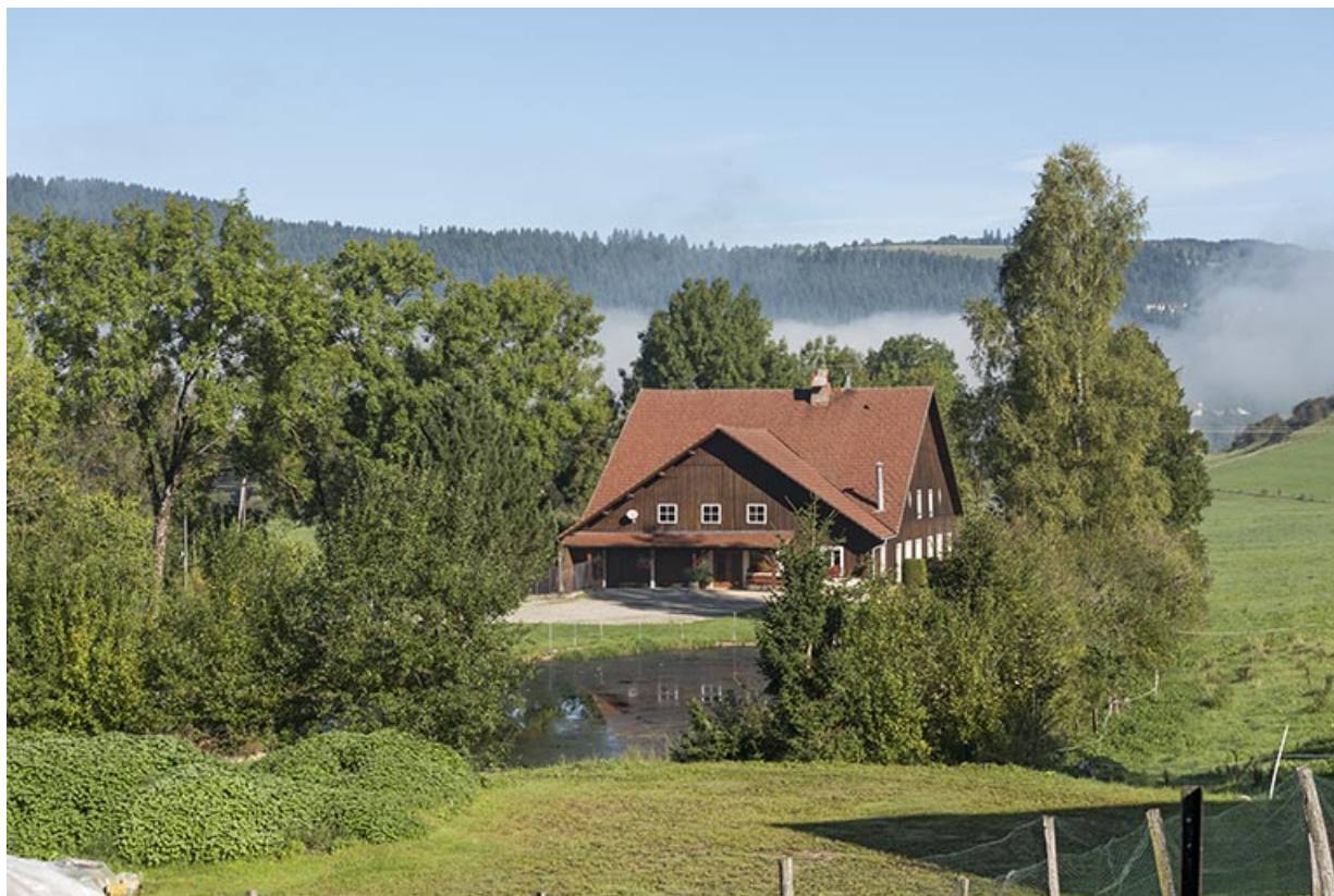
Vue d'ensemble depuis le sud, avec le bassin de retenue. 25, Montlebon
