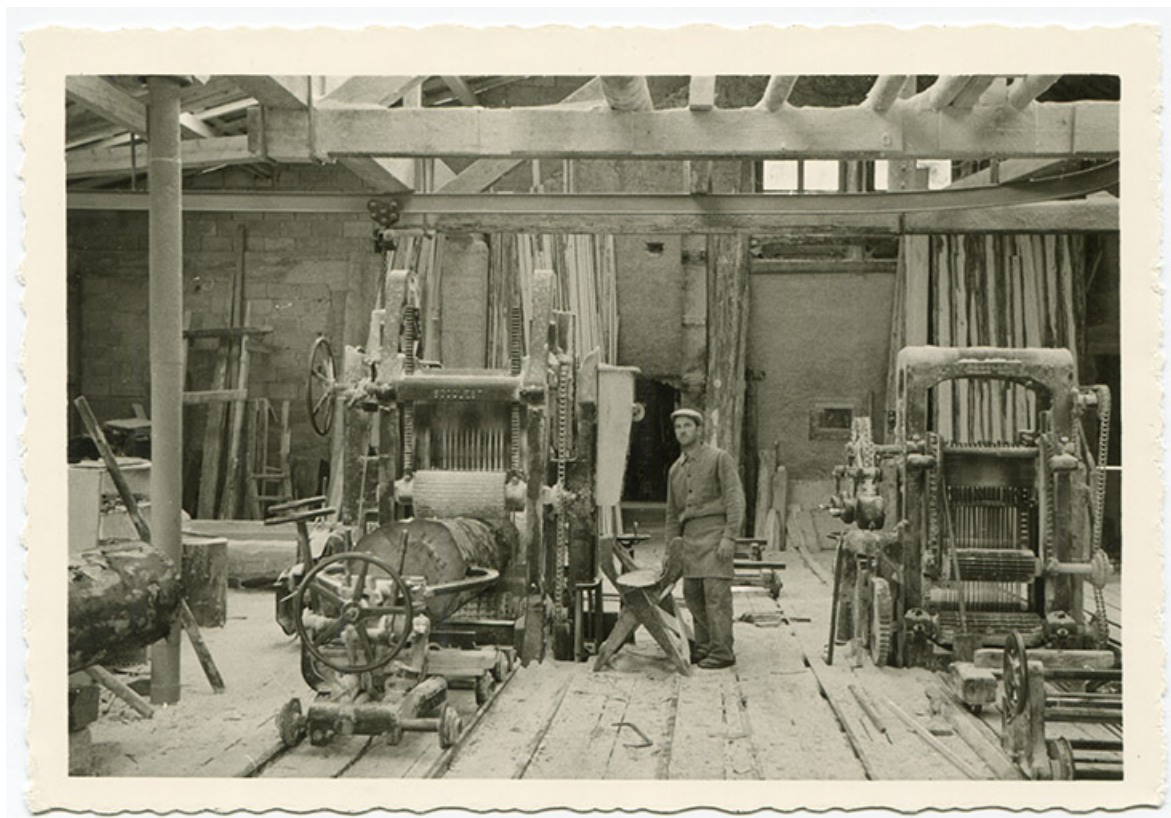
[Sciage au gros châssis de scie Socolest, vu depuis l'entrée de l'atelier], années 1960.
