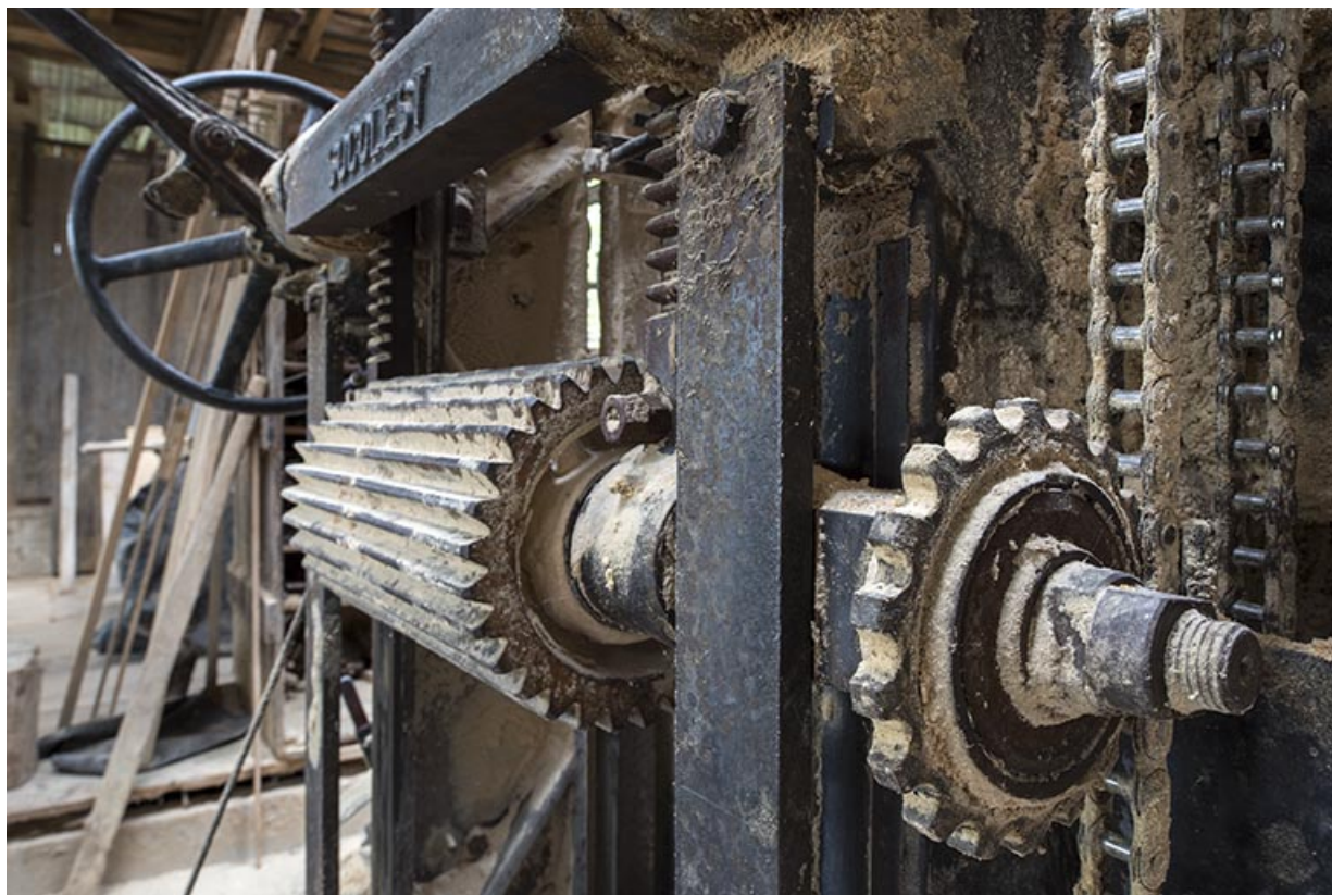
Atelier de fabrication : châssis de scie Socolest, pignon et rouleau. 25, Montlebon, 13 rue du Moulin, lieudit : Cornabey
