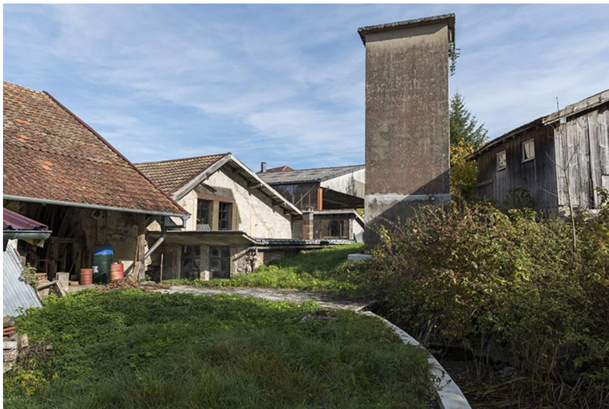
Atelier de réparation et d'affûtage, et transformateur, près du canal d'amenée. 25, Montlebon, 13 rue du Moulin, lieudit : Cornabey
