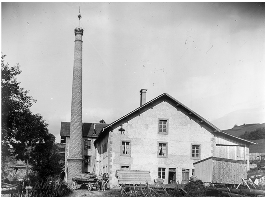
[Vue d'ensemble, depuis le sud-ouest], 1ère moitié 20e siècle [avant 1942].
