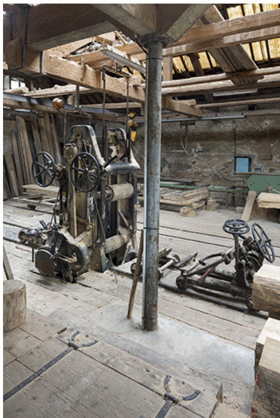
Atelier de fabrication : châssis de scie Socolest, vu de trois quarts gauche. 25, Montlebon, 13 rue du Moulin, lieudit : Cornabey
