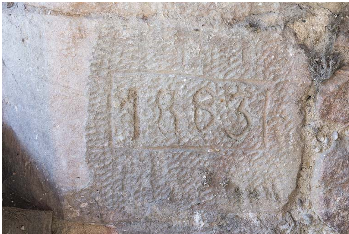
Bâtiment ancien, partie centrale : date 1883 du côté du canal d'aménée.
