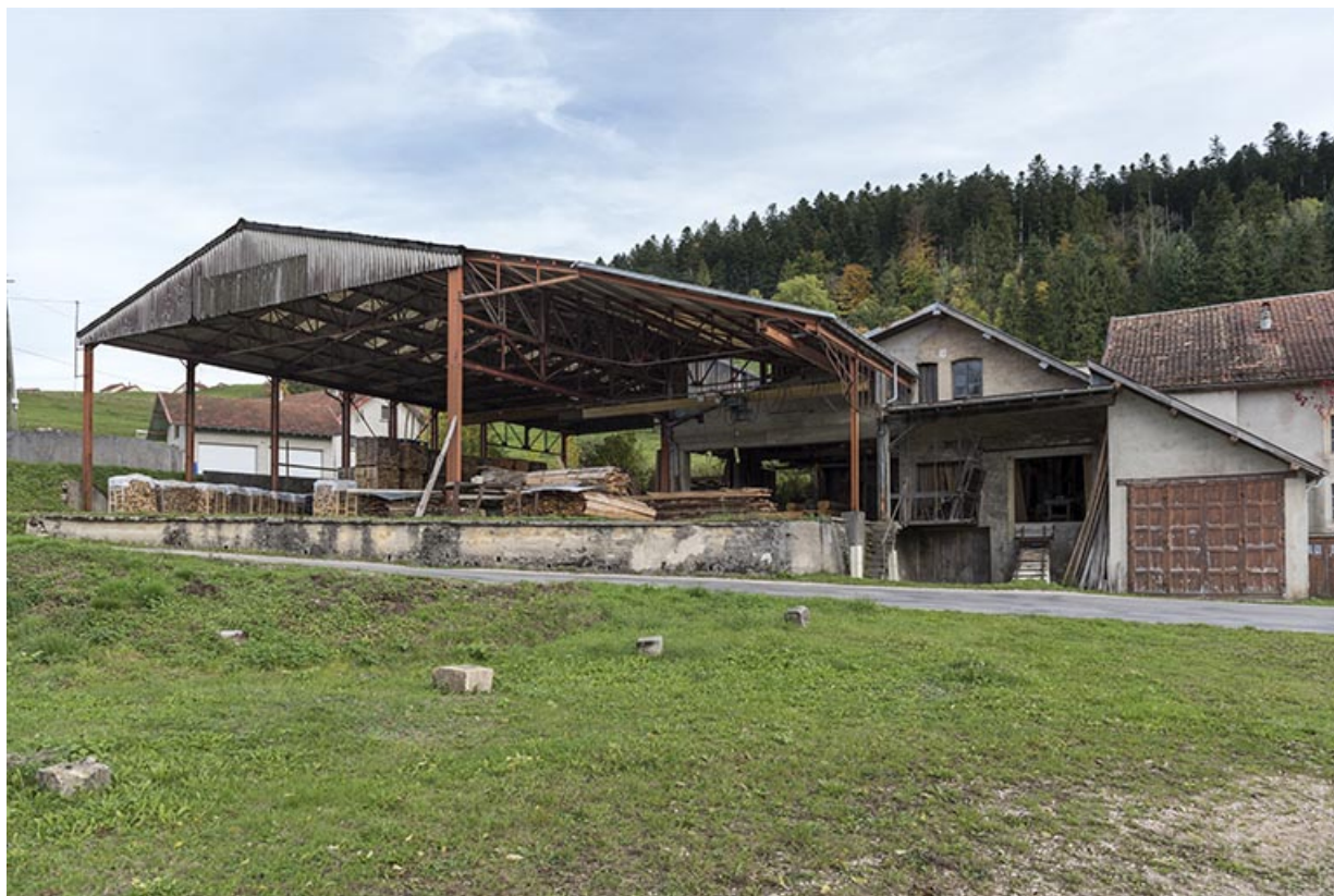
Ateliers de fabrication du 3e quart du 20e siècle, vus de l'ouest.
