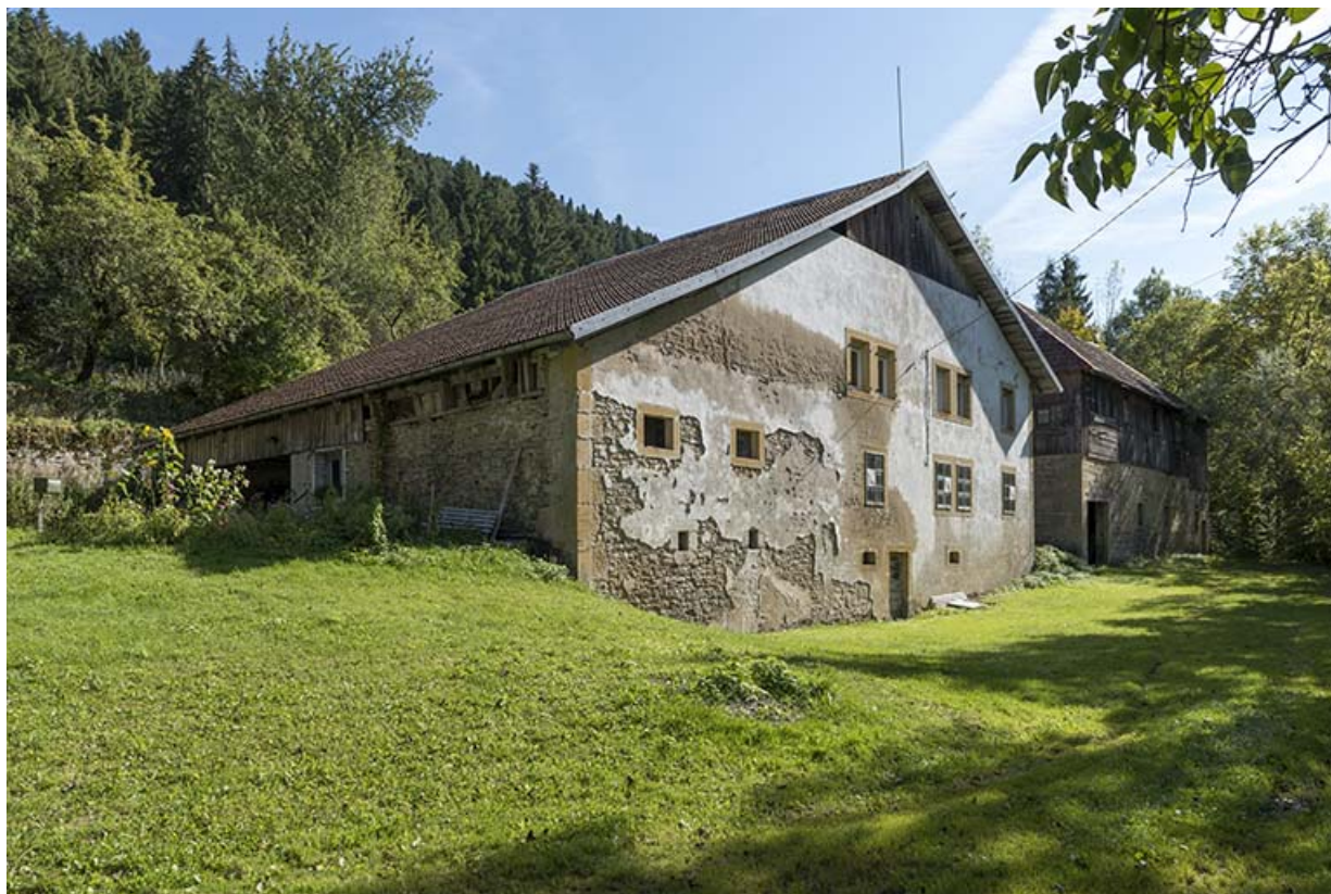
Moulin (à gauche) et scierie (à droite) : façades nord et ouest. 25, Montlebon
