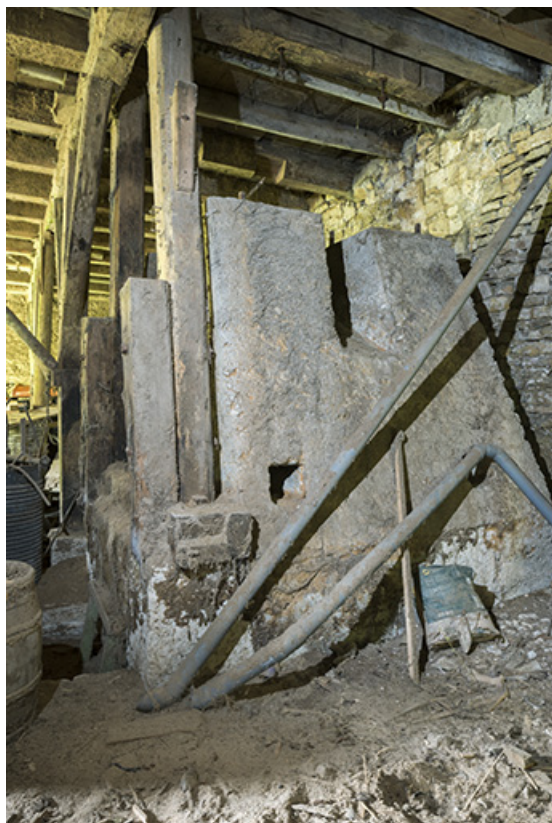
Scierie : socle en maçonnerie d'un châssis de scie. 25, Montlebon, 17 rue du Moulin, lieudit : Cornabey
