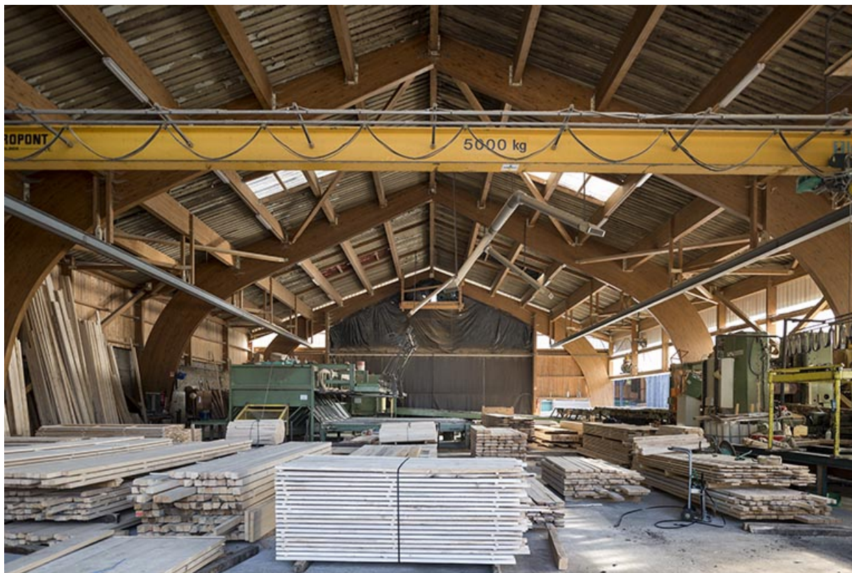
Atelier de fabrication (2000) : intérieur.
