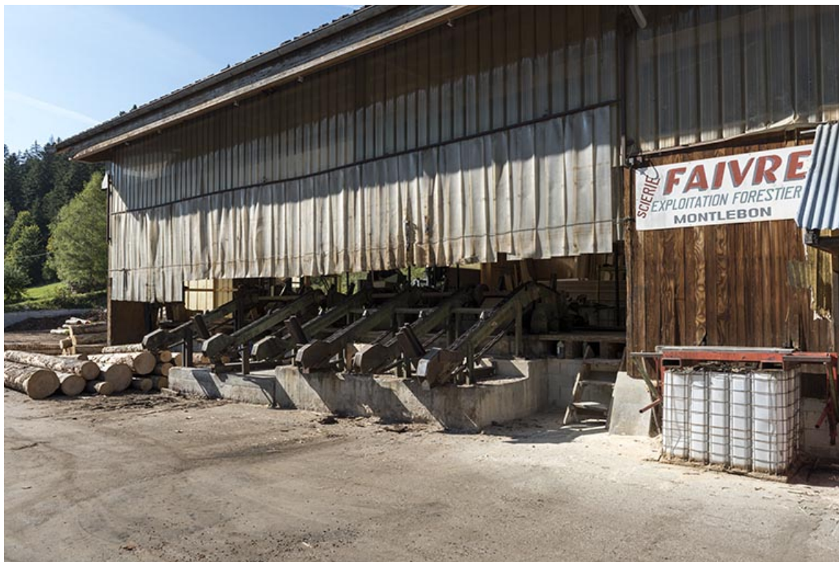
Atelier de fabrication (2000) : façade sud. 25, Montlebon, lieu-dit : Derrière le Mont
