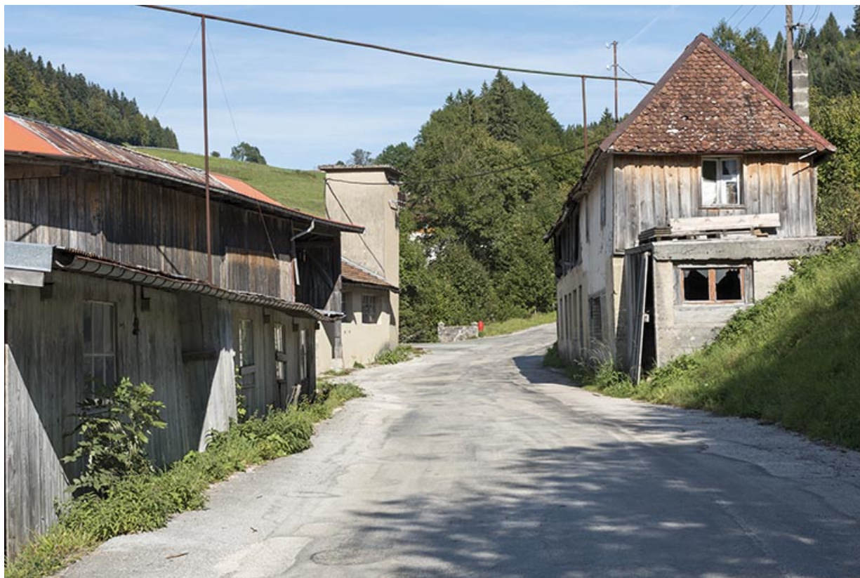
Atelier de fabrication (1894) à gauche et atelier de réparation à droite, depuis l'ouest. 25, Montlebon, lieudit : Derrière le Mont
