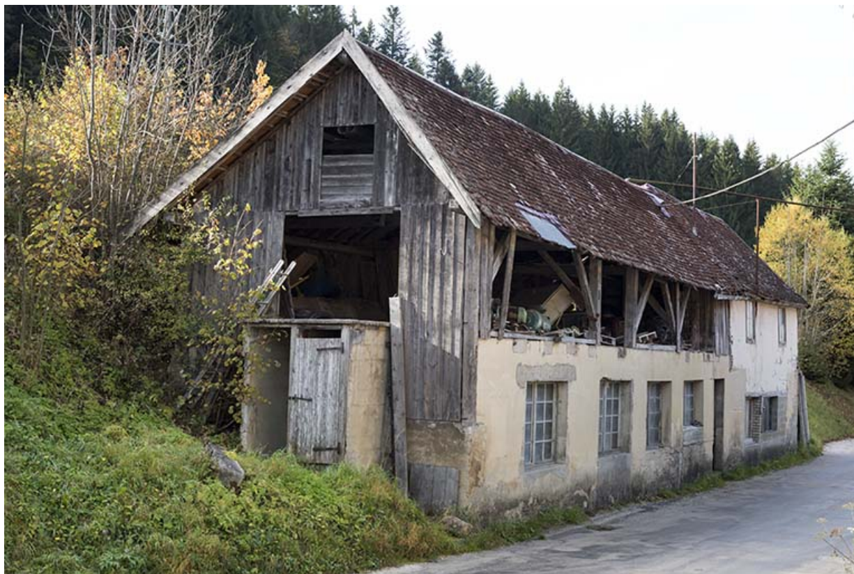
Atelier de réparation (affûtage), de trois quarts gauche.
