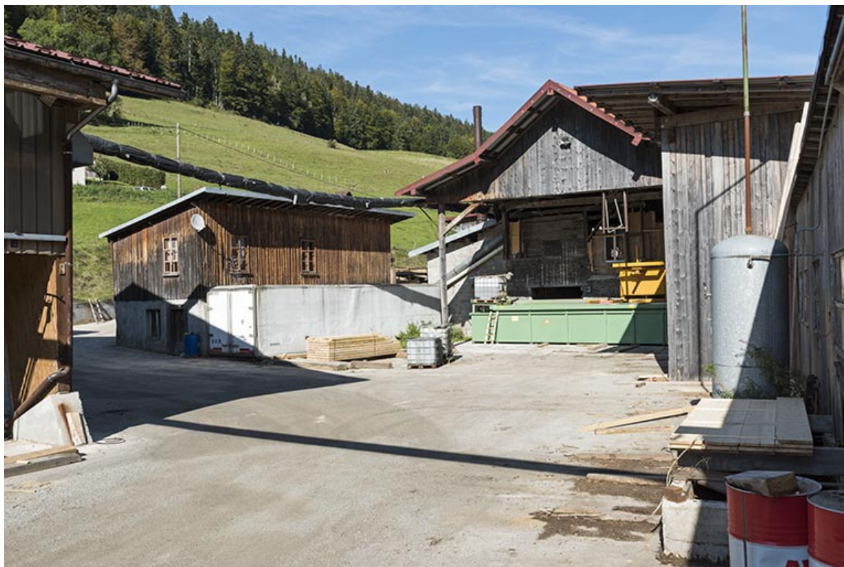
Maison (à gauche) et atelier de fabrication (1894), depuis l'ouest.
