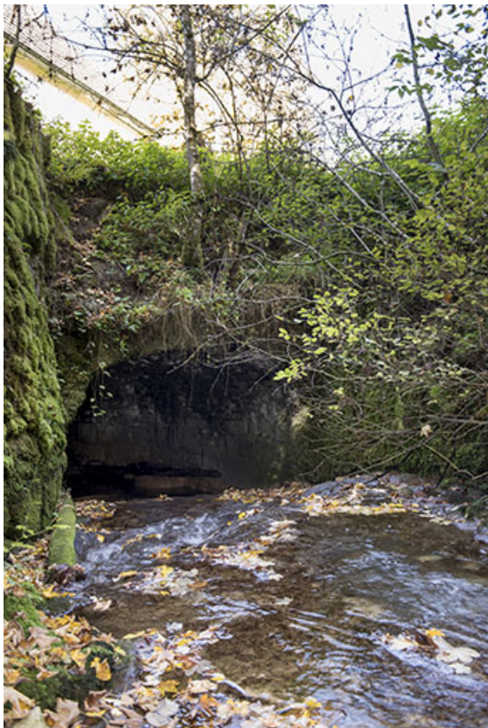
Couverture sur le ruisseau de la Douve, en amont du bâtiment.
