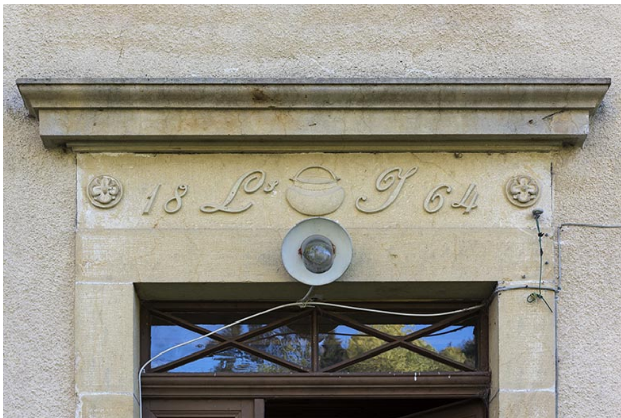
Façade antérieure : linteau sculpté et daté 1864.
