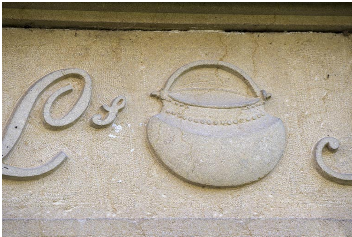
Façade antérieure : chaudron de fromagerie sculpté sur le linteau.
