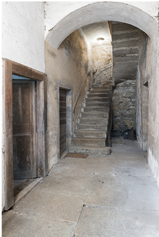
Escalier et couloir, à l'étage de soubassement.
