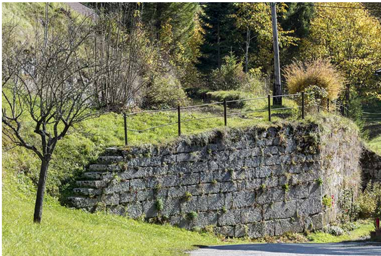
Bassin de retenue : mur de soutènement.
