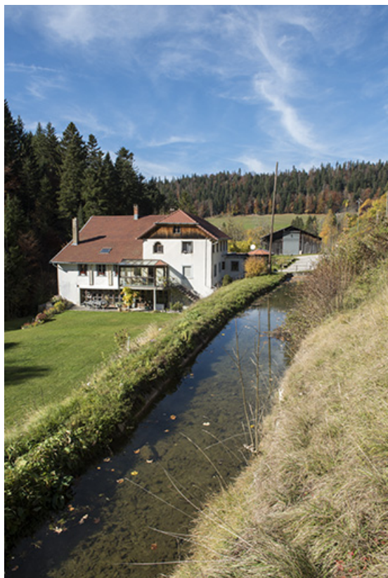
Vue d'ensemble plongeante sur le bâtiment et le bassin de retenue, depuis le sud-est. 25, Montlebon, lieudit : Derrière le Mont
