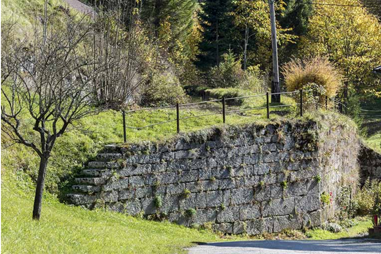
Bassin de retenue : mur de soutènement.
