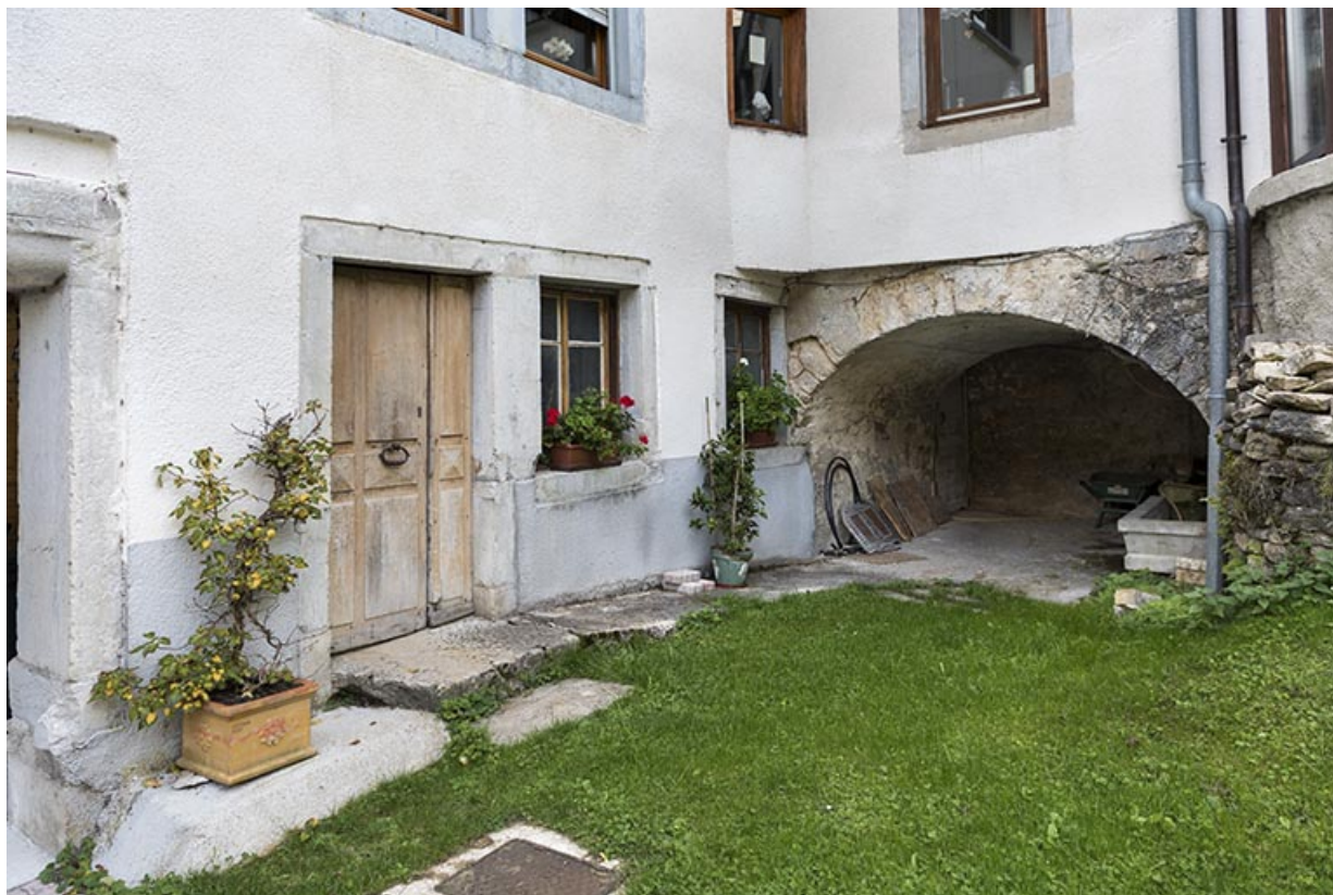
Bâtiment : baies et ancien pont de grange (rampe d'accès).
