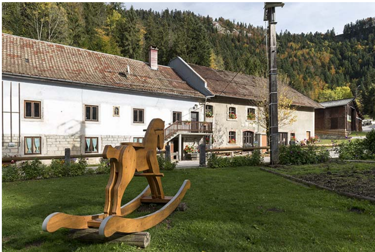
Usine de bimmeloterie, tableterie et meubles de la société Sauge, à Montlebon.
