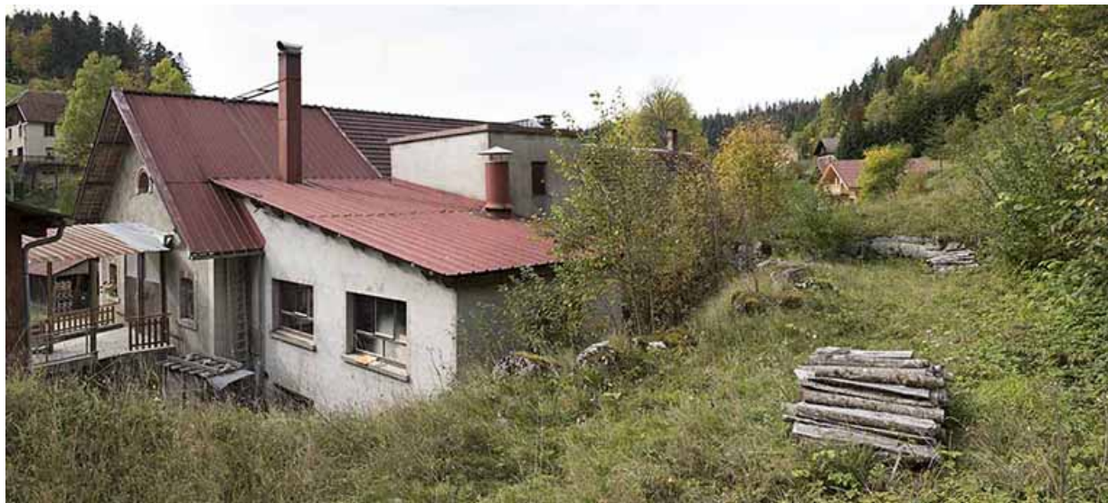
Atelier de fabrication : façades postérieure et latérale gauche. A droite, l'ancien canal d'amenée. 25, Montlebon, 27-29 rue des Coquillards, lieudit : Derrière le Mont
