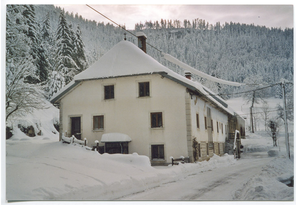
[L'usine Sauge sous la neige en mars 2003].
