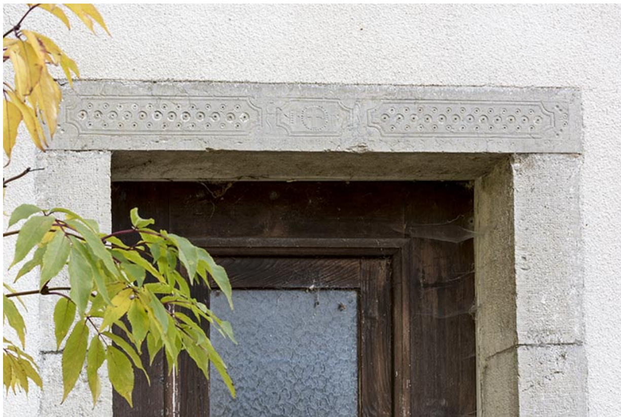
Logement : linteau orné d'une porte sur la façade postérieure. 25, Montlebon, 27-29 rue des Coquillards, lieudit : Derrière le Mont
