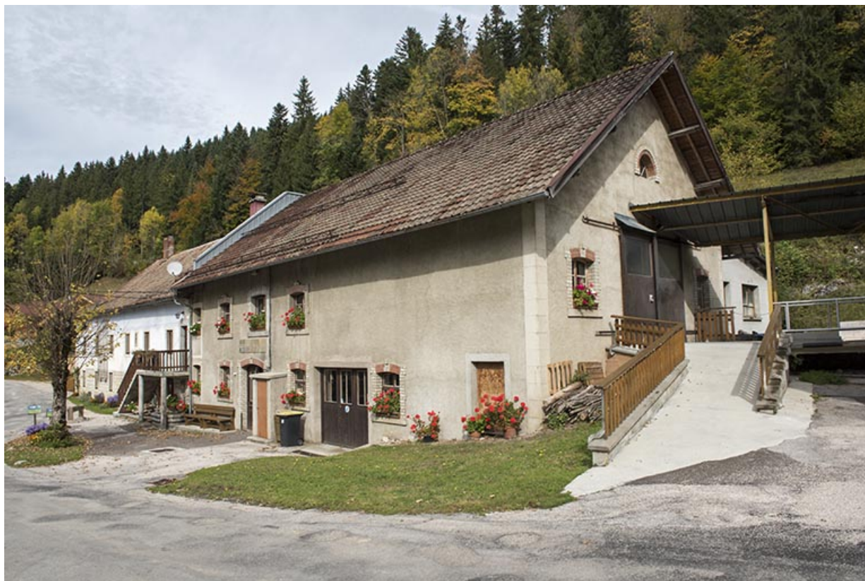
Atelier de fabrication : façades antérieure et latérale droite. 25, Montlebon
