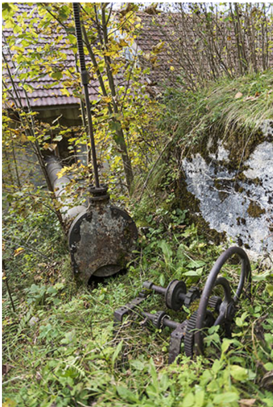
Éléments de vannage pour la prise d'eau de la turbine. 25, Montlebon
