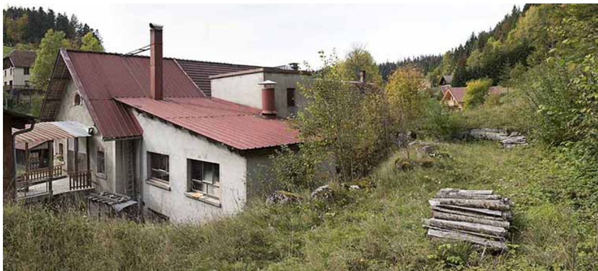
Atelier de fabrication : façades postérieure et latérale gauche. A droite, l'ancien canal d'amenée. 25, Montlebon, 27-29 rue des Coquillards, lieudit : Derrière le Mont
