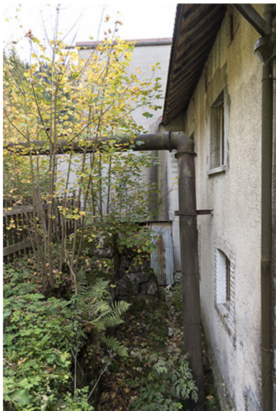
Atelier de fabrication : tuyau d'amenée d'eau de la turbine (façade postérieure). 25, Montlebon, 27-29 rue des Coquillards, lieudit : Derrière le Mont
