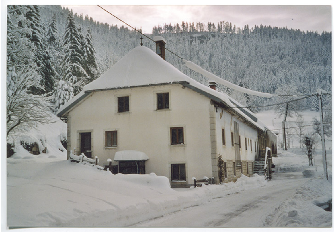
[L'usine Sauge sous la neige en mars 2003].
