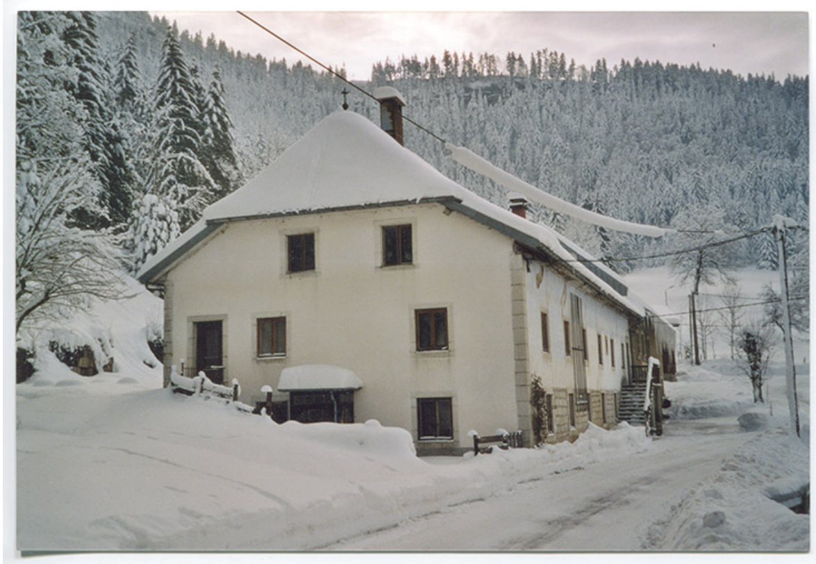
[L'usine Sauge sous la neige en mars 2003].
