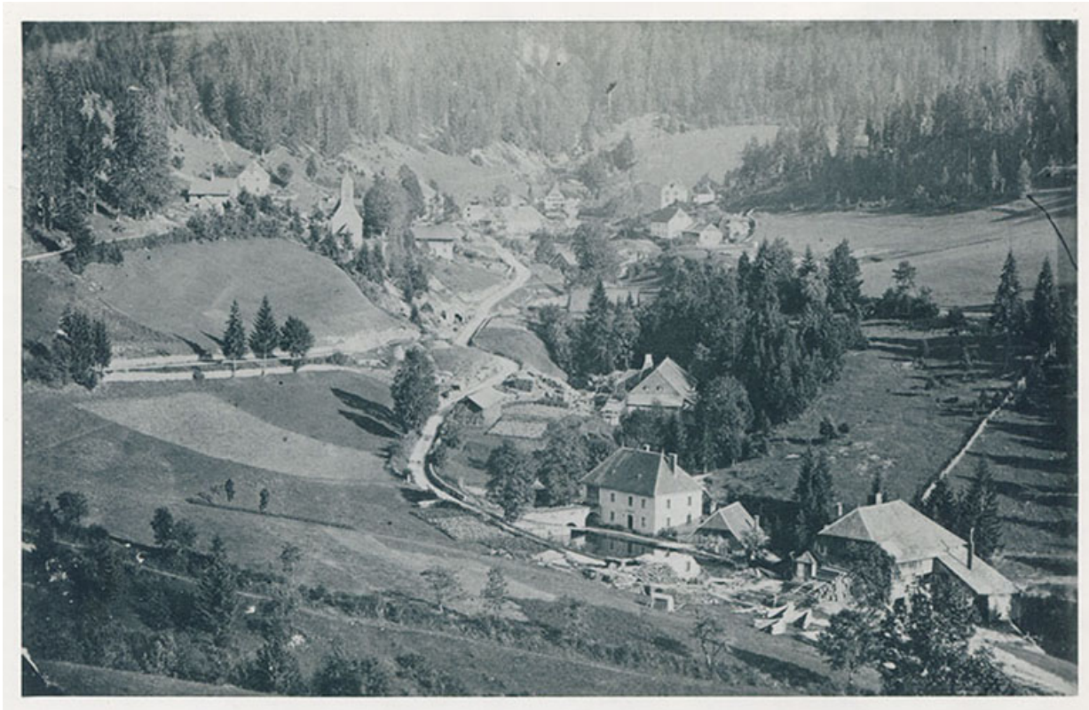
[Le hameau de Derrière-le-Mont, vu du nord], 4e quart 19e siècle. Au premier plan sont visibles, derrière le bassin de retenue, la maison de Louis Jacquot et son atelier, et à droite la scierie.
