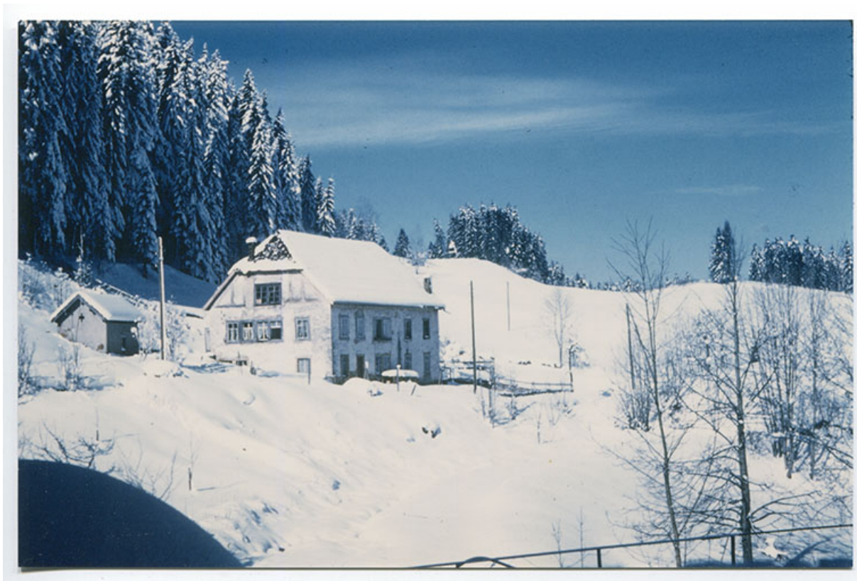
[Vue d'ensemble du bâtiment depuis l'est], 4e quart 20e siècle. 25, Montlebon, 16 rue des Coquillards, lieudit : Derrière le Mont
