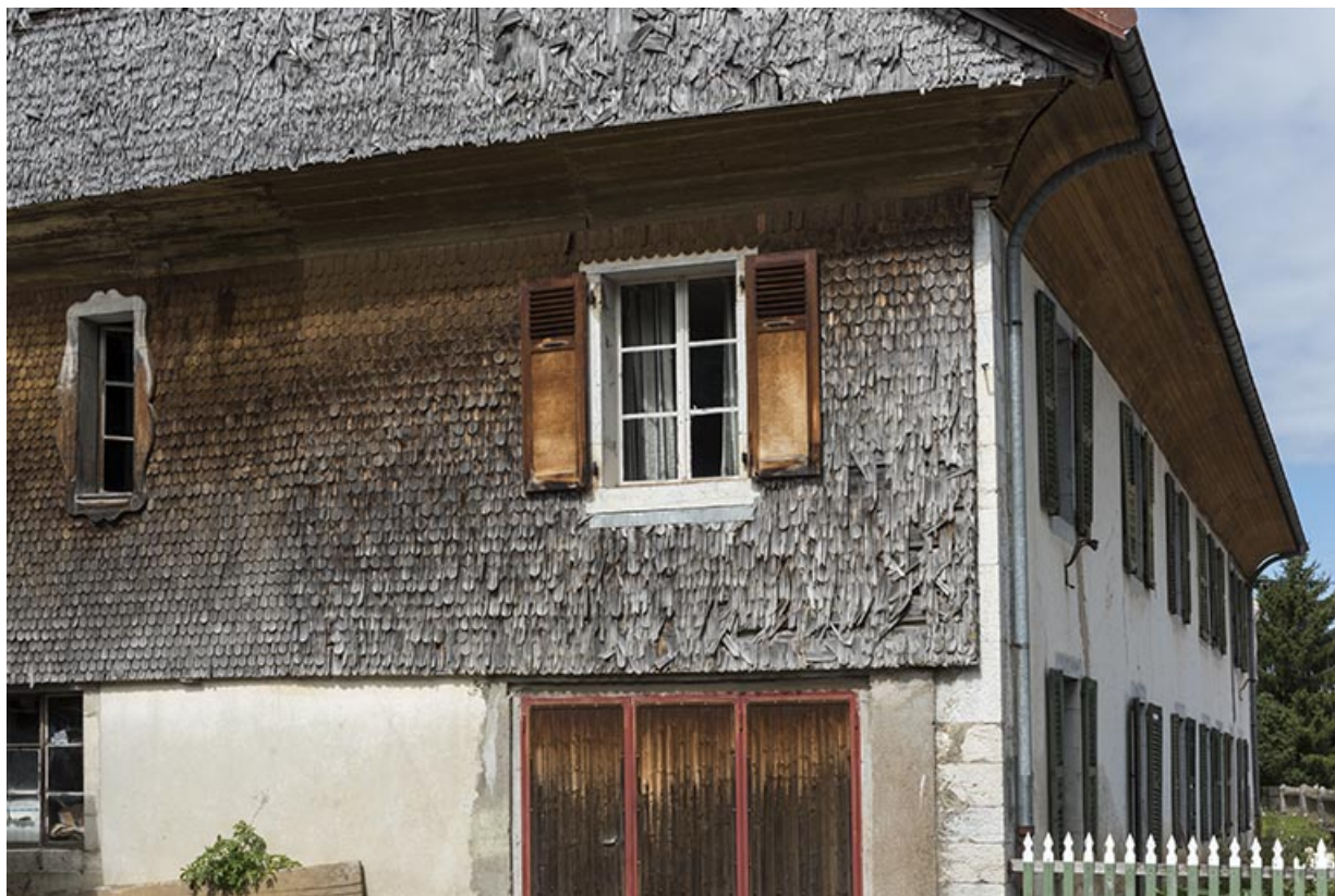
Façade latérale gauche : essentage de tavaillons, avec la façade antérieure en enfilade.
