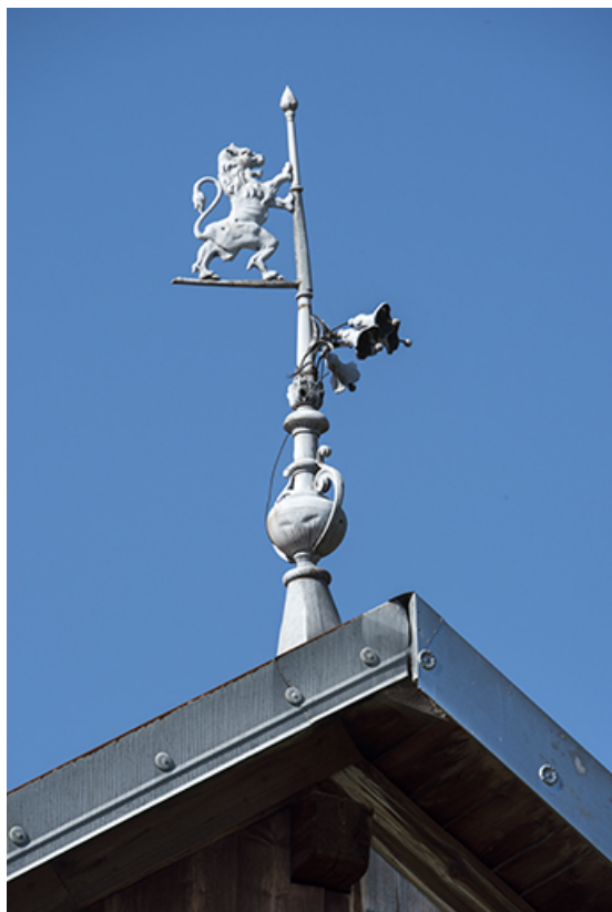
Façade latérale droite : épi de faitage.
