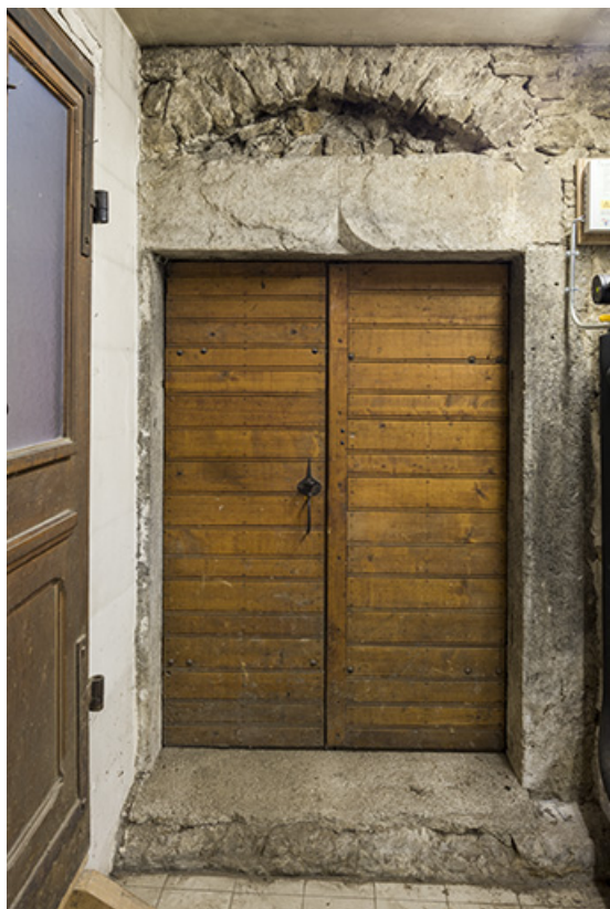
Porte de la cave (dans la chaufferie au nord). 25, Grand'Combe-Châteleu, lieudit : les Cordiers
