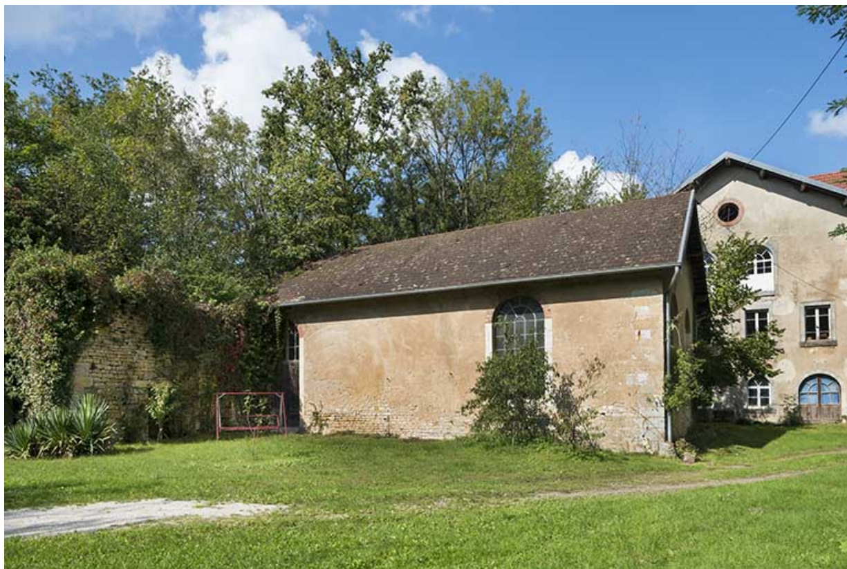
Chaufferie et salle de la machine à vapeur (partie ruinée à gauche).
