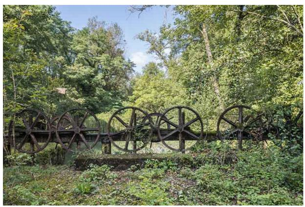
Mécanisme de levage du vannage (canal d'amenée).
