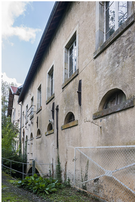
Façade antérieure. Vue depuis l'entrée.
