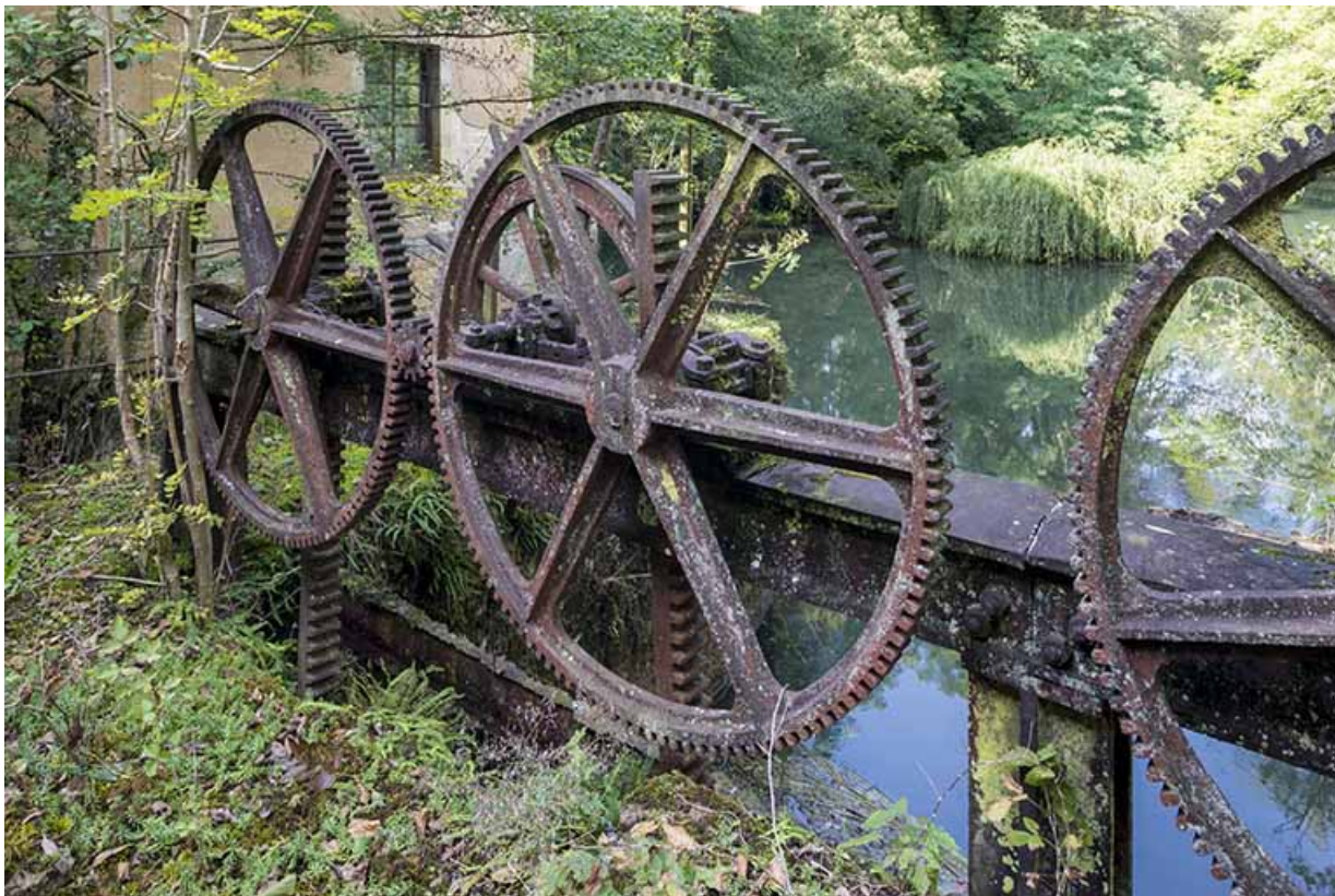
Vannage du canal d'amenée. Détail du mécanisme de levage.
