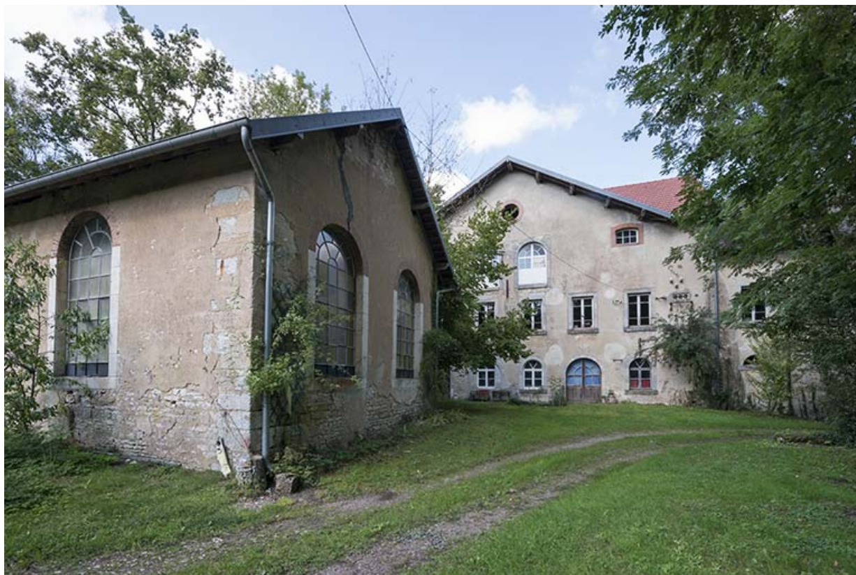
Local de la machine à vapeur (ou chaufferie ?) et atelier de fabrication.
