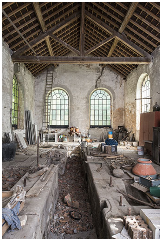
Intérieur de la salle de la machine à vapeur. 25, Chevroz chemin de l' Île
