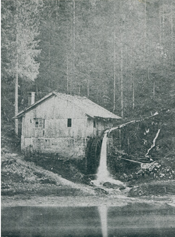
Le Moulinot [vue d'ensemble du bâtiment avec sa roue hydraulique par-dessus], 4e quart 19e siècle. 25, Grand'Combe-Châteleu
