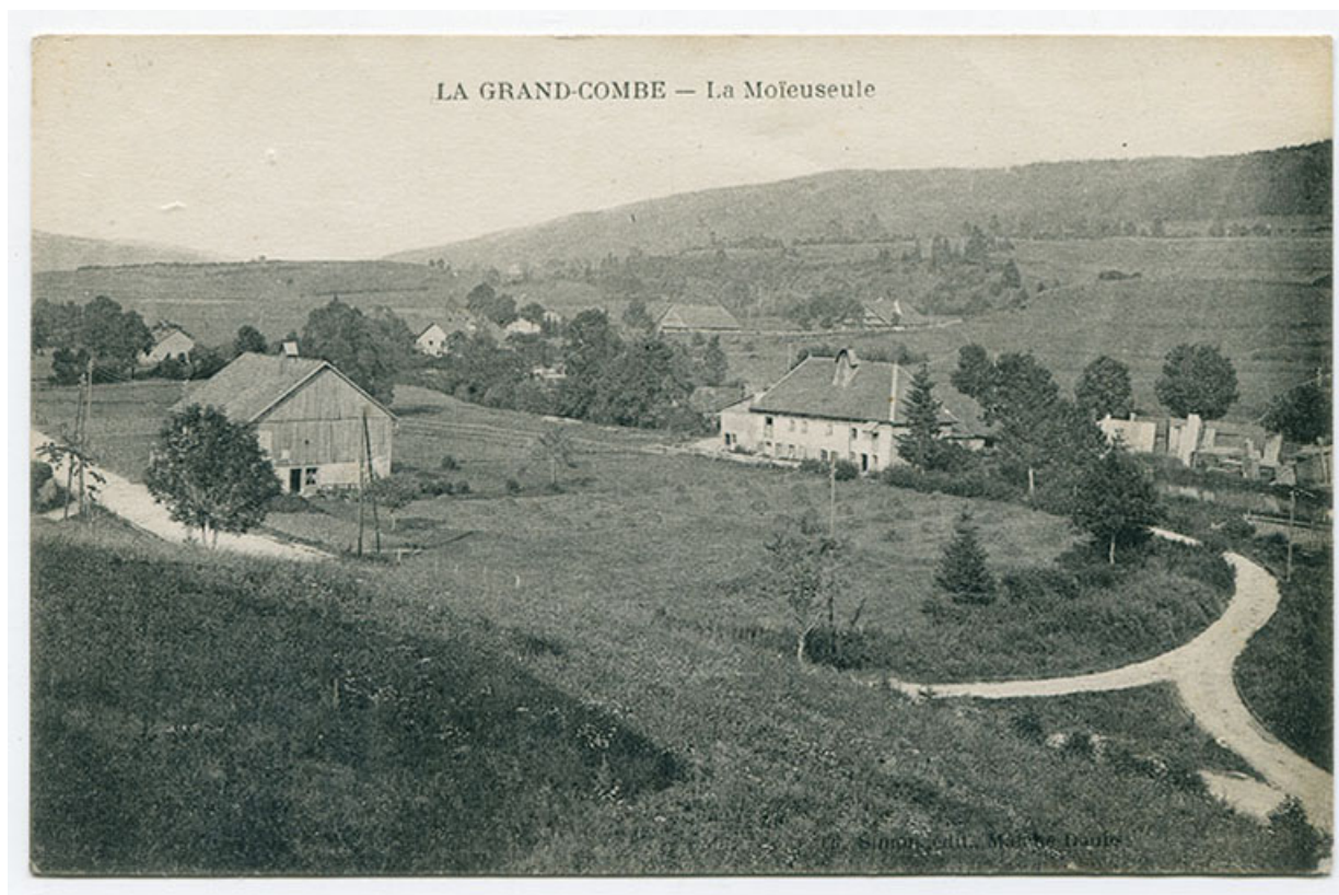
La Grand-Combe - La Moëuseule, 1ère moitié 20e siècle. La scierie Droz (puis Burgunder) correspond au bâtiment à droite. 25, Grand'Combe-Châteleu
