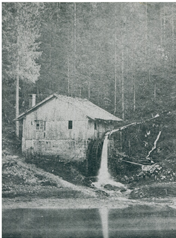
Le Moulinot [vue d'ensemble du bâtiment avec sa roue hydraulique par-dessus], 4e quart 19e siècle. 25, Grand'Combe-Châteleu
