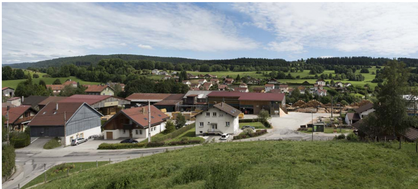
Scierie Burgunder ou Jurabois (le Moulin Bonzon). Le ruisseau du Théverot passe derrière les bâtiments. 25, Grand'Combe-Châteleu
