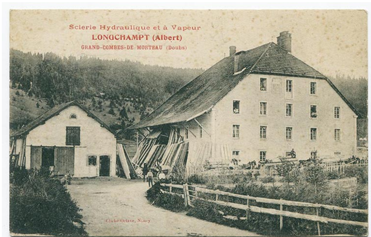
Scierie hydraulique et à vapeur Longchamppt (Albert). Grand-Combes-de-Morteau, 1er quart 20e siècle. Future scierie Boillot. 25, Grand'Combe-Châteleu
