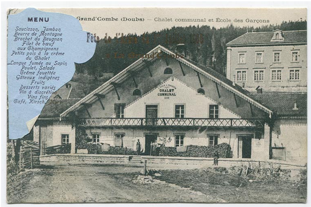
La Grand'Combe (Doubs) - Chalet communal et école des garçons, fin 19e siècle ou début 20e siècle [vers 1905 ?]. 25, Grand'Combe-Châteleu, lieudit : le Beugnon
