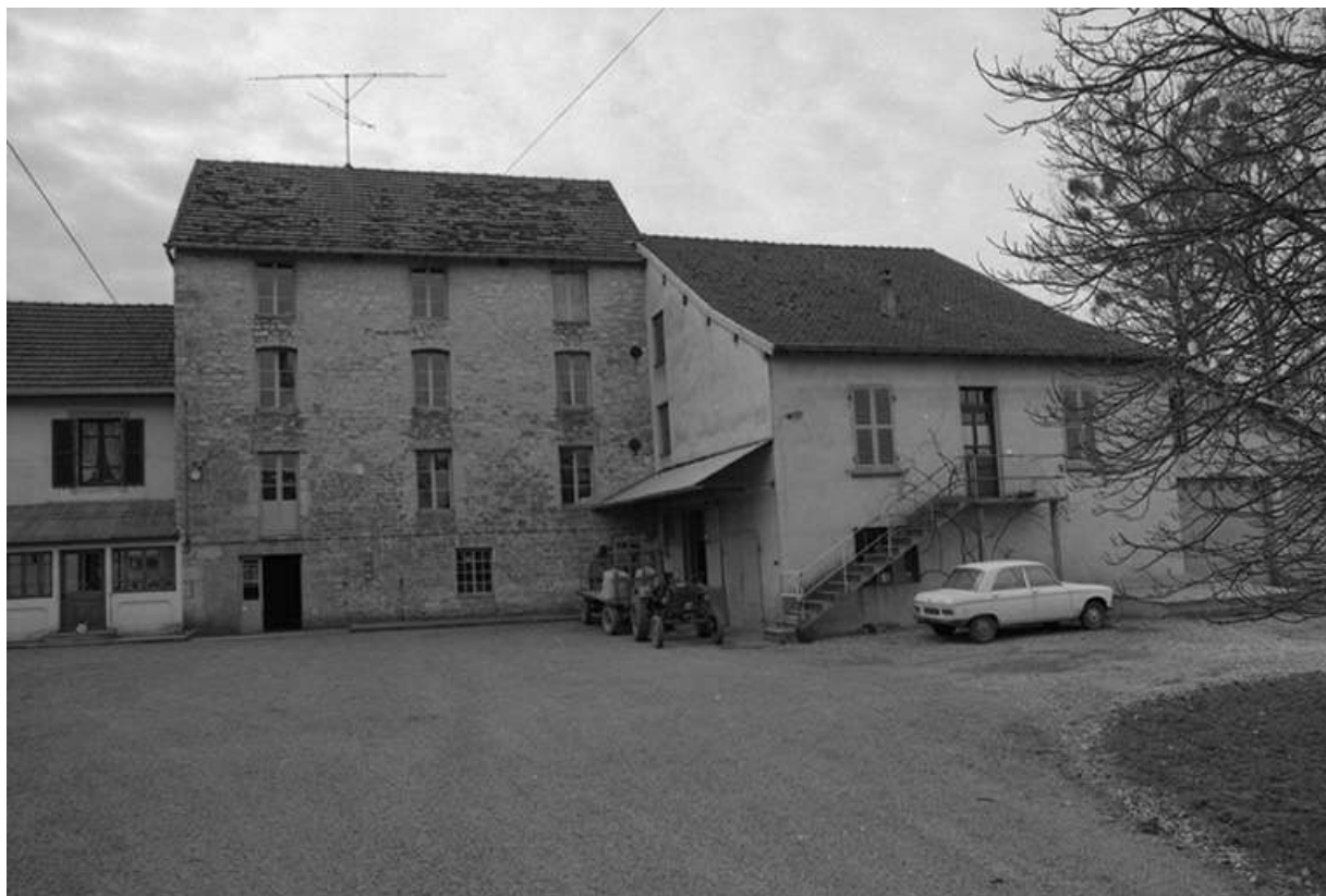
Façade nord du bâtiment.
