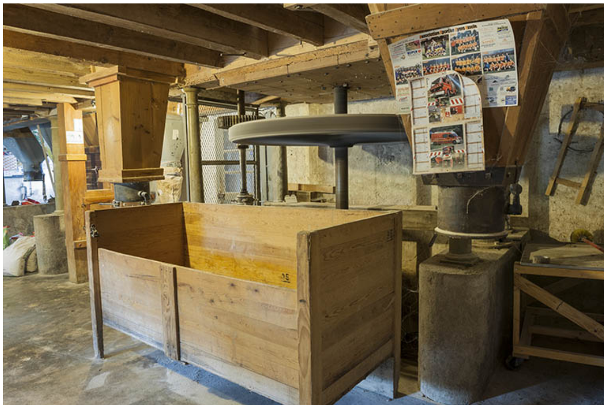
Rez-de-chaussée. Transmission par engrenages de la turbine.
