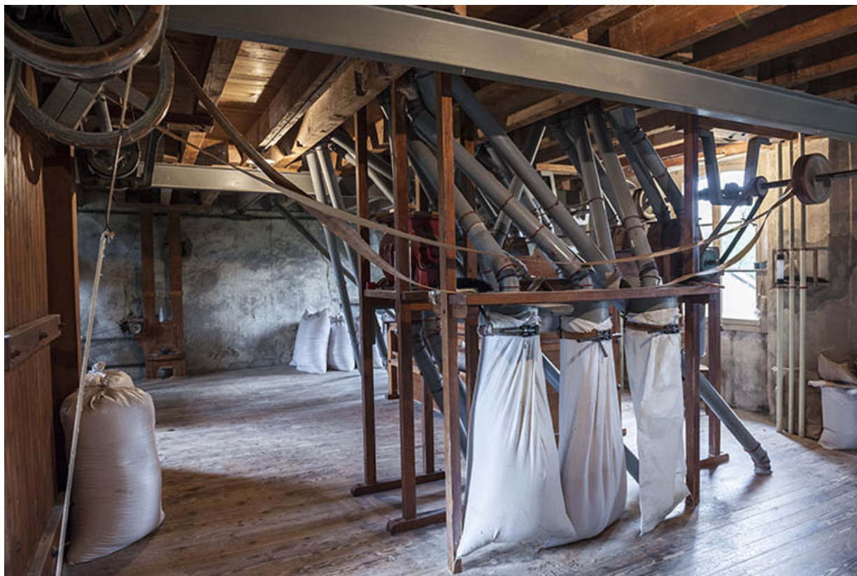
Troisième étage. Ensachage du son en sortie du plansichter.
