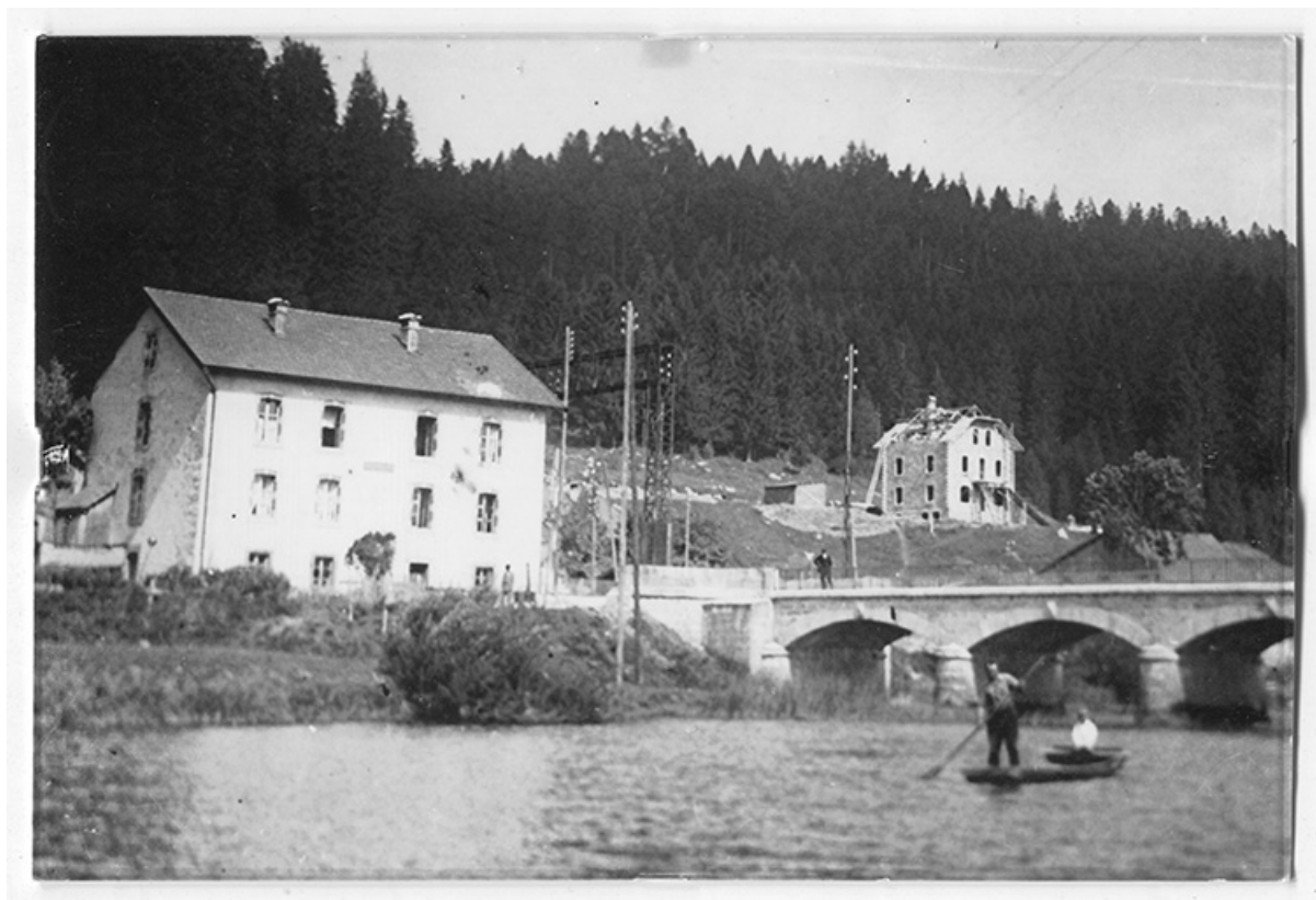
[La maison d'Emile Remonay en construction], vers 1925-1926.
