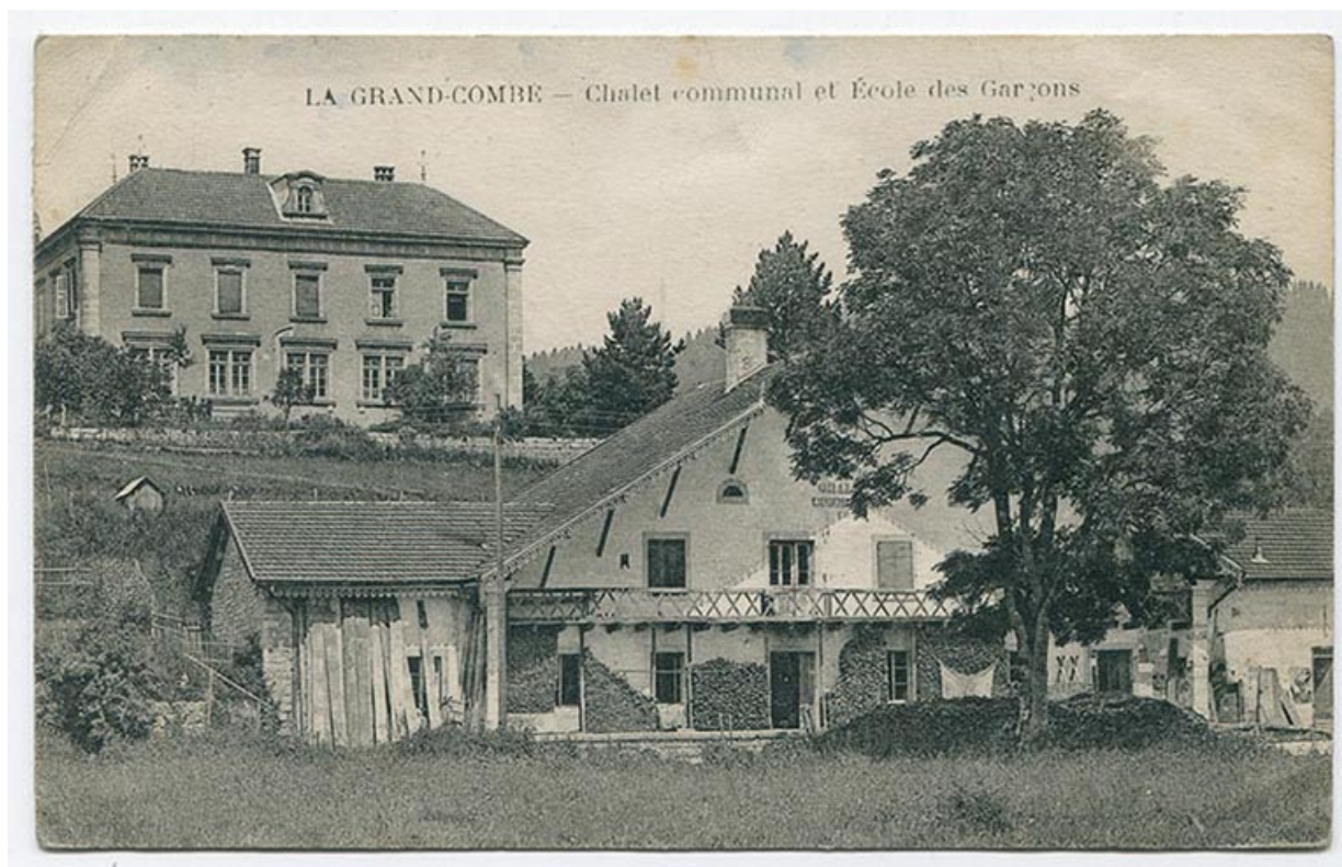
La Grand-Combe - Chalet communal et école des garçons, 1ère moitié 20e siècle [avant 1937]. 25, Grand'Combe-Châteleu, lieudit : le Beugnon
