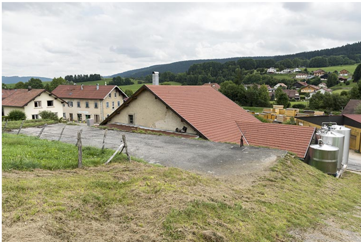
Façade postérieure, avec le dessus du réservoir au premier plan.
