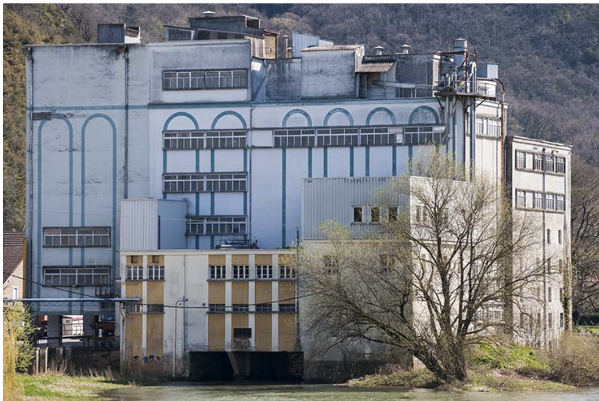
Vue rapprochée, depuis le sud-ouest.
