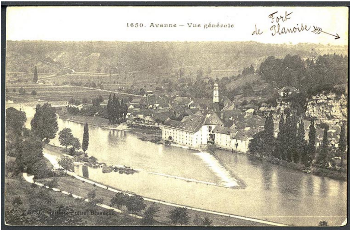
Avanne - Vue générale, carte postale, s.d. [fin 19e ou début 20e siècle]. 25, Avanne-Aveney, 2 rue du Moulin
