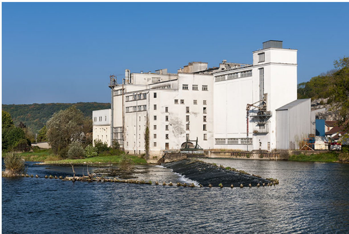
Vue de trois quarts, depuis la rive gauche.
