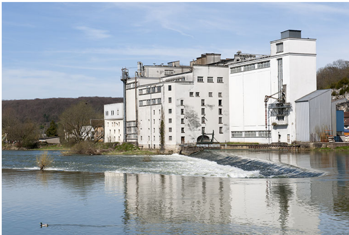
Le barrage et l'usine vue de trois quarts, depuis l'amont.
