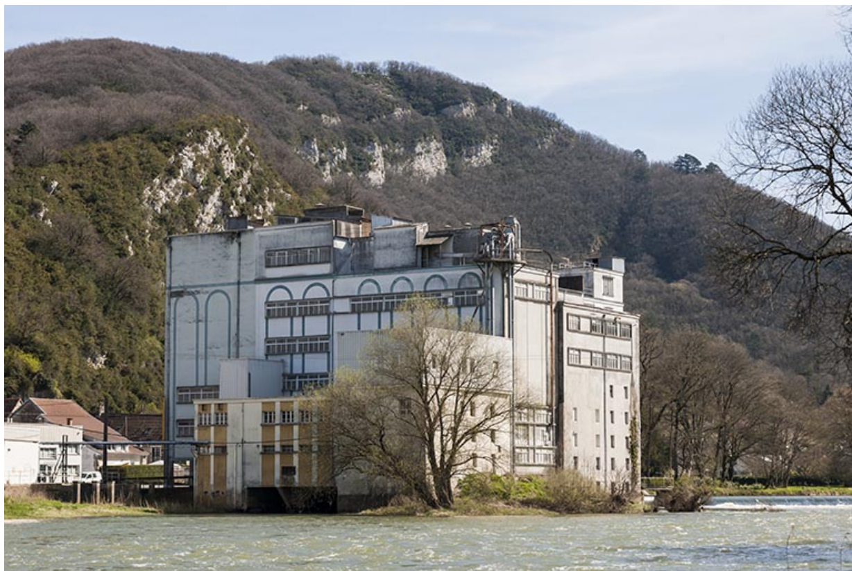
Vue de trois quarts, depuis le sud-ouest.
