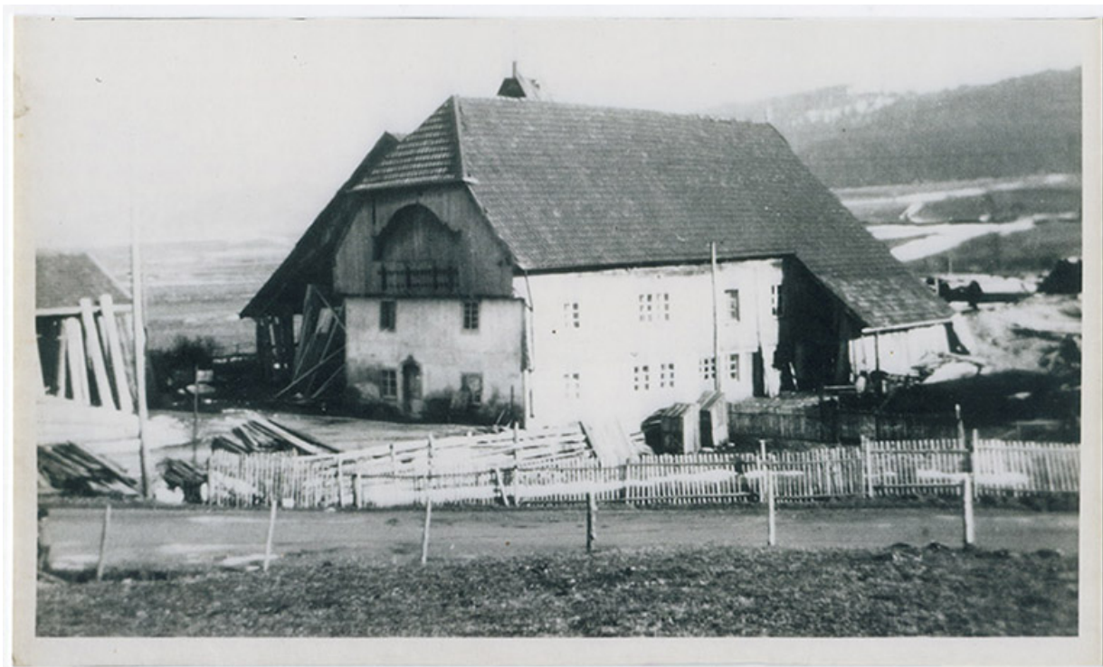
[La scierie Bertin, vue de trois quarts gauche], 2e quart 20e siècle ? 25, Grand'Combe-Châteleu
