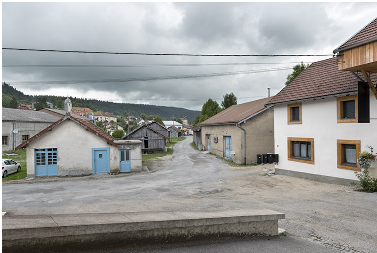
Cour, avec une dépendance à gauche, l'entrepôt de 1929 et la tournerie de manches à droite. 25, Grand'Combe-Châteleu, 5-9 Pré Rondot
