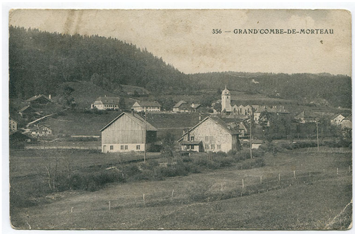
356 - Grand'Combe-de-Morteau, 1er quart 20e siècle [avant 1909].
