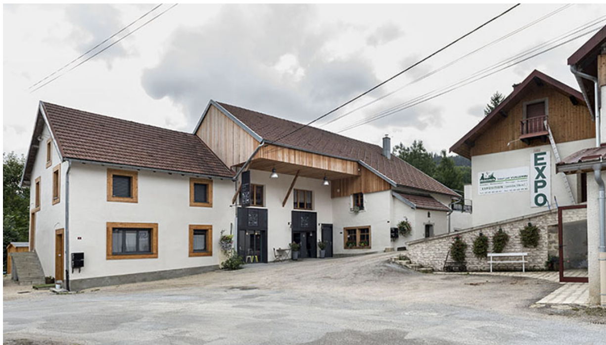
Taillanderie et tournerie Vuillemin (le Pré Rondot). Le ruisseau du Théverot passe derrière les bâtiments de la tournerie de manches (à gauche) et de la taillanderie (au centre).
