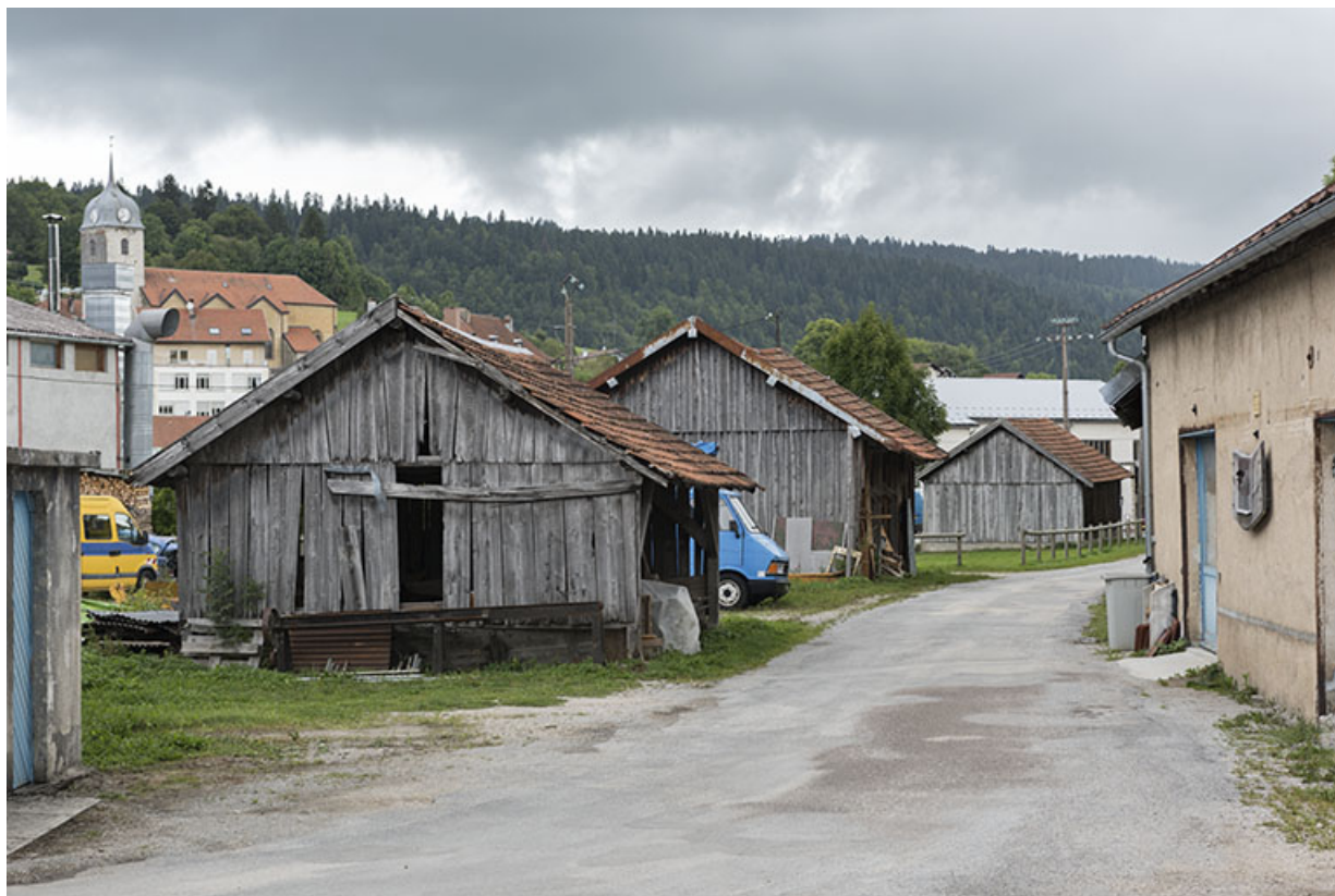
Dépendance, séchoir à bois et entrepôt de 1929, vus depuis la cour au sud. 25, Grand'Combe-Châteleu, 5-9 Pré Rondot
