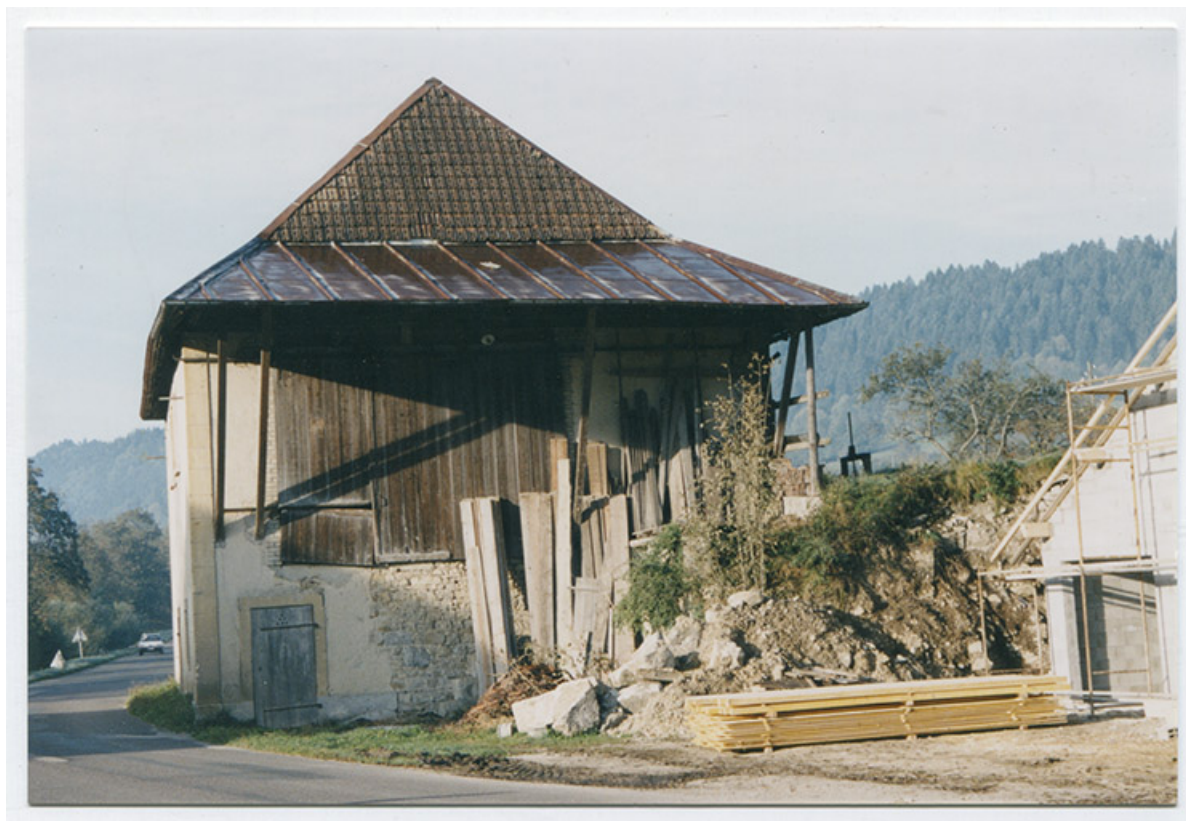
Mur pignon nord-est de la scierie, en 1991 ou 1994.
