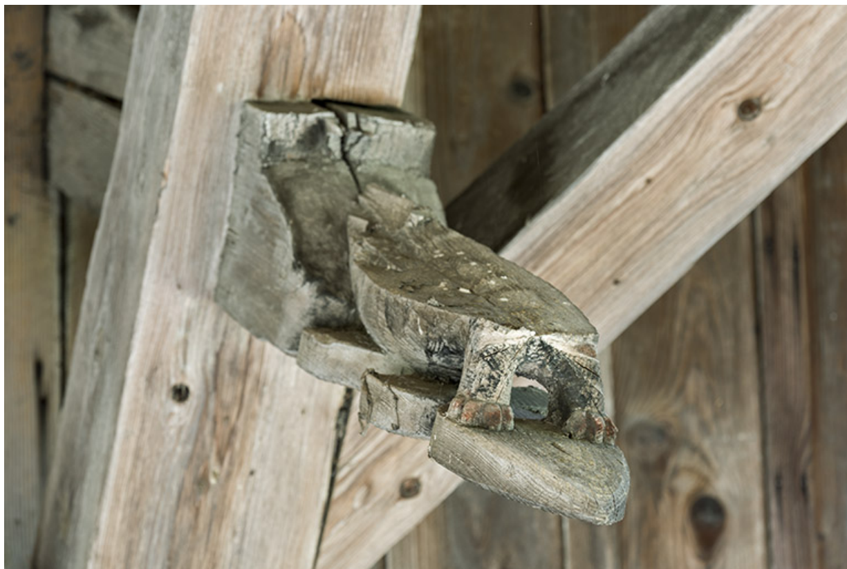
Ferme, façade latérale droite : 4e arbalétrier (à droite) sculpté en forme d'animal non identifié. 25, Grand'Combe-Châteleu, lieudit : les Forges
