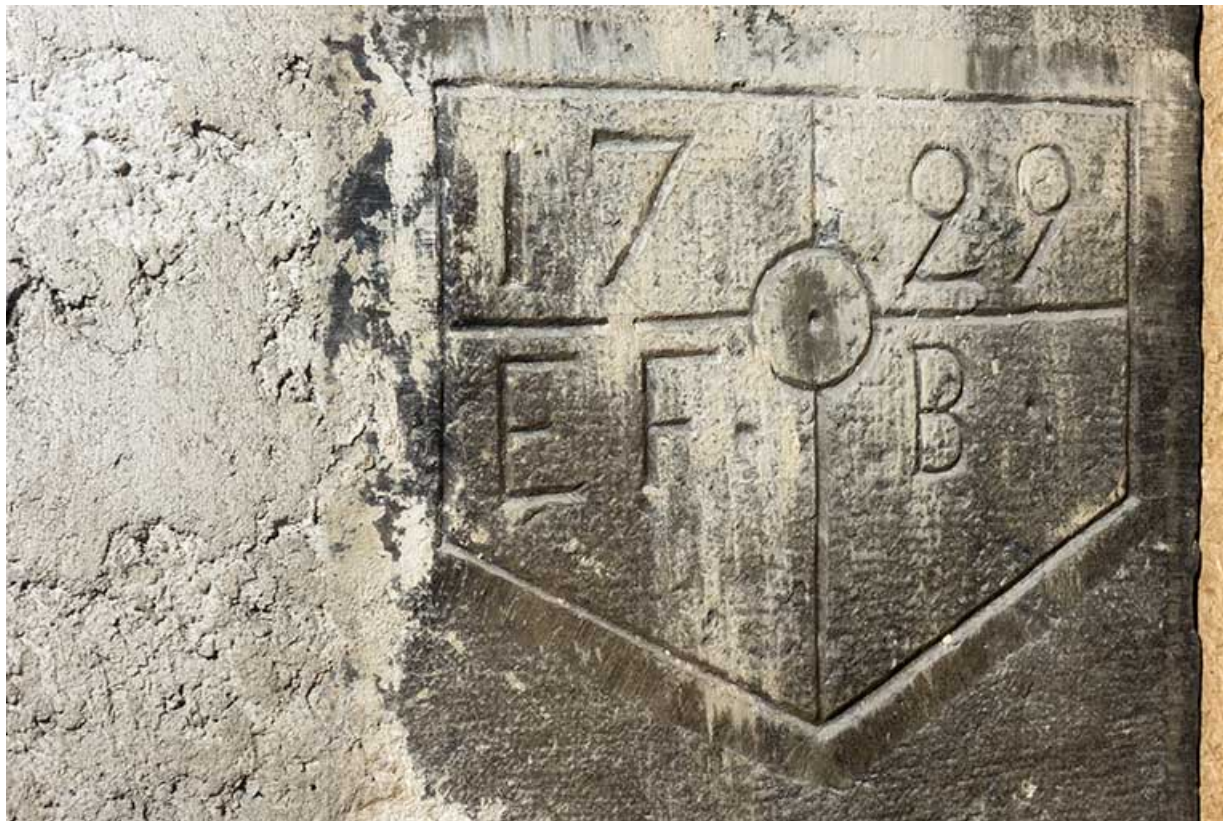
Ferme : date 1729 et initiales EFB, gravées sur un côté de l'ouverture du four à pain.
