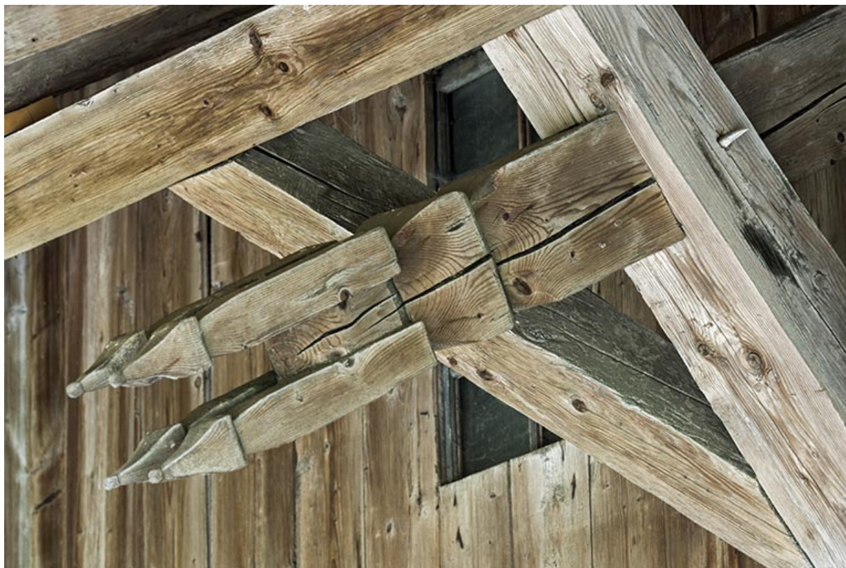
Ferme, façade latérale droite : 3e arbalétrier sculpté d'un motif à quatre pointes.
