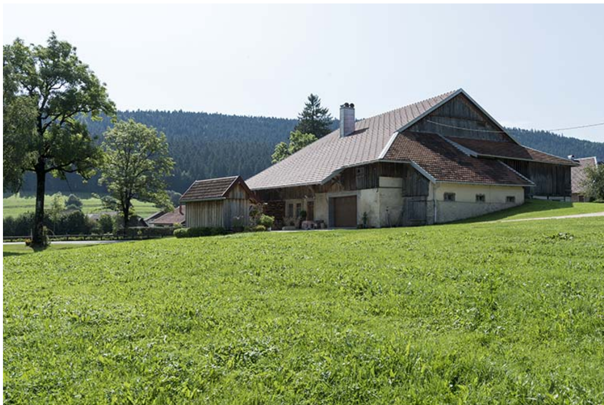
Ferme : façades postérieure et latérale droite.
