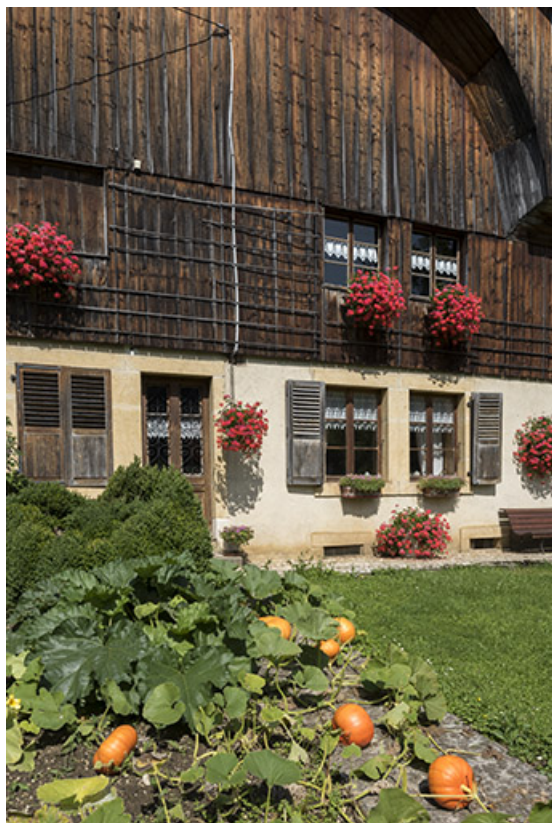
Ferme, façade antérieure : baies et lambrichure.
