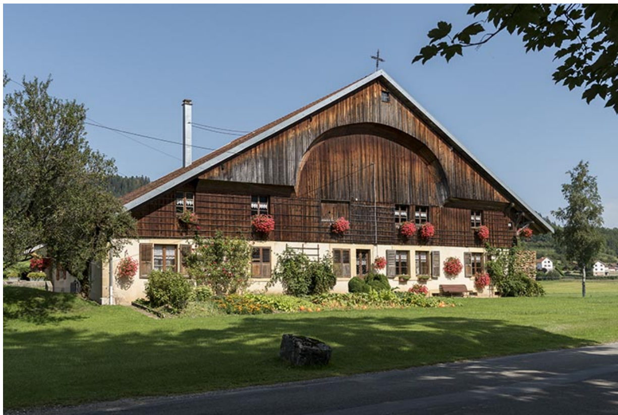
Ferme : façade antérieure, de trois quarts gauche.
