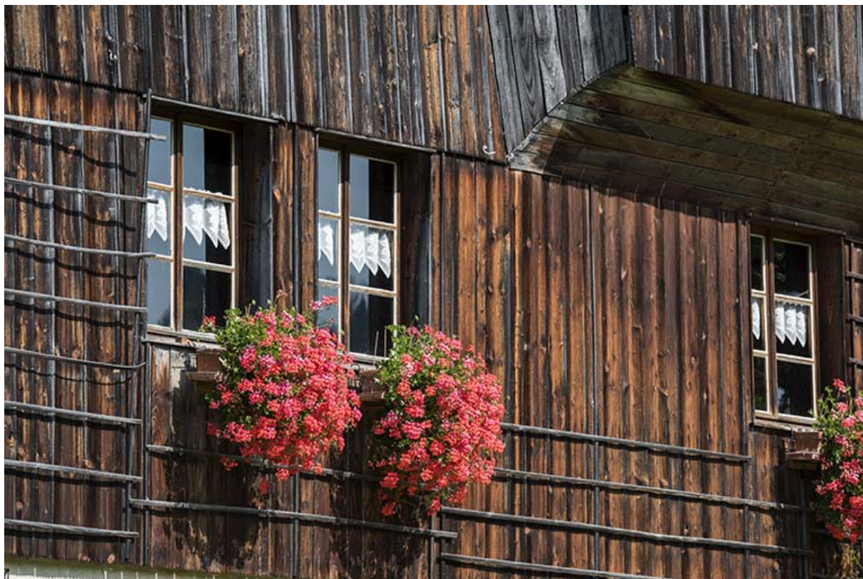
Ferme, façade antérieure : fenêtres horlogères de l'étage en surcroît.
