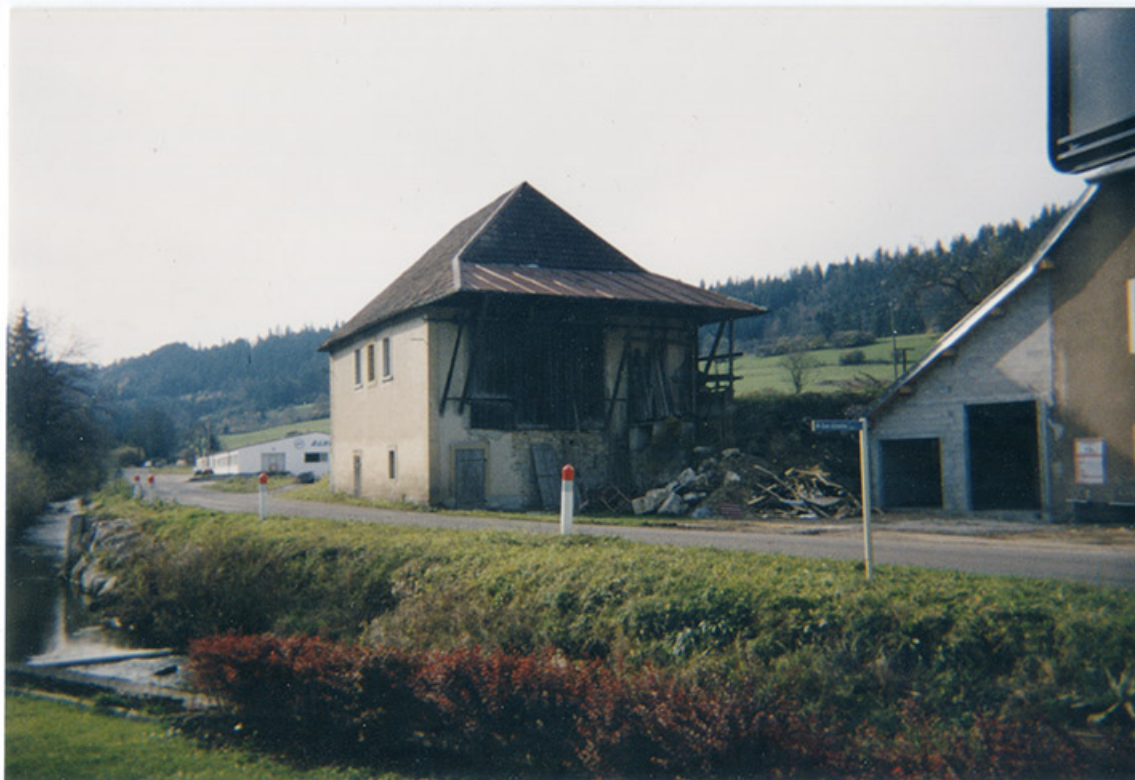
La scierie vue de l'est, en novembre 1994. 25, Grand'Combe-Châteleu, lieudit : les Forges
