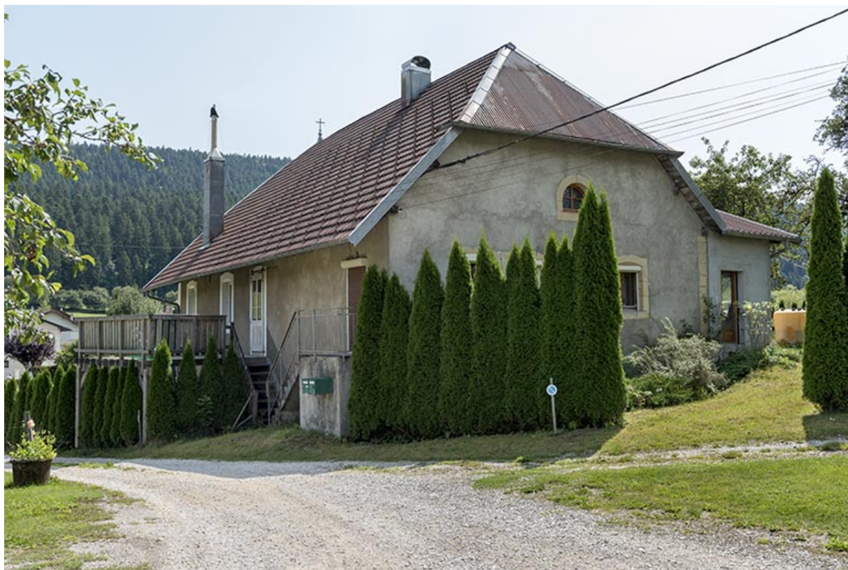
Taillanderie : façades antérieure et latérale droite.
