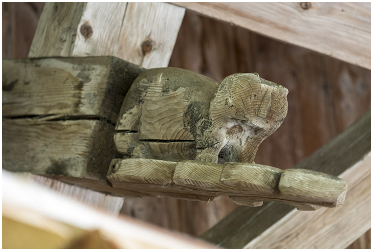
Ferme, façade latérale droite : 2e arbalétrier sculpté en forme de chat (?).
