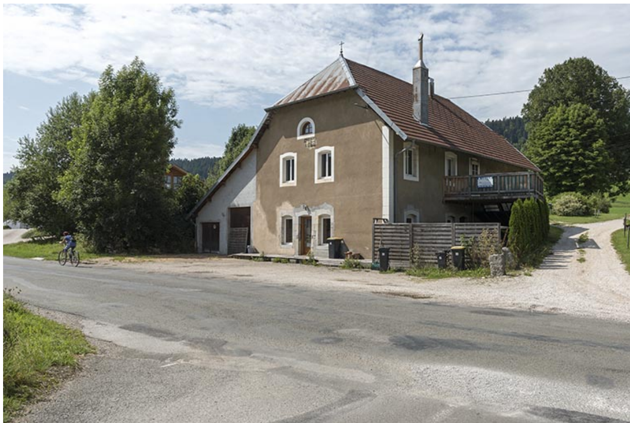
Taillanderie et scierie Bobillier (les Forges ou la Malepierre). Le bosquet à gauche marque l'emplacement du bassin de retenue et de la scierie détruite, le bâtiment à droite est celui de la taillanderie.
