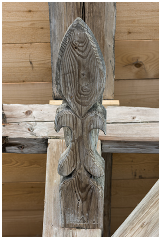
Ferme, façade latérale droite : 4e arbalétrier (à droite) vu par-dessous. 25, Grand'Combe-Châteleu, lieudit : les Forges
