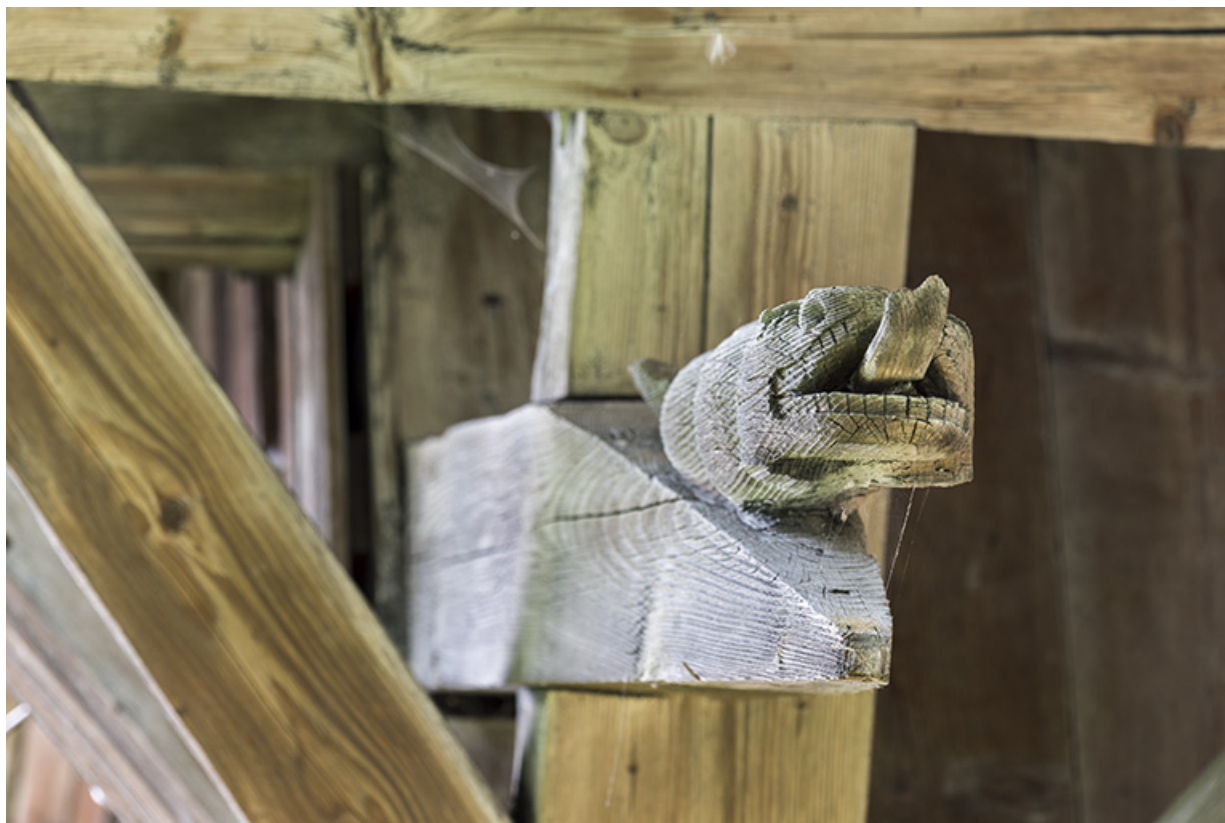
Ferme, façade latérale droite : 1er arbalétrier sculpté en forme de serpent, vu de face. 25, Grand'Combe-Châteleu, lieudit : les Forges
