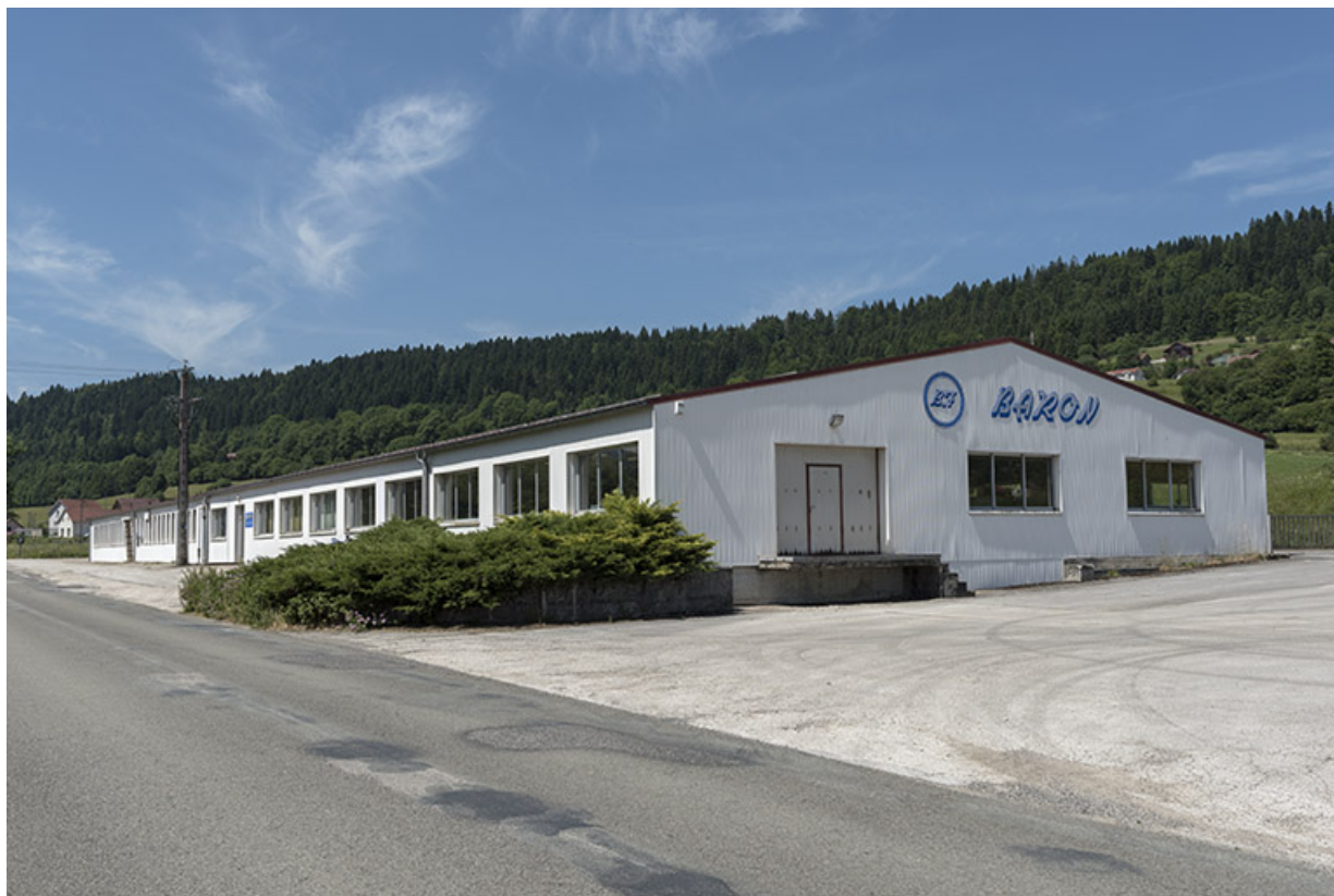
Vue d'ensemble depuis l'est (façades antérieure et latérale droite). 25, Grand'Combe-Châteleu, 10 rue des Forges, lieudit : les Forges
