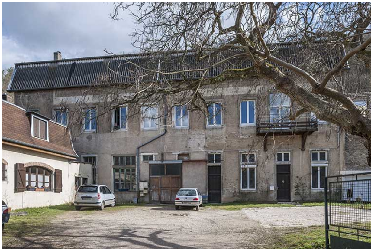
Façade antérieure de l'atelier de fabrication.
