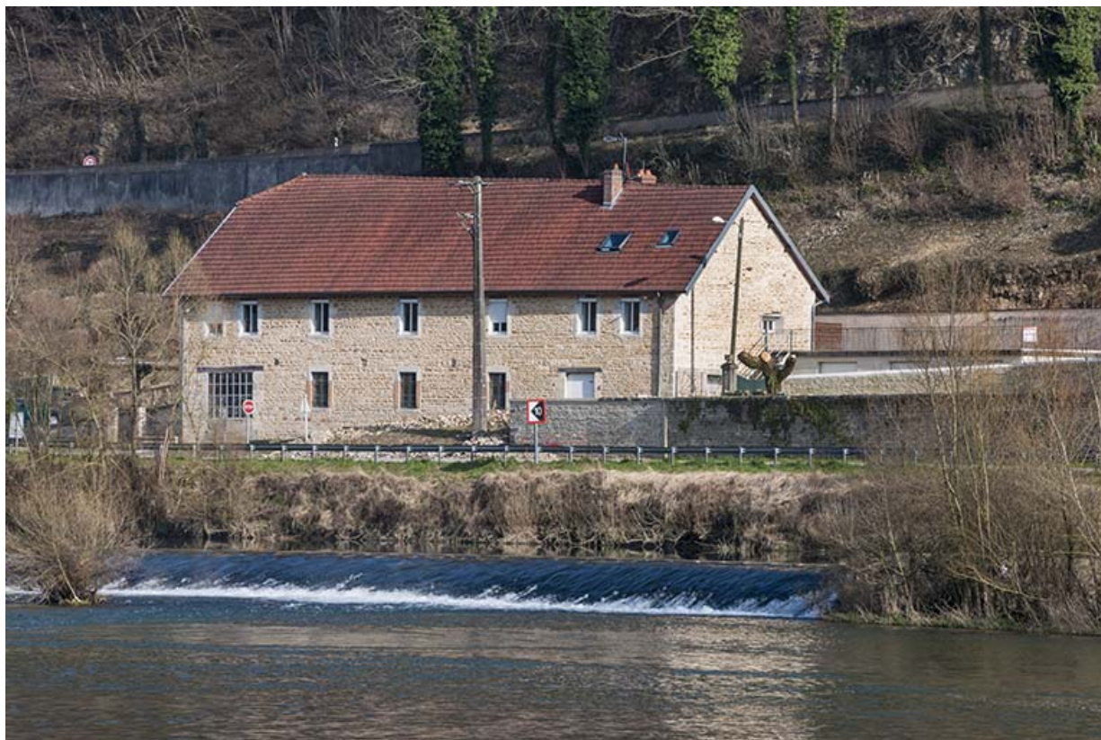
Bâtiment abritant des logements, les écuries et remises.
