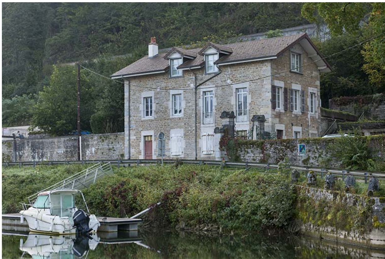
La conciergerie vue depuis l'ouest.
