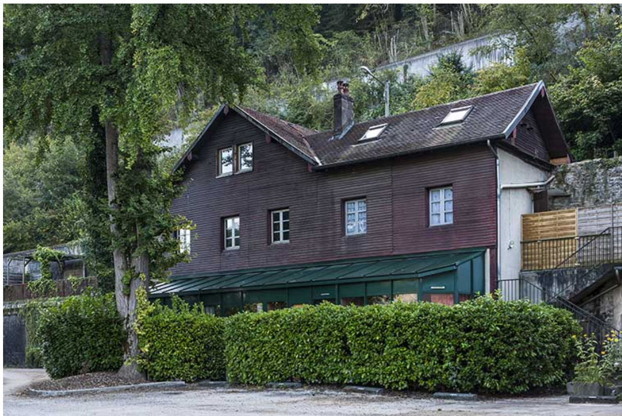
Logement vu de trois quarts droite.
