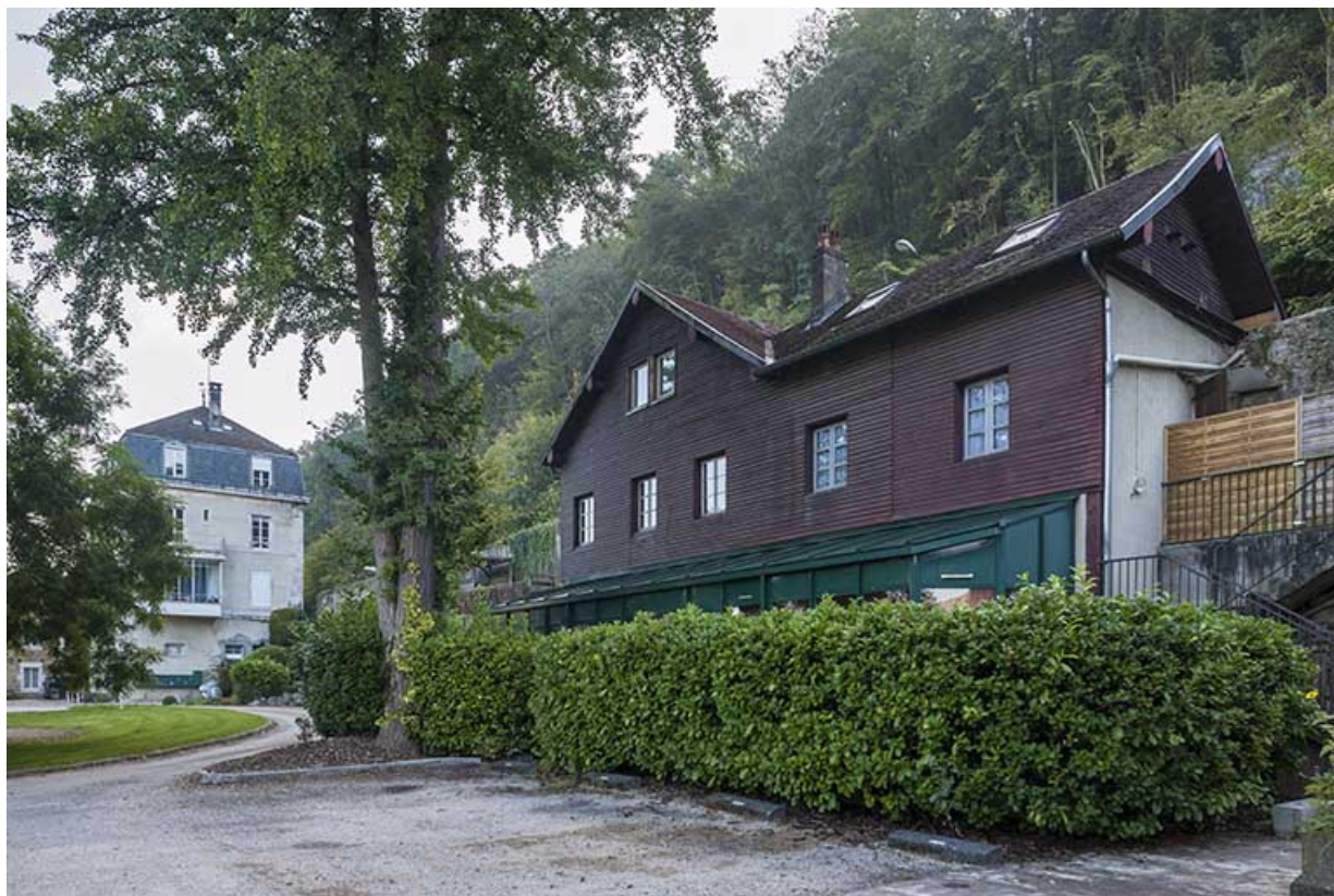
Logement patronal et logement (remanié). 25, Beure rue Paul Dubourg
