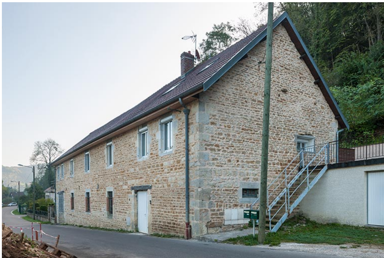
Bâtiment des logements, écuries et remises vu de trois quarts.
