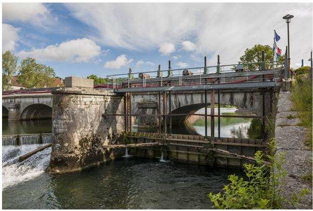
Vanne de décharge à l'extrémité nord du barrage.
