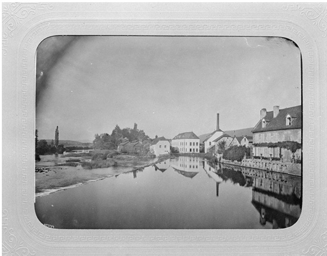
Vue d'ensemble depuis le pont, 1899-1900. 25, Quingey rue des Forges
