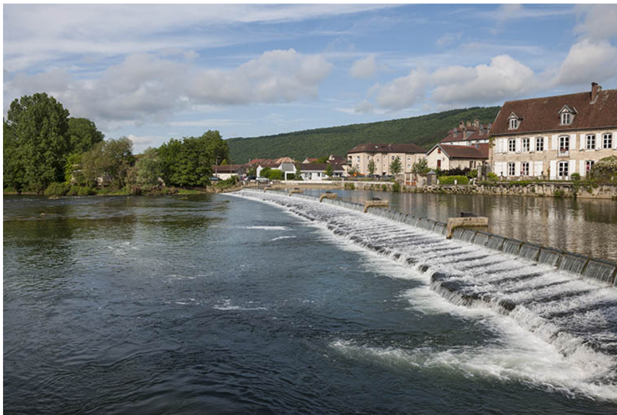
Vue du barrage depuis le pont.
