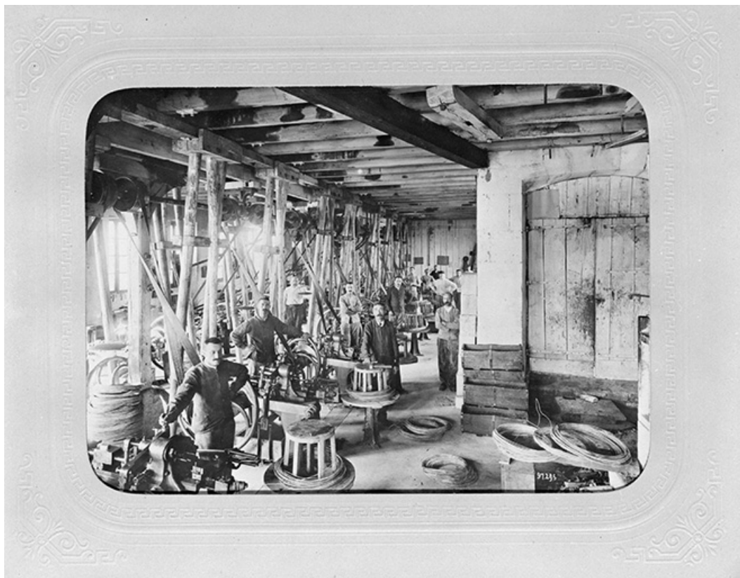
Intérieur d'un atelier de fabrication (tréfilerie ou clouterie), 1899-1900.
