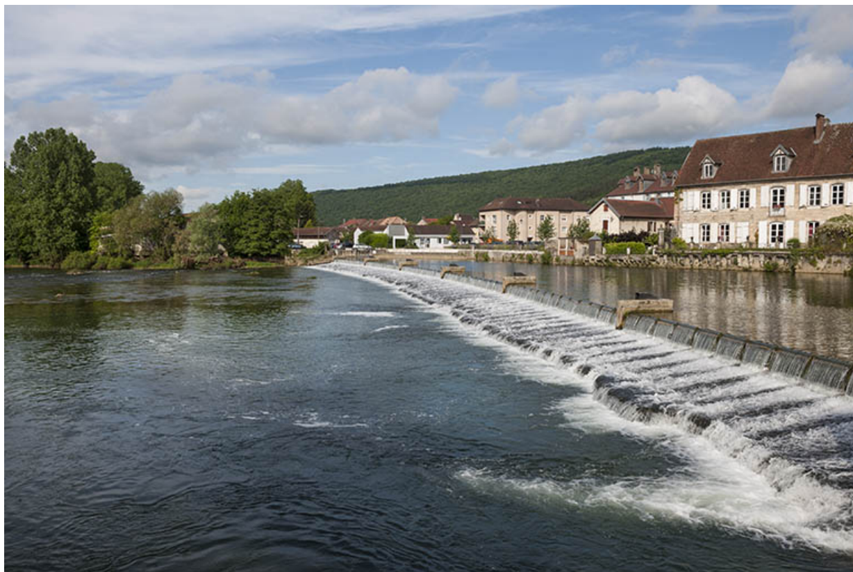
Vue du barrage depuis le pont.
