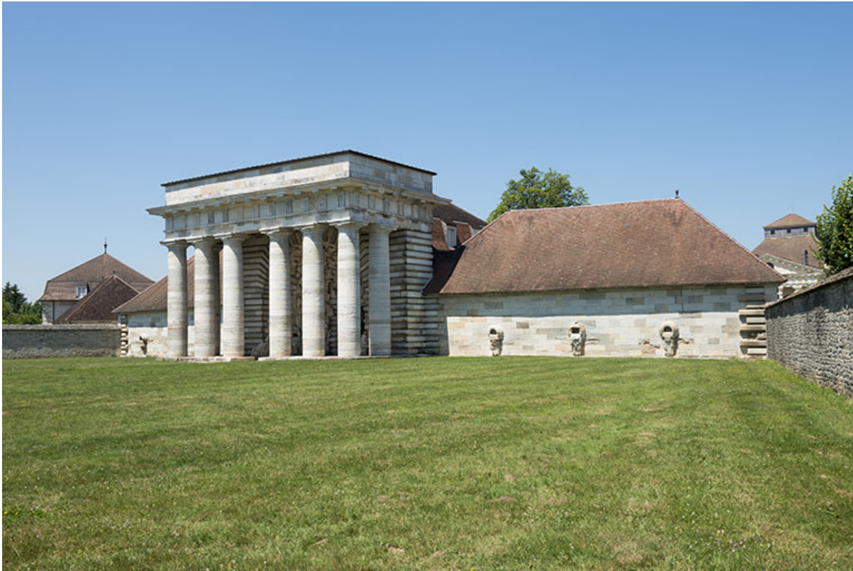
Bâtiment d'entrée. Vue de trois quarts droite.
