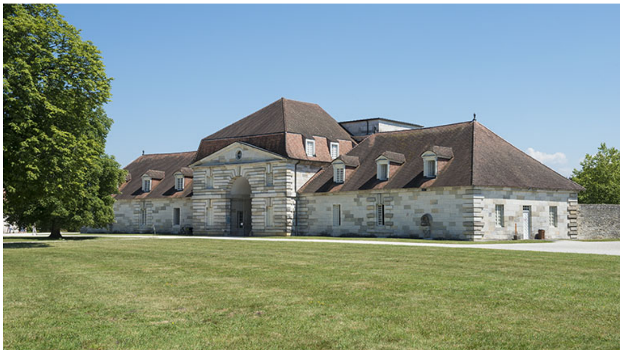
Vue de trois quarts droite du bâtiment d'entrée.
