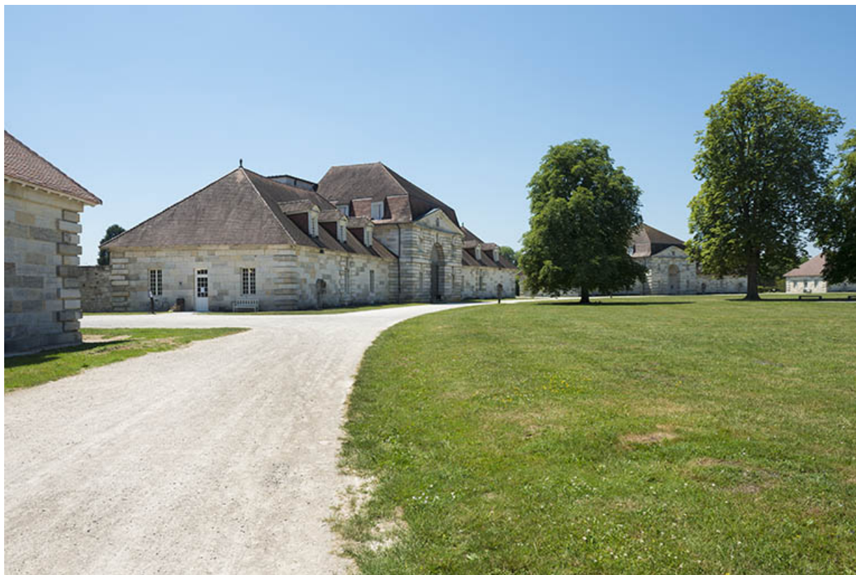
Bâtiment d'entrée. Vue de trois quarts depuis la cour.
