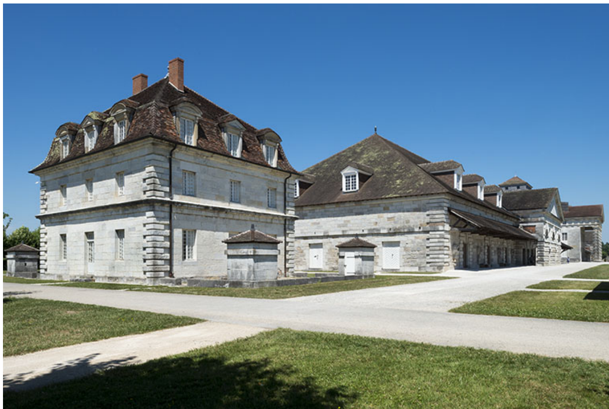
Maison des commis, berne et maison du directeur depuis le sud-ouest. 25, Arc-et-Senans Grande Rue
