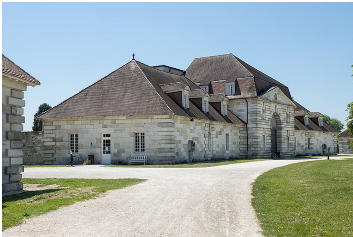
Bâtiment d'entrée. Vue rapprochée depuis le nord. 25, Arc-et-Senans Grande Rue
