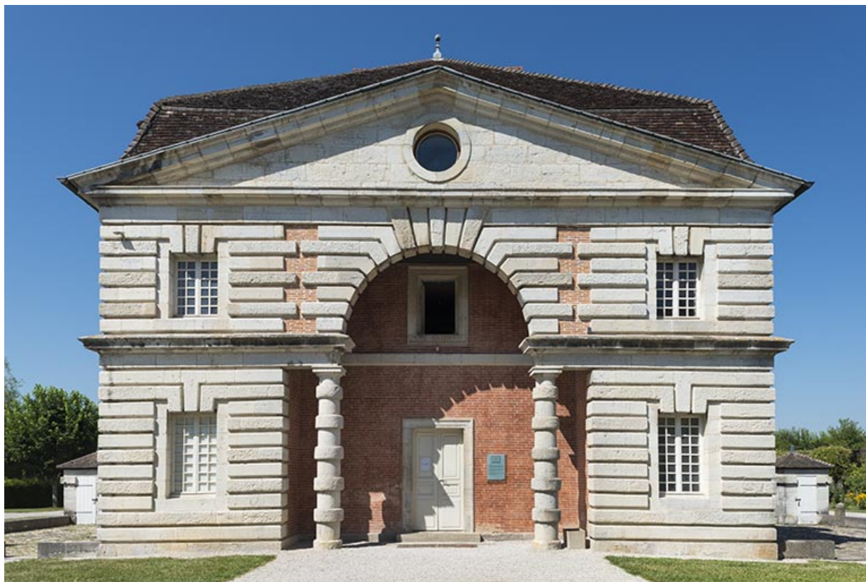
Maison des commis ouest. Façade antérieure. 25, Arc-et-Senans Grande Rue
