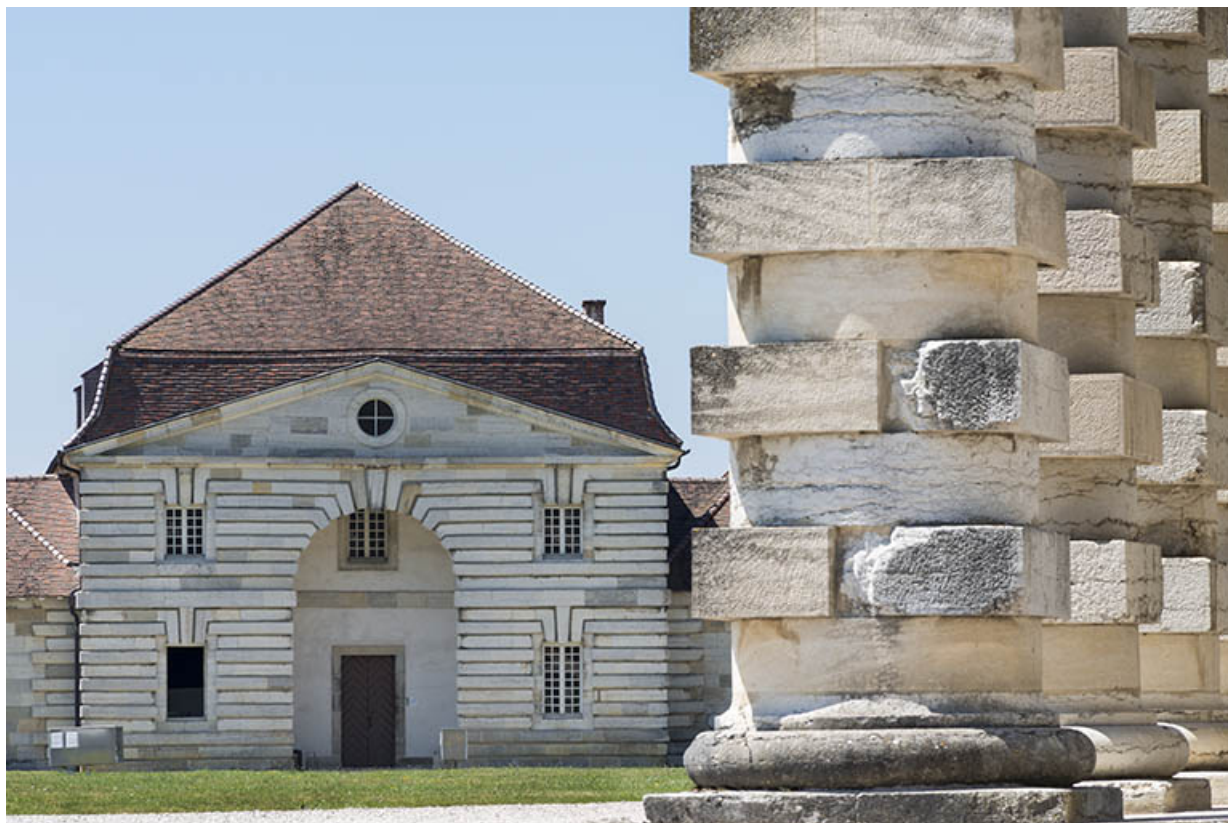
Pavillon du logement des ouvriers (berniers) ouest, depuis la maison du directeur. 25, Arc-et-Senans Grande Rue
