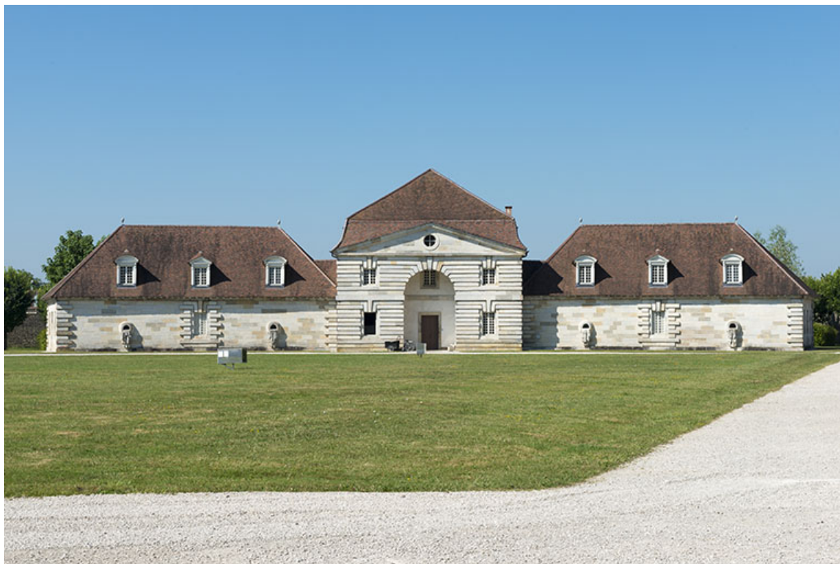
Logement des ouvriers (berniers) ouest. Vue de face.
