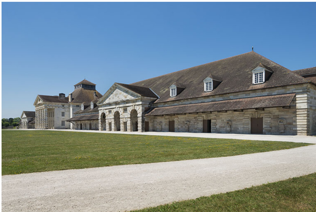
Les bernes et la maison du directeur vues depuis l'est.
