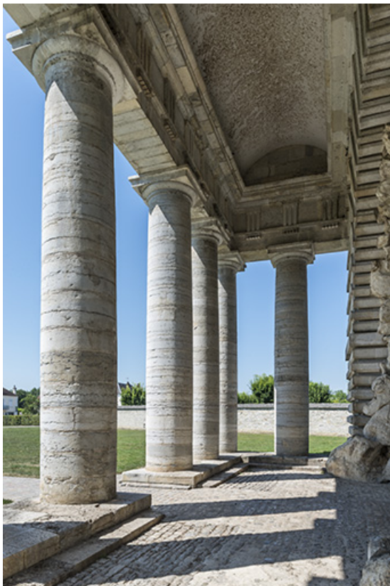
Détail du portique d'entrée.
