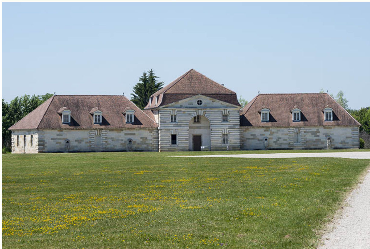
Logement des ouvriers (barniers) ouest, depuis le nord-est. 25, Arc-et-Senans Grande Rue
