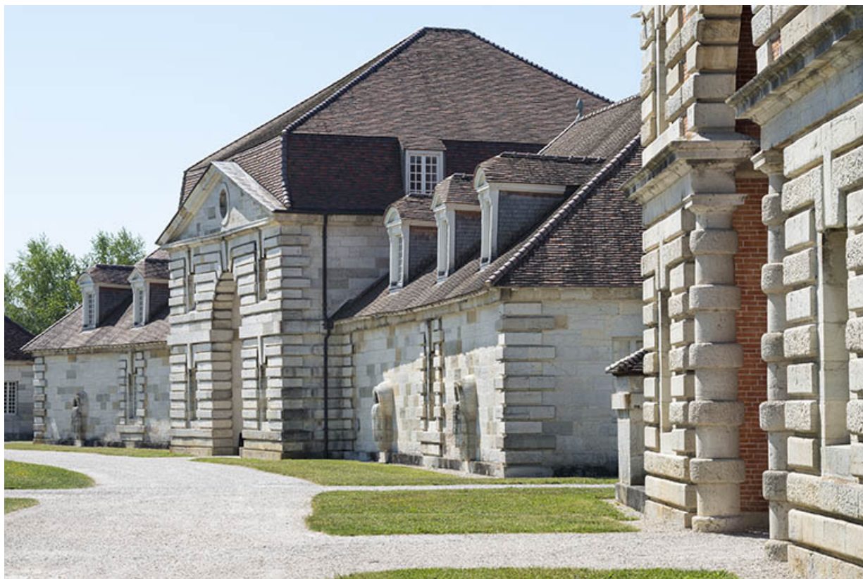
Logement des ouvriers (barniers) ouest. Façade antérieure depuis le nord-ouest. 25, Arc-et-Senans Grande Rue
