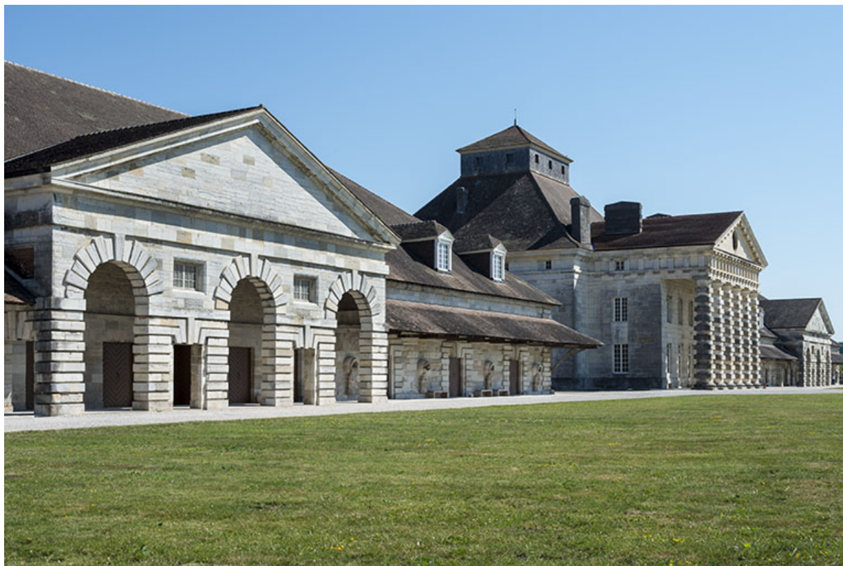
Les bernes de part et d'autre de la maison du directeur, depuis le sud-ouest. 25, Arc-et-Senans Grande Rue
