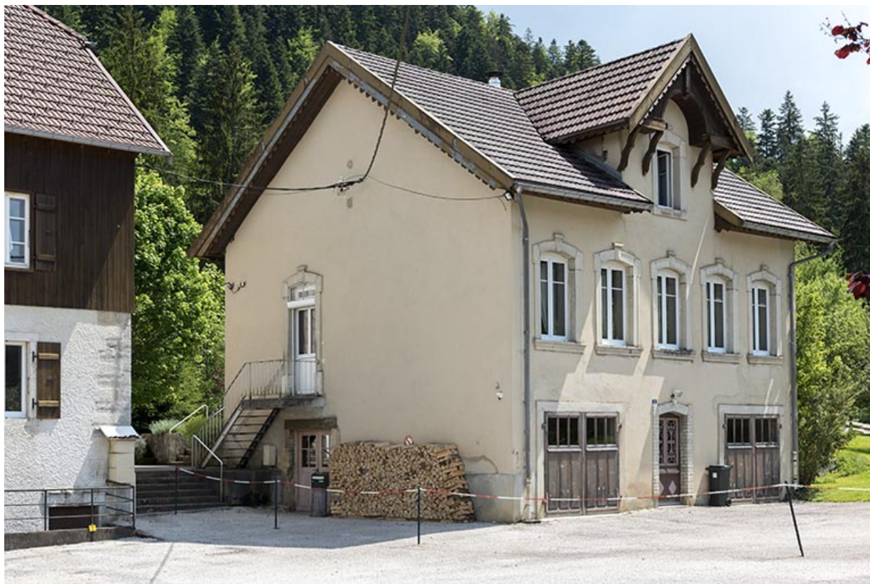
Maison : façades antérieure et latérale gauche.
