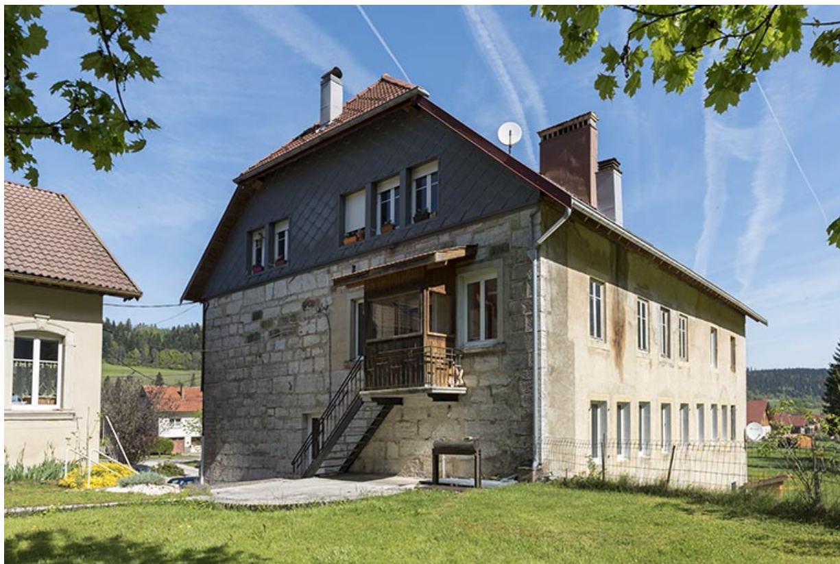
Chaudronnerie : façades postérieure et latérale gauche.
