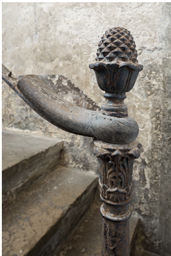
Chaudronnerie : motif d'amortissement de la rampe d'appui de l'escalier.
