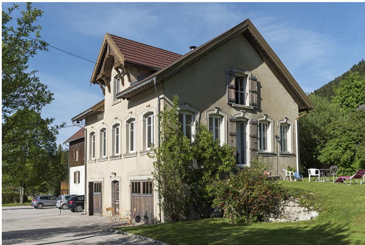
Maison : façades antérieure et latérale droite.
