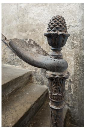
${\bf Chaudronnerie: motif\ d'amortissement\ de\ la\ rampe\ d'appui\ de\ l'escalier.}$
