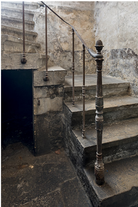
Chaudronnerie : rampe d'appui de l'escalier, au sous-sol.
