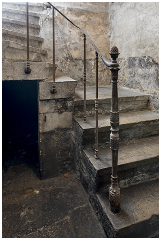
Chaudronnerie : rampe d'appui de l'escalier, au sous-sol.
