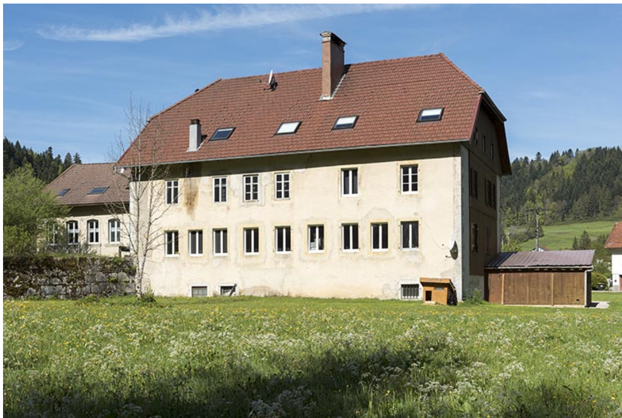
Chaudronnerie : façade postérieure, de trois quarts droite. 25, Les Gras
