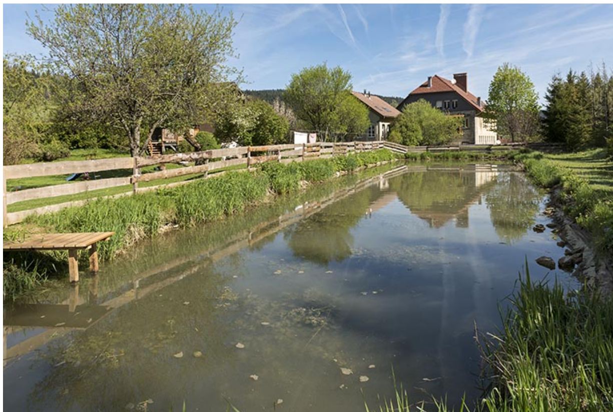
Vue d'ensemble depuis le sud : bassin de retenue au premier plan, maison et chaudronnerie à l'arrière-plan. 25, Les Gras, 8-10 rue les Saules, lieudit : les Saules
