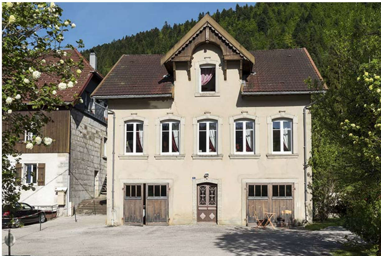
Maison : façade antérieure.
