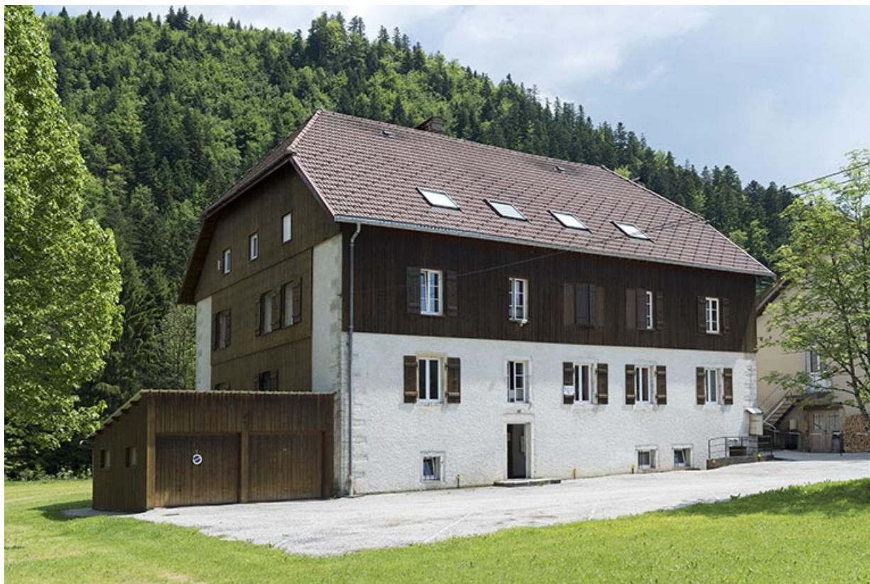
Chaudronnerie : façades antérieure et latérale gauche.
