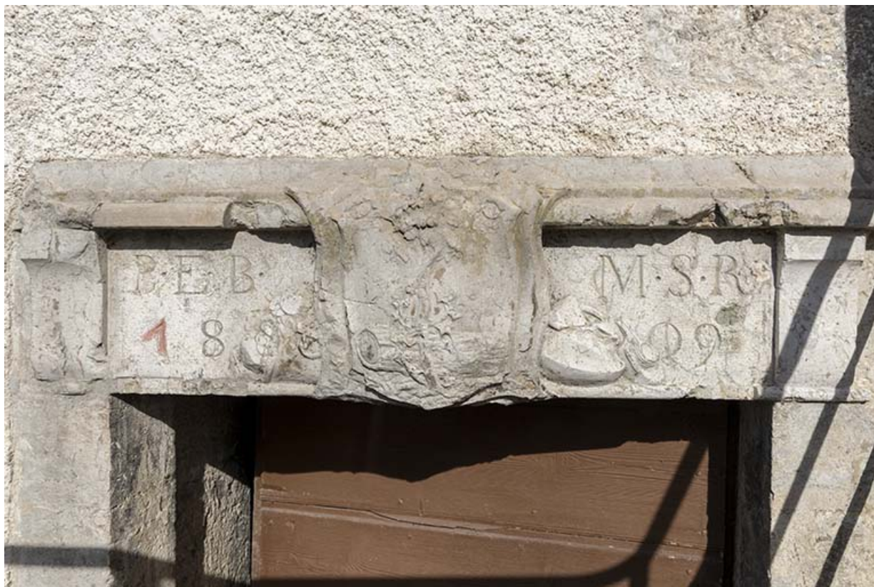
Chaudronnerie, façade antérieure : linteau daté 1809.
