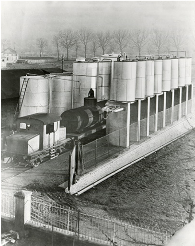
Batterie de réservoirs industriels au sud du site. Chargemen des wagons-citernes, fotogr., s.d. [milieu 20e siècle]. 25, Roche-lez-Beaupré, 48 route Nationale
