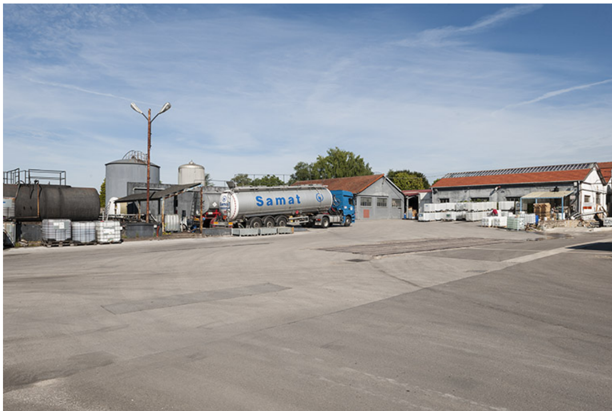
Vue d'ensemble depuis la cour, au sud-est. 25, Roche-lez-Beaupré, 48 route Nationale
