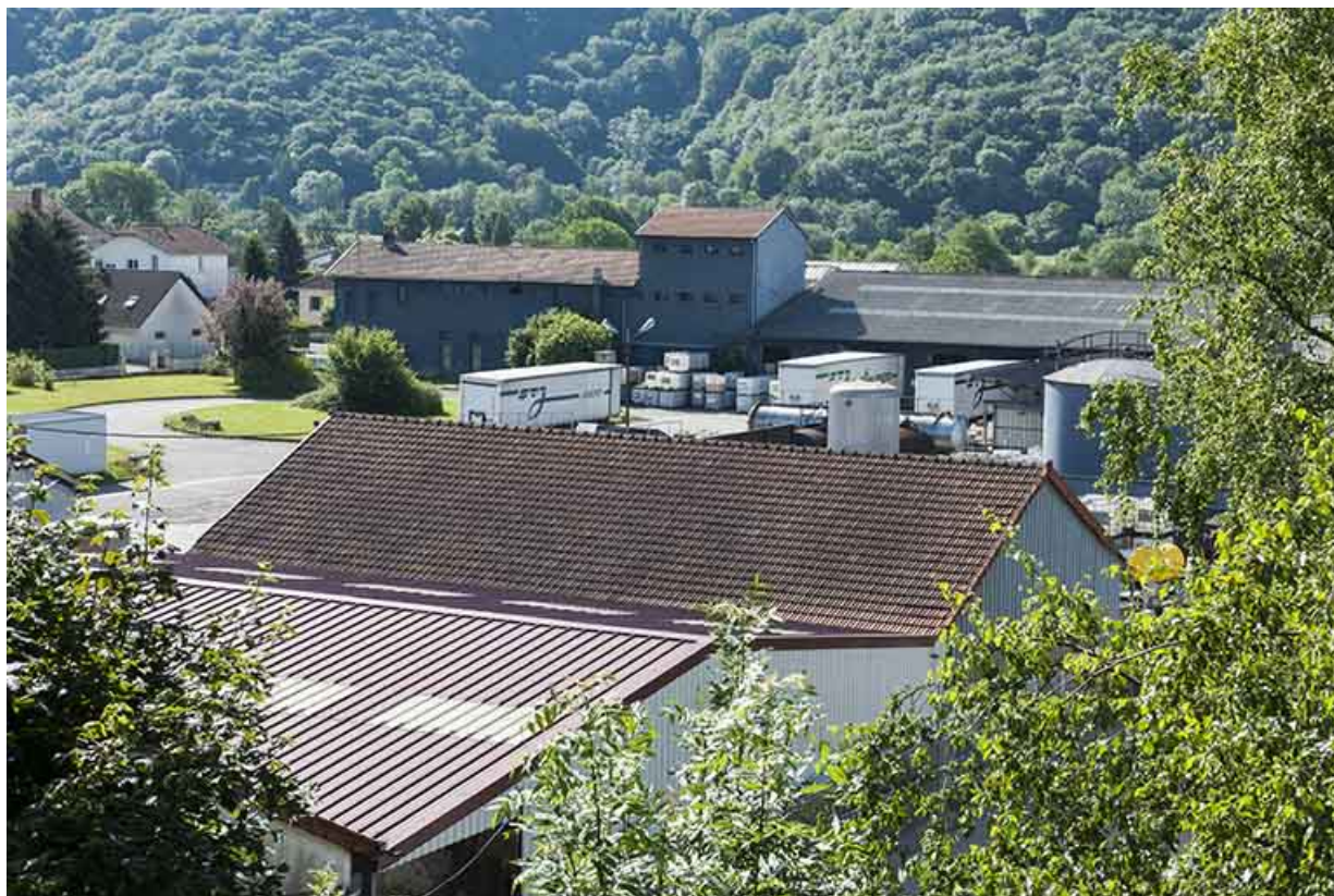
Vue plongeante sur les bâtiments sud (ancien atelier de dénatration).
