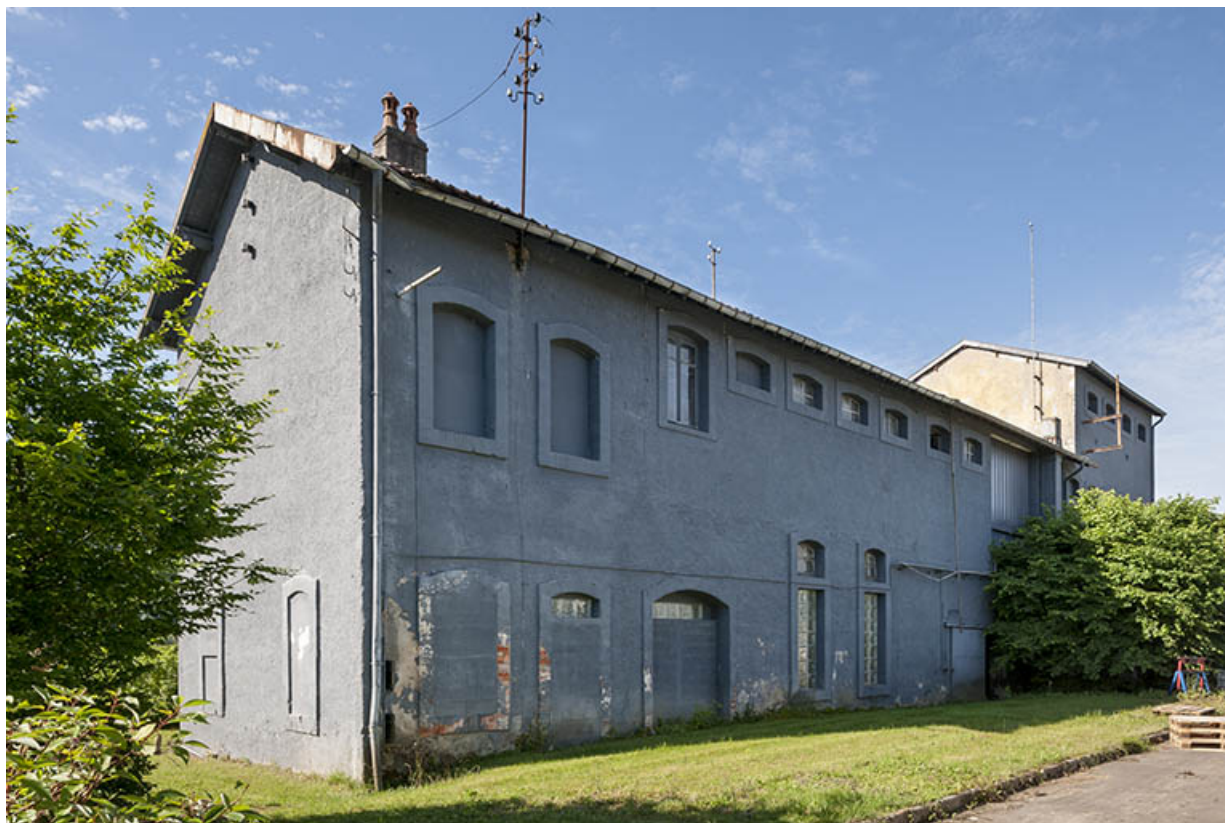
Ancien atelier de dénaturation des alcools et de conditionnement. Vue de trois quarts.
