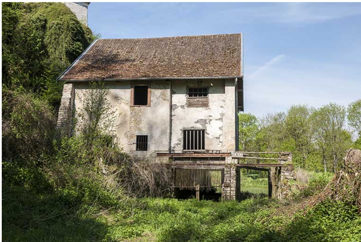
Façade est, depuis le bief d'aménée (à sec). 25, Rigney, lieudit : Château de la Roche
