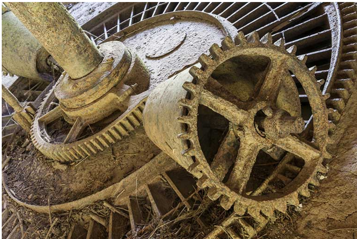
Détail de la partie supérieure de la turbine.
