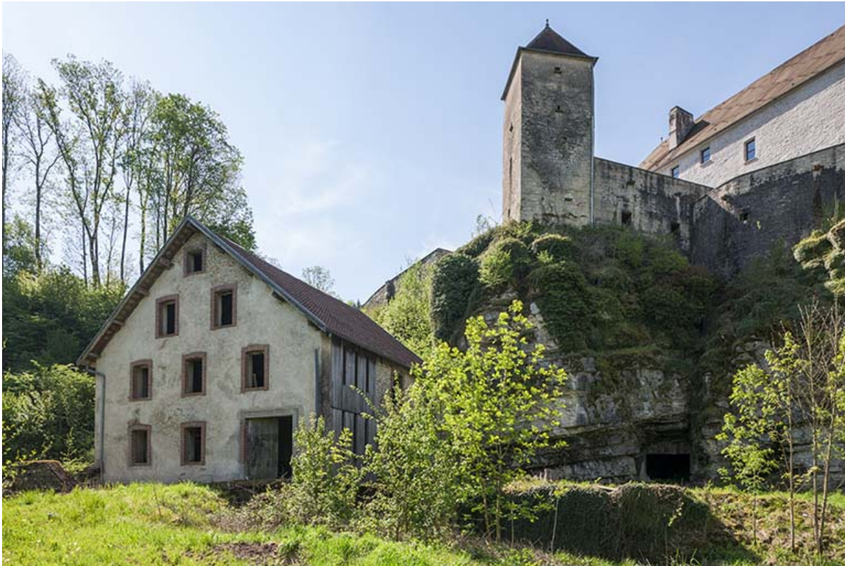
Le moulin et le château de la Roche, depuis le nord-ouest.
