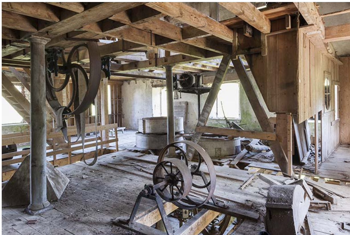
Premier étage. Vue d'ensemble depuis le sud-est.
