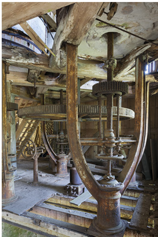
Rez-de-chaussée. Les colonnes "en lyre" du beffroi. 25, Rigney, lieudit : Château de la Roche
