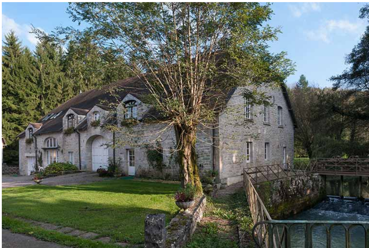
Bâtiment du moulin. Vue de trois quarts droite.
