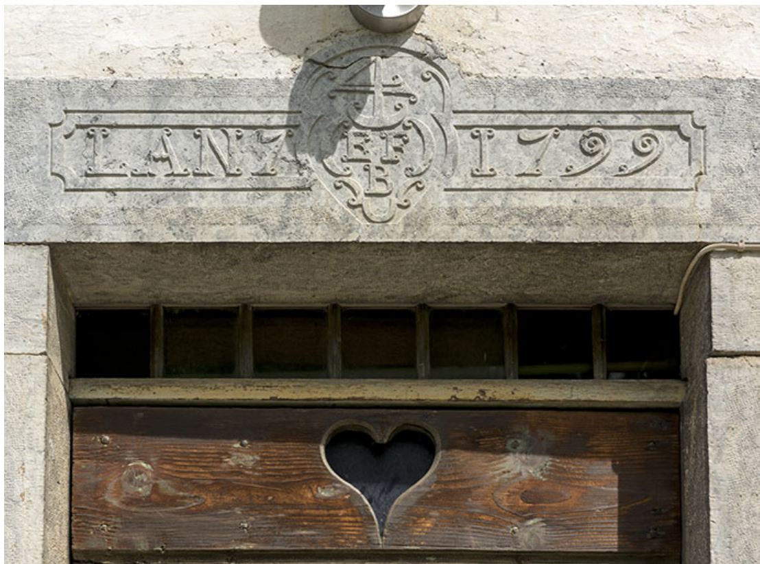
Façade antérieure : linteau daté 1799.
