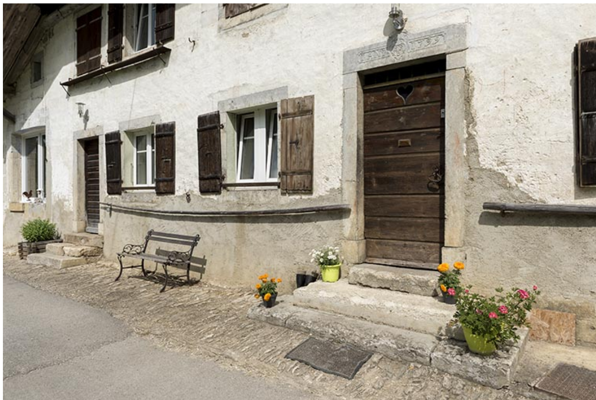
Façade antérieure : portes et fenêtres au rez-de-chaussée.
