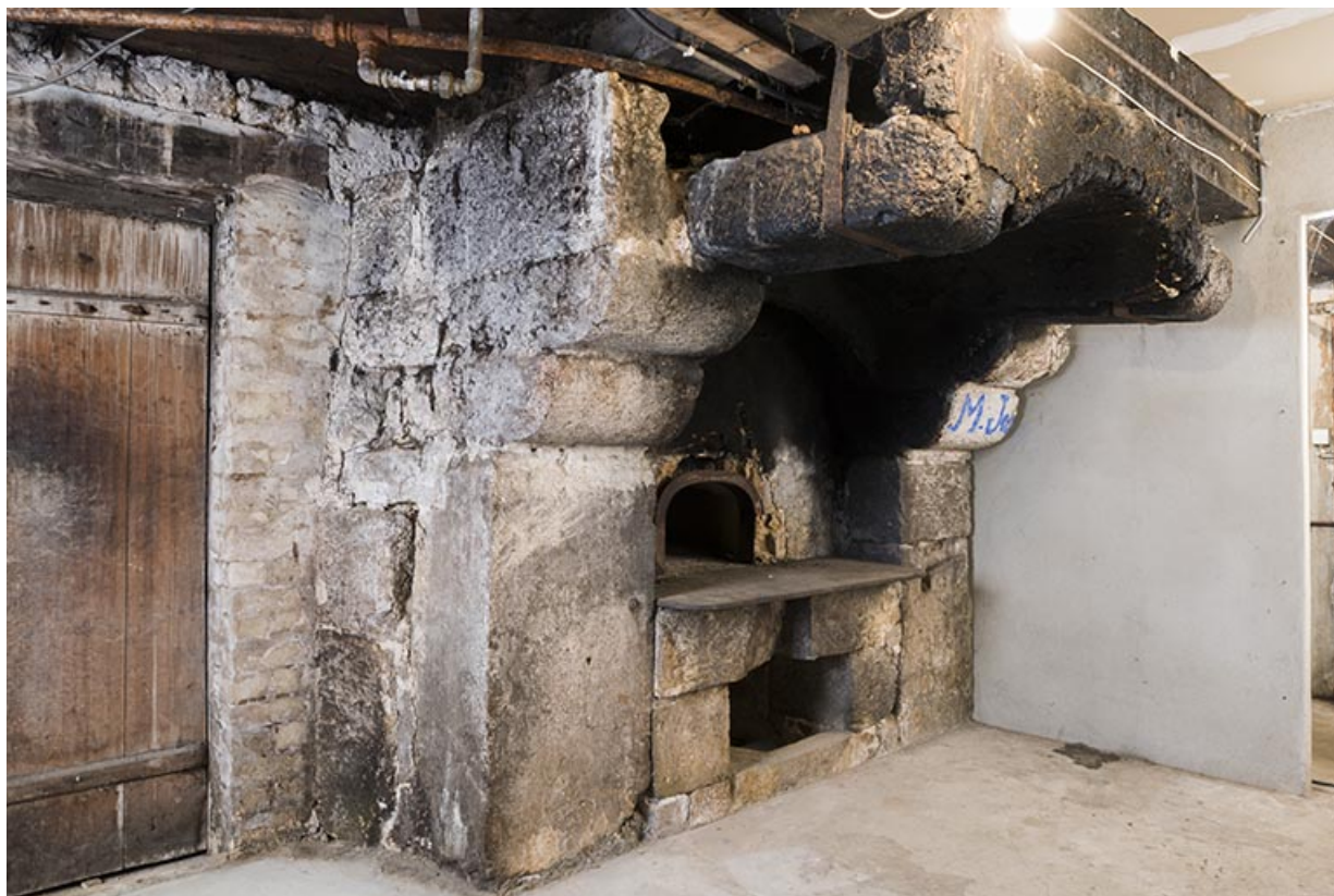
Intérieur : cheminée et four.
